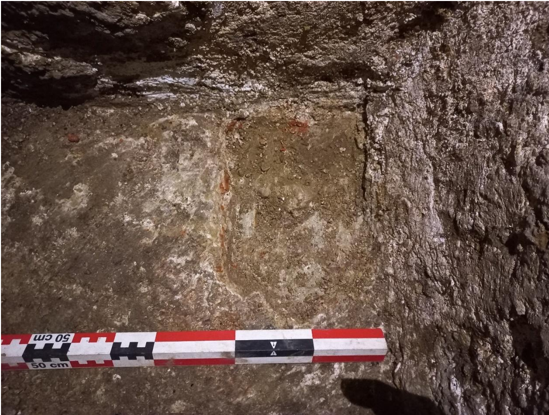
Figuur 60: Doorbreking van vloer S21: zicht op de baksteenbrokjes, kalkmortelbrokjes en kalkmortel.
