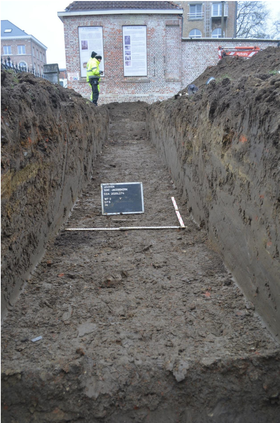
Figuur 35: Zicht op WP2 vanuit het oosten.
