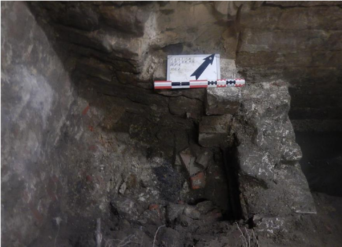
Figuur 9: Muur 84 (afgebroken trap van de toren) met dwarsmuur 83 (fundering traptoren) (© Monument Vandekerckhove).
