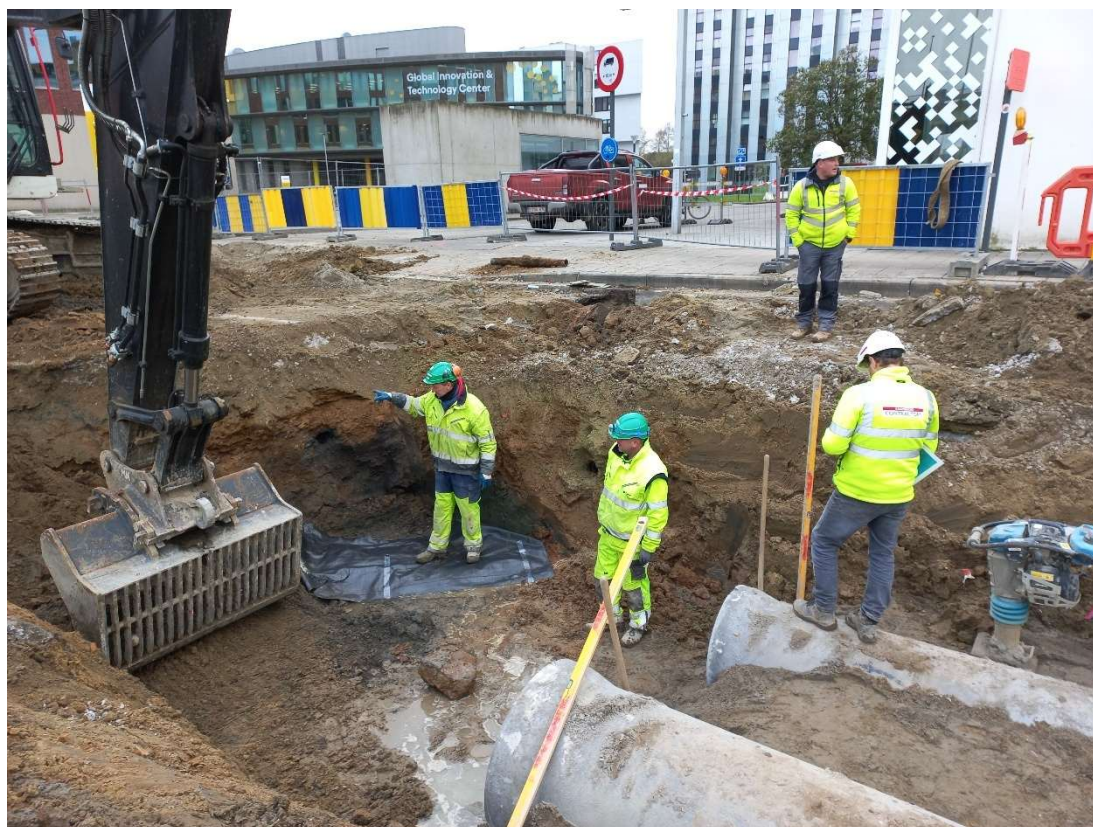
Figuur 32: In situ bewaring van S1. De fundering werd bedekt met geotextiel (onder de voeten van de persoon links op de foto), waarop de stabiliserende buffer van de riolering werd aangebracht.
