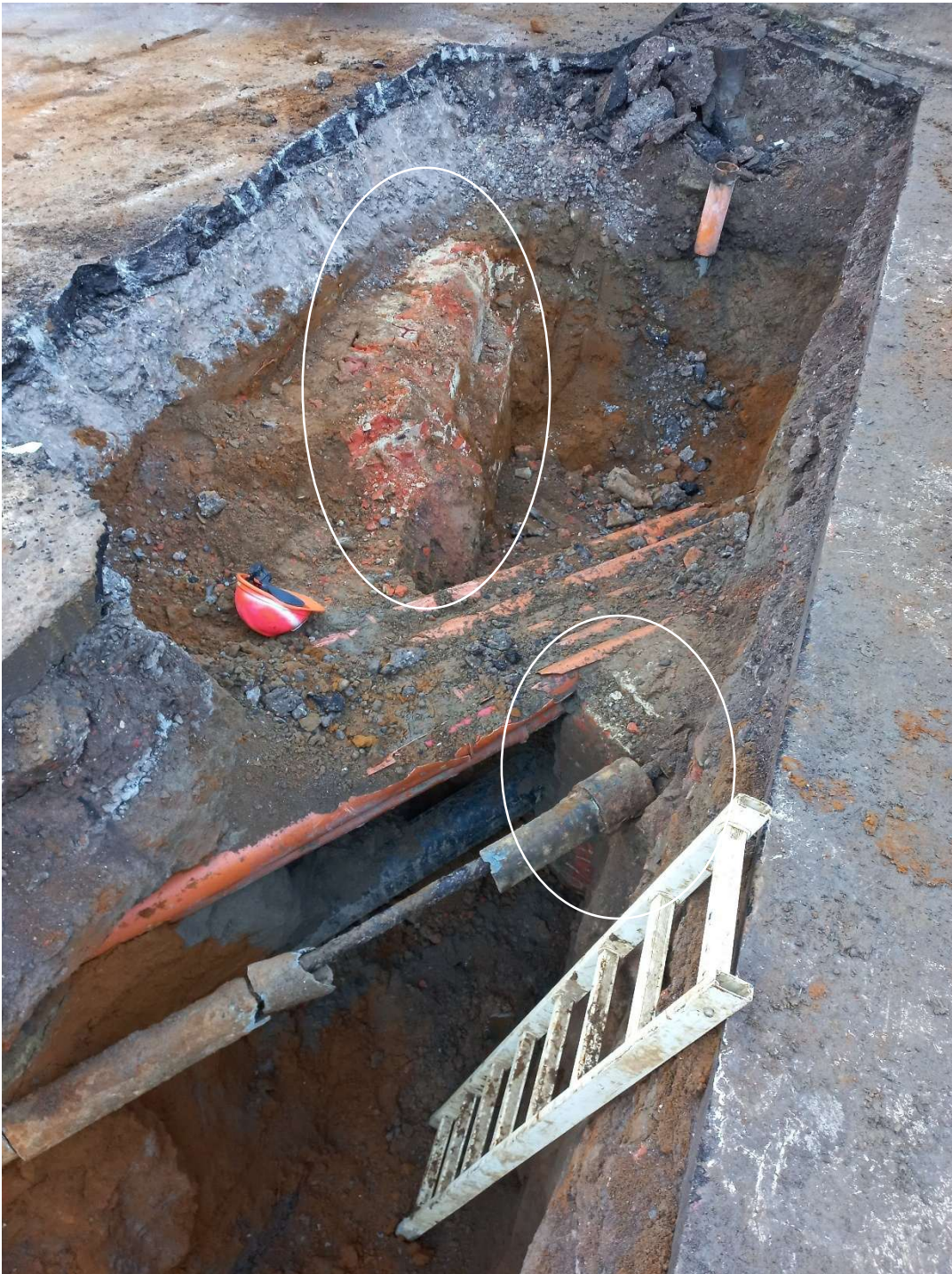
Figuur 20: foto van S5 (wit omcirkeld) tijdens de nutsleidingswerken. Foto vanuit het oosten.
