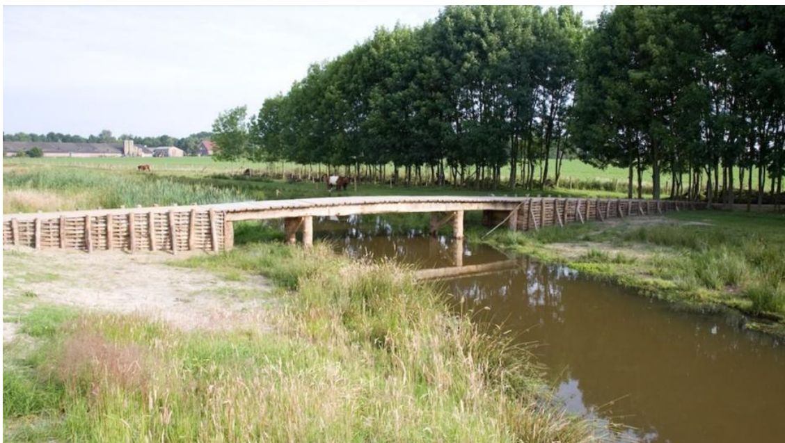
Figuur 9: Reconstructie van een Romeinse brug uit de 1ste eeuw na Chr. over de Tungelroysche Beek in Weert (Nederland) waarvan de brughoofden “in ophoging” zijn aangelegd 13
