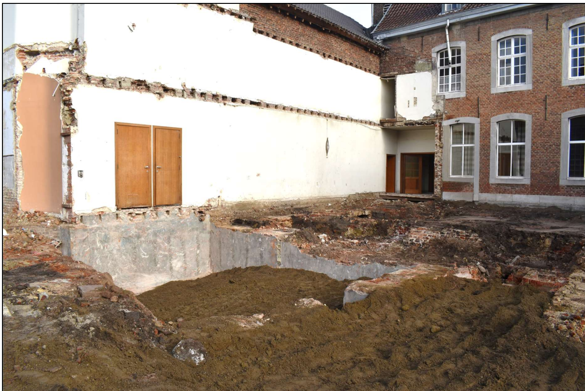
Afb. 9: Afbraak van de achterbouw en de gedempte recentere kelders waar nadien de waterputten in geplaatst werden.
