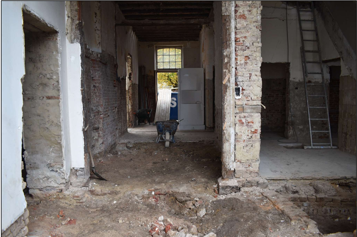
Afb. 10: Uitbraak van vloeren binnen het noordelijke kloostergebouw.
