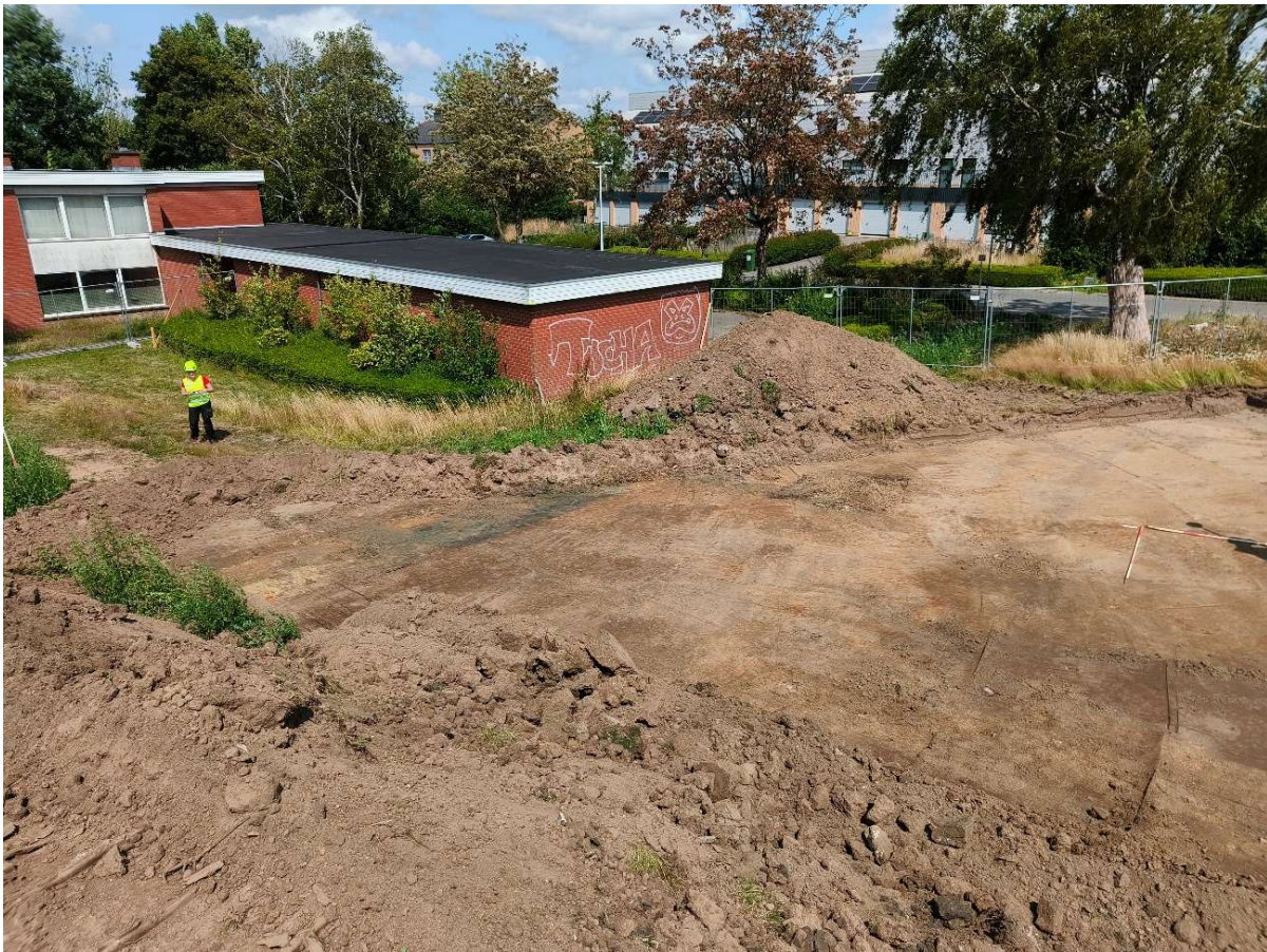
Figuur 2: Gebouw met noordelijke bufferzone met actieve nutsleidingen.
