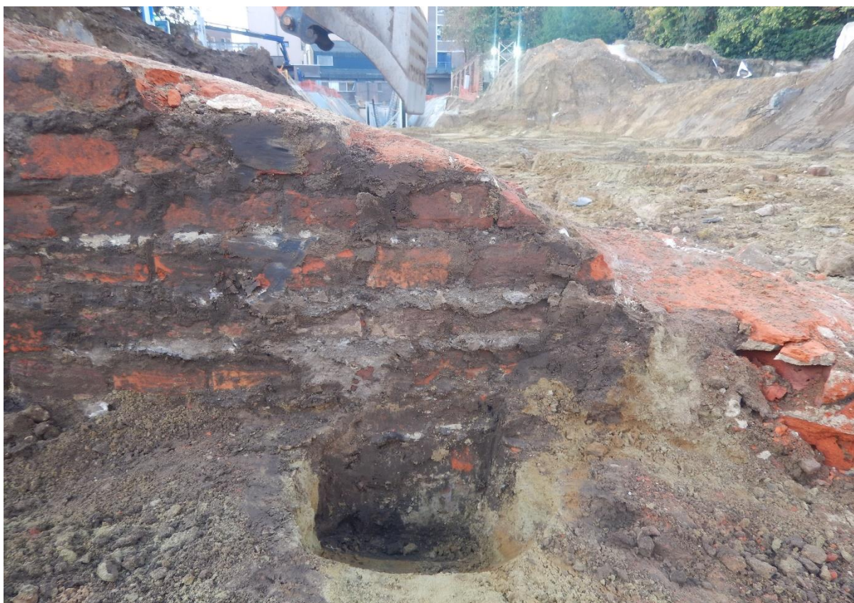
Figuur 51: Detail muur 24 met cement, vanuit het noorden.
