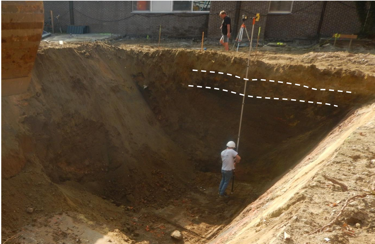
Figuur 30: Profiel 1 in zone 11.
