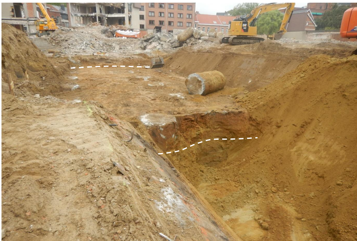
Figuur 32: zone 11, zicht vanuit het zuiden op uitgraven paalfunderingen.
