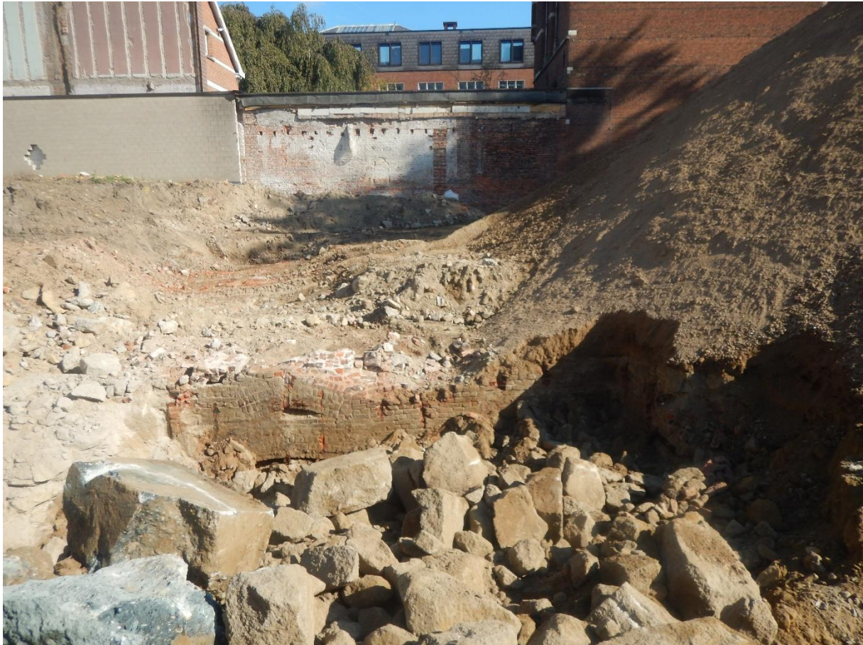
Figuur 43: Onder muur 12 werden keldergewelven, muur 25, aangetroffen.
