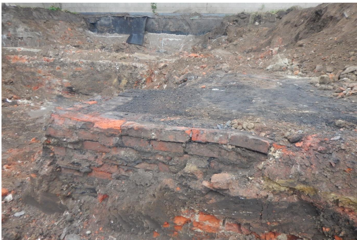
Figuur 64: Muur 36, opstaand vanuit het westen.
