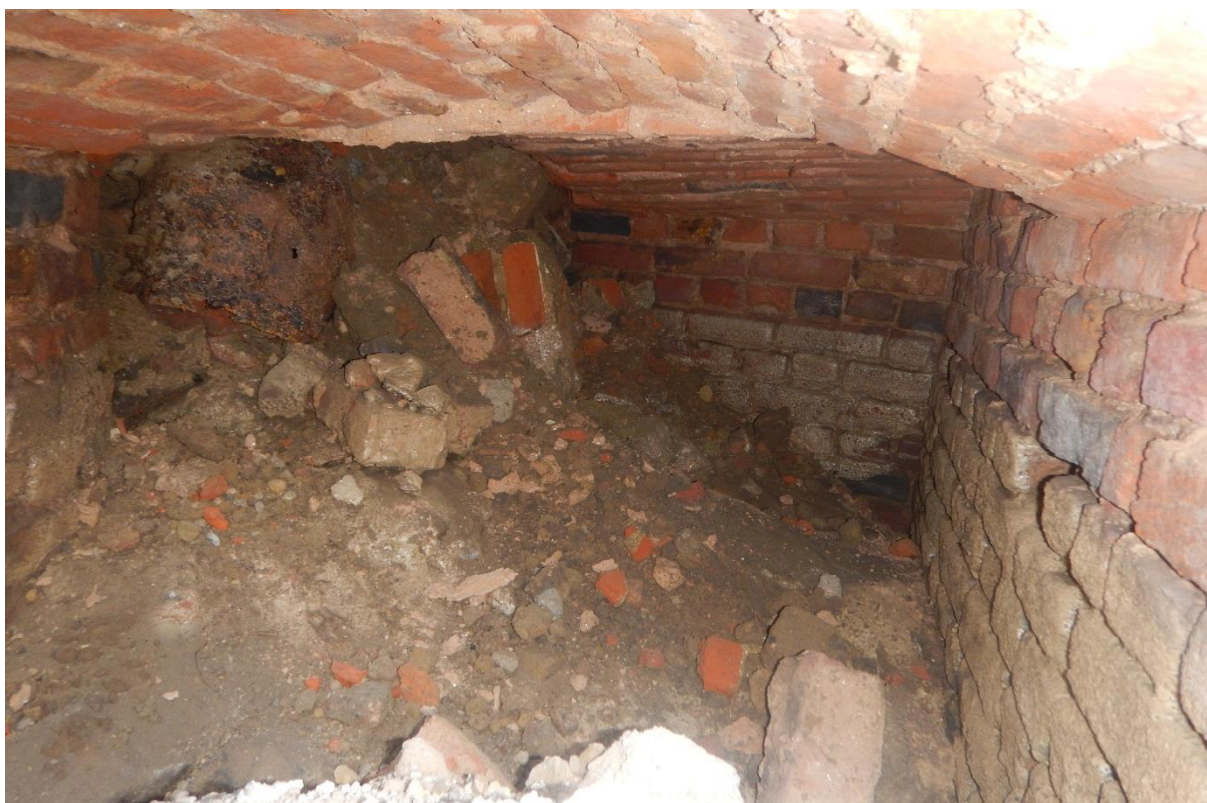
Figuur 40: Muur 9 en 10 (achteraan), bakstenen afwateringkanaal of 'tunnel', 19de-20ste eeuw.
