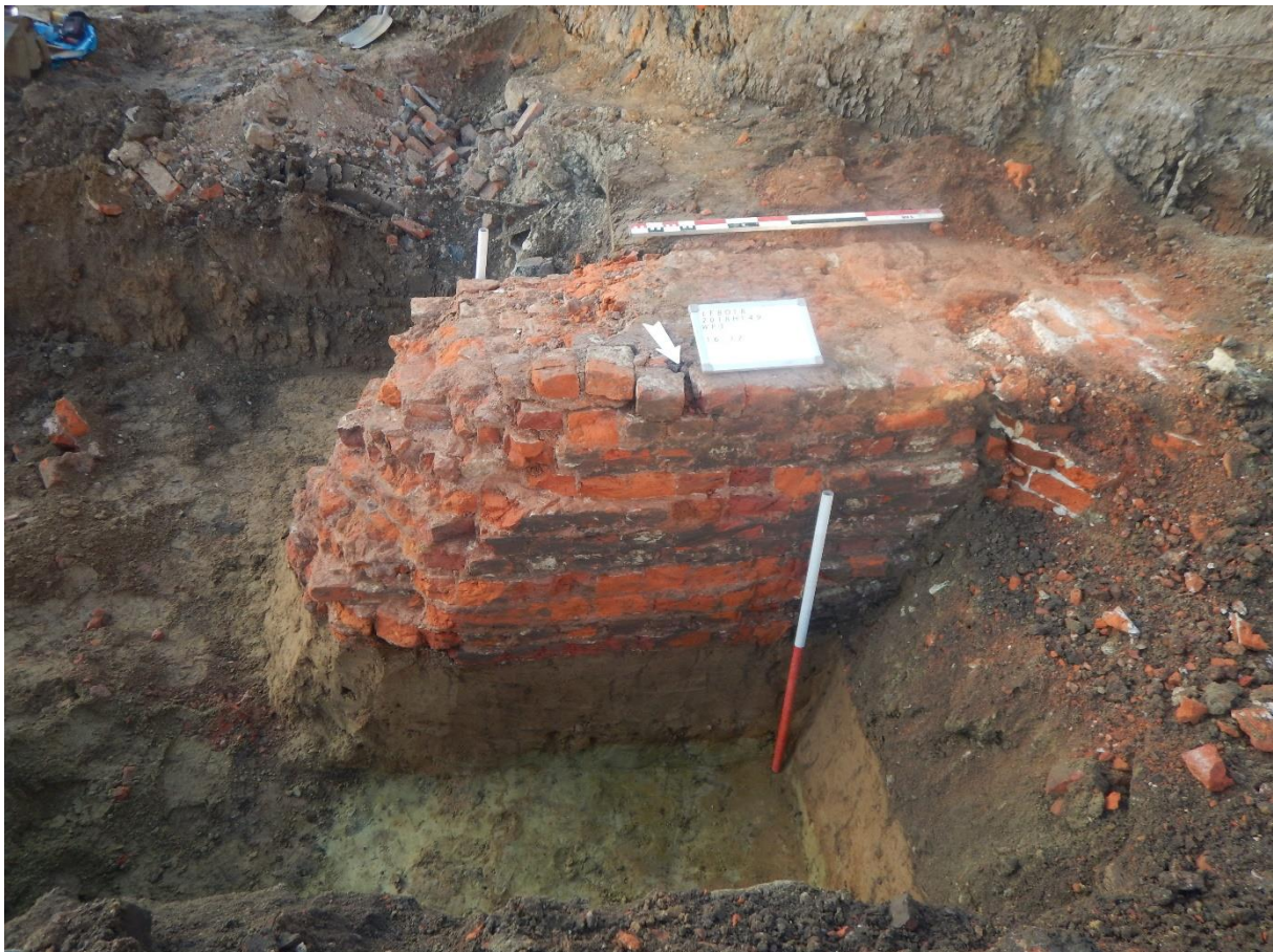
Figuur 47: Muur 16 en 17 (boven rechts) in zone 7.
