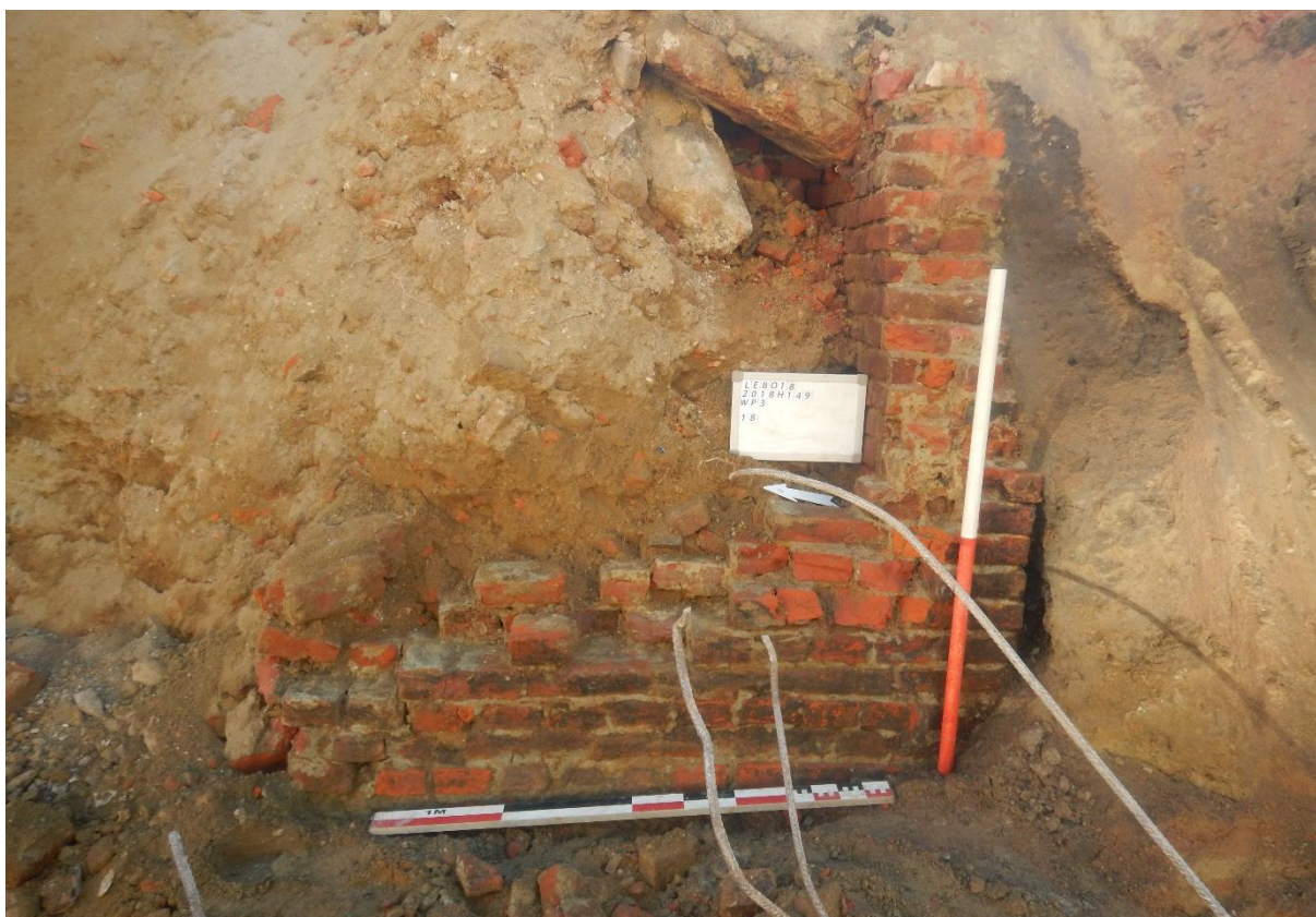
Figuur 45: muur18, kelder.
