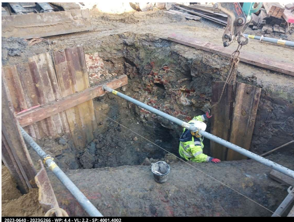
Figuur 12: In de wand van werkput 4 sporen 4001 en 4002. Op de voorgrond de bestaande riolering waarvoor het muurwerk werd weggebroken.
