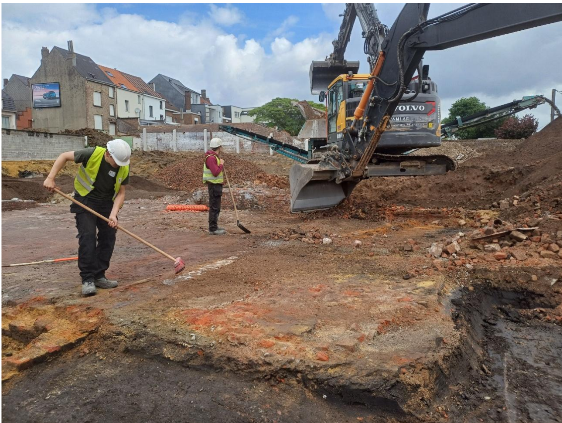
Figuur 9: Vrijleggen en opkuisen van de aangetroffen structuren
