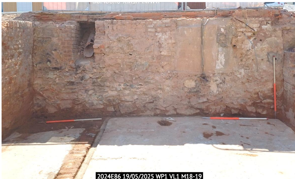
2024E86 19/05/2025 WP1 VL1 M18-19 Figuur 30: Werkput 1, vlak 1, natuurstenen muur langs de Stationsstraat in een kelder van het noordwestelijke pand (M18-19)
