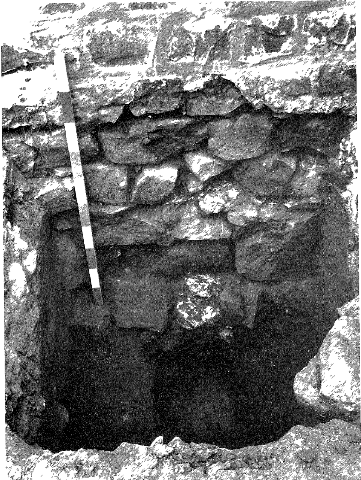
Fig. 1.4: Onderzoekput naar de funderingen in 1986 (©Doperé 1989, 45).
