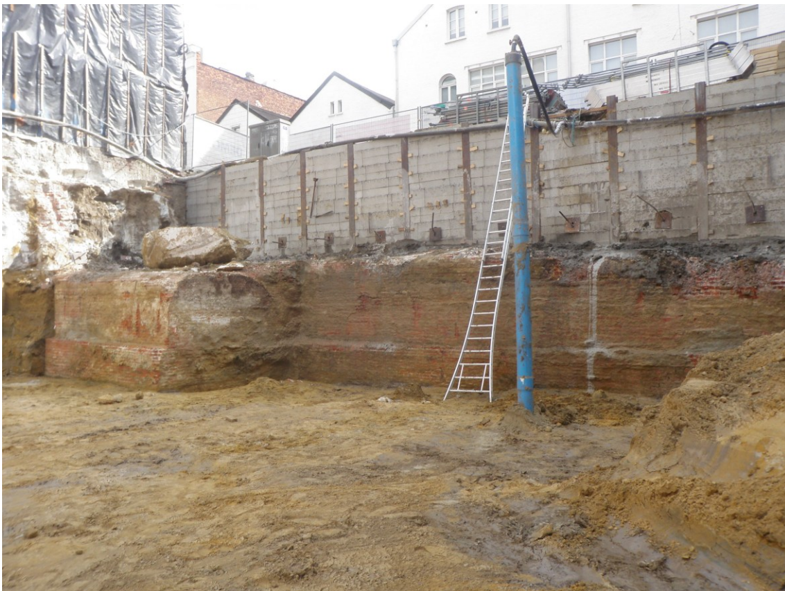
Figuur 43: Werkfoto contrescarp bij het onderzoek ten zuidwesten van het onderzoeksgebied na afbraak van het bovenste deel (Deville et al. 2014, 32, fig. 21).
