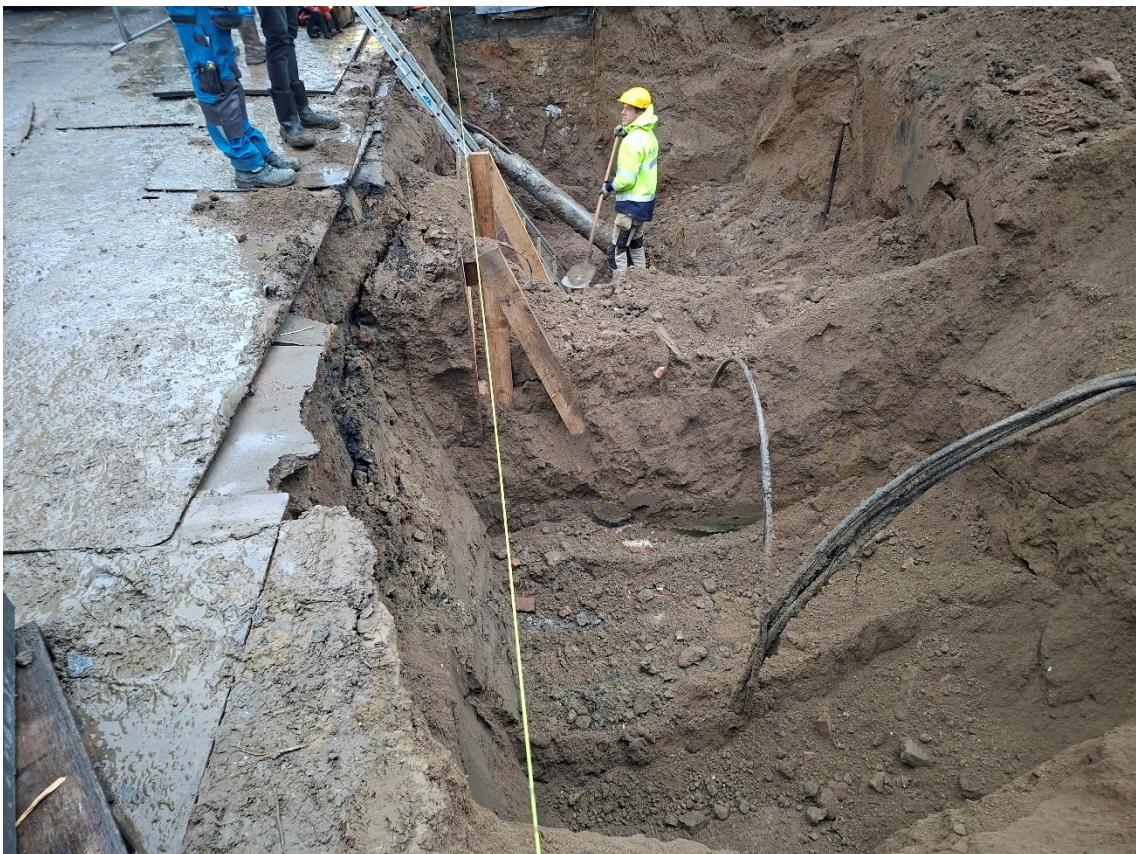
Figuur 14: Uitgraving voor het plaatsen van de beschoeiing
