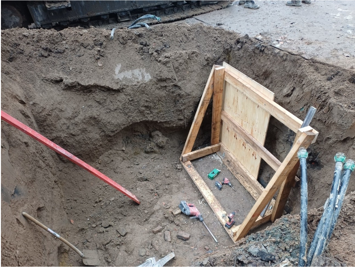
Figuur 13: Plaatsen van schoor op de contrescarp aan de straatzijde
