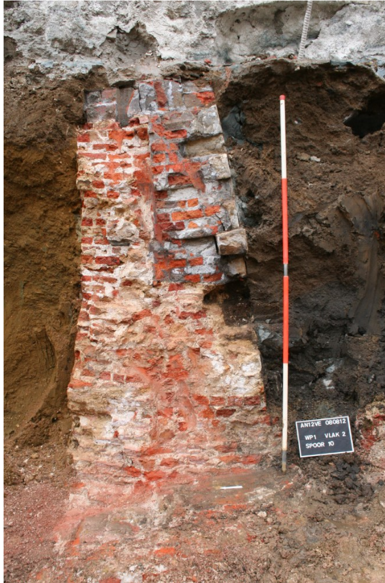
Figuur 41: Doorsnede gemaakt bij het onderzoek ten zuidoosten van het onderzoeksgebied door de contrescarp , waarin verschillende fases te herkennen zijn met aan de rechterzijde het natuurstenen parement onder de Verlatstraat (Deville et al. 2014, 52, fig. 39).
