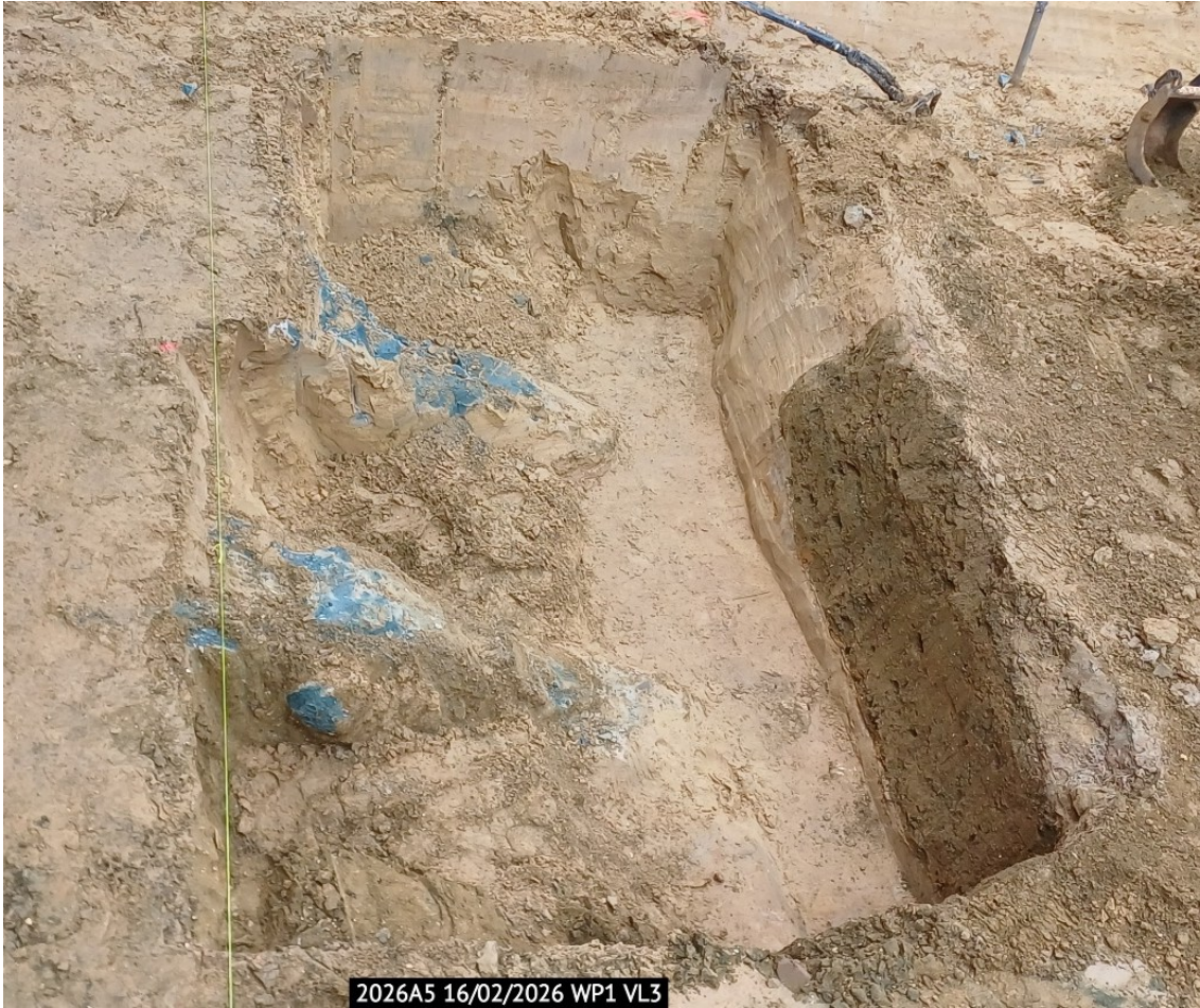
Figuur 38: Werkput 1, vlak 3, verankeringen palenwand M2 ter hoogte van uitgraving voor de liftput
