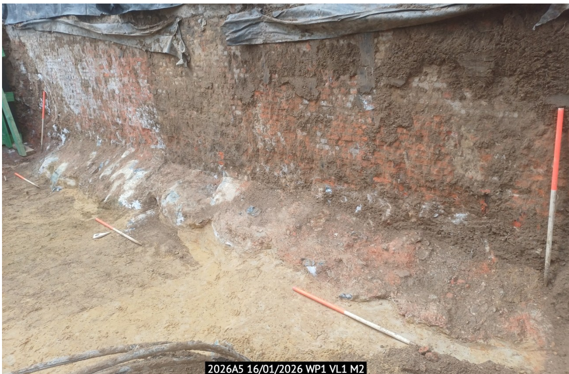
Figuur 37: Werkput 1, vlak 1, palenwand M2 aan de noordwestzijde van het onderzoeksgebied
