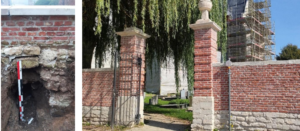
Figuur 21: Kerkhofmuur met bovenbouw in rode baksteen en onderbouw in natuursteen (links S3002).
