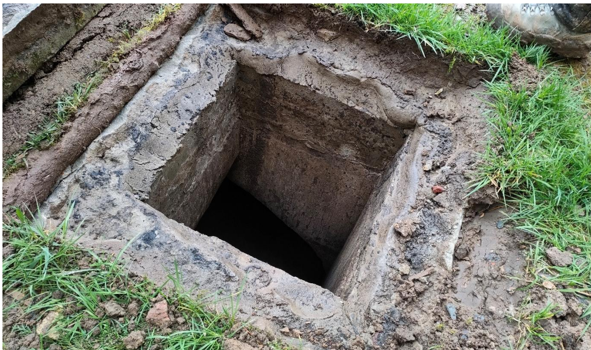
Figuur 22: Ingang kelderruimte.
