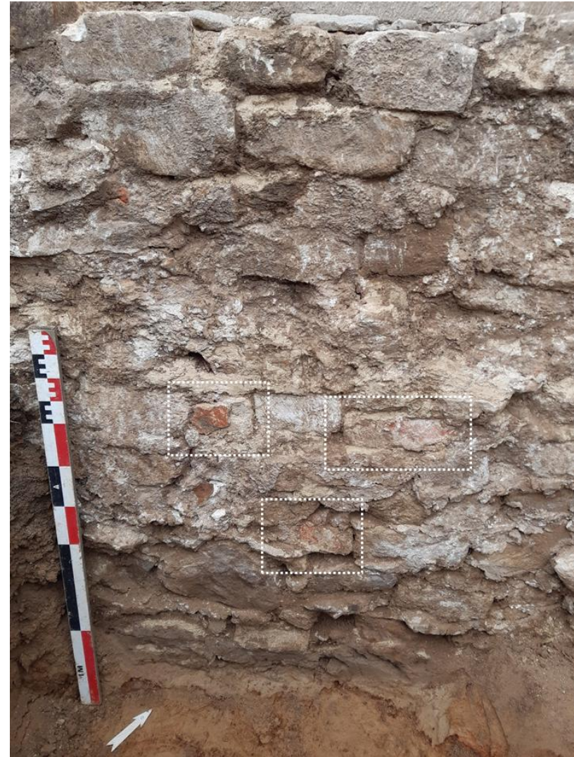
Figuur 16: Stenen met pleisterwerk in natuurstenen fundering S2001.
