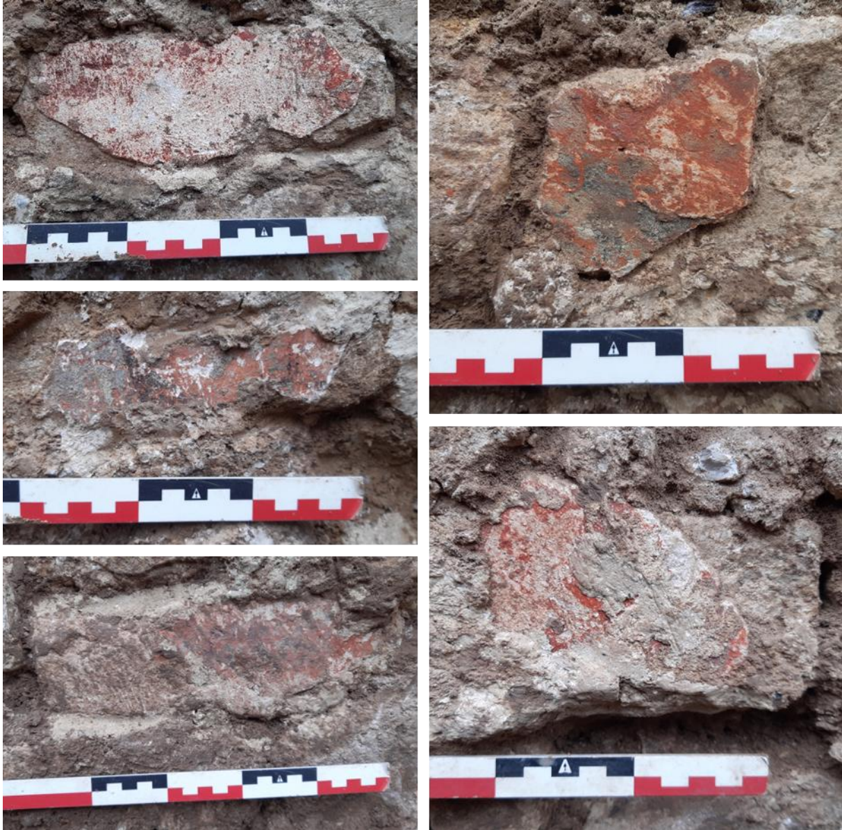
Figuur 17: Detail pleisterwerk aan de buitenzijde van de natuustenen fundering S2001.
