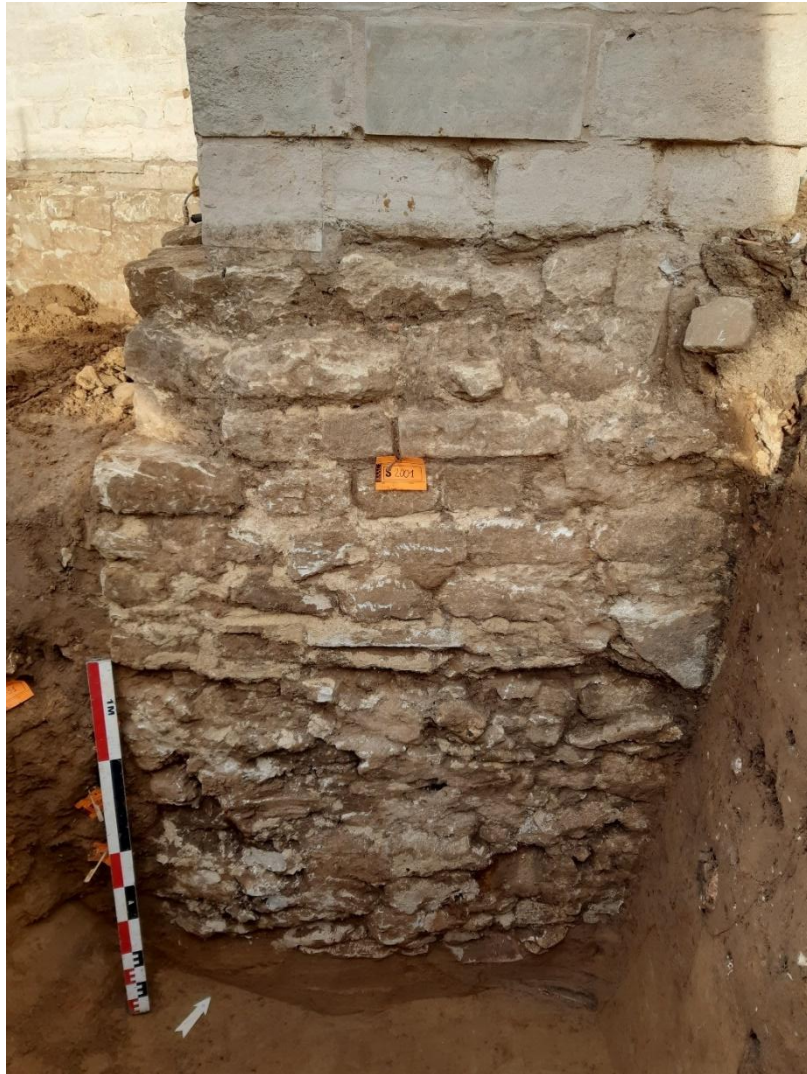
Figuur 15: Natuurstenen fundering S2001 aan de zuidzijde van de kerk.
