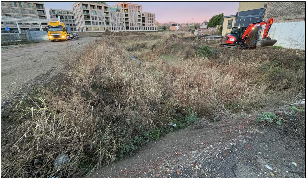
Figuur 21: De gesaneerde zone ter hoogte van de geplande ondergrondse parkeergarage op 01/12/2025. Gefotografeerd in westelijke richting.
