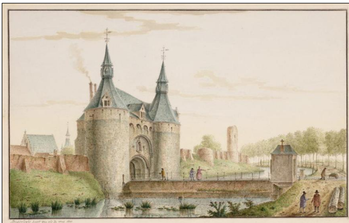
Figuur 11: Tekening van Jan Baptist De Noter met zicht van buiten de stad op de Overste poort of Nieuwe Brusselse Poort rond 1810. (Bron: Stadsarchief Mechelen, SME001001227). Men is reeds begonnen met de afbraak van de stadsmuur.
