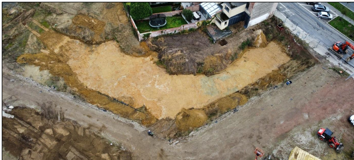
Figuur 26: Dronefoto (01/12/2025) na de aanleg van het vlak.
