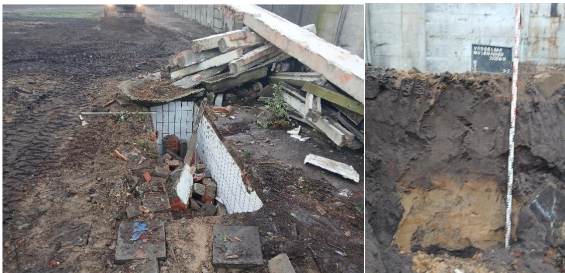
Figuur 8: Foto's van tijdens de ondergrondse sloopbegeleiding.
