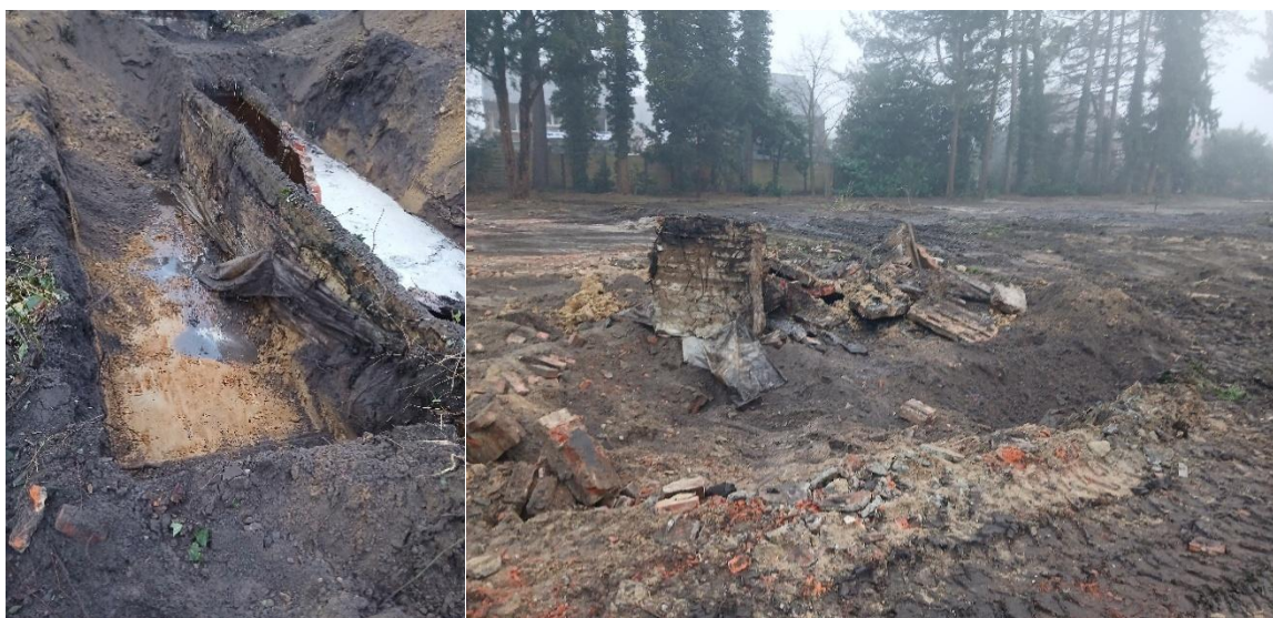
Figuur 7: Foto's van tijdens de ondergrondse sloopbegeleiding.
