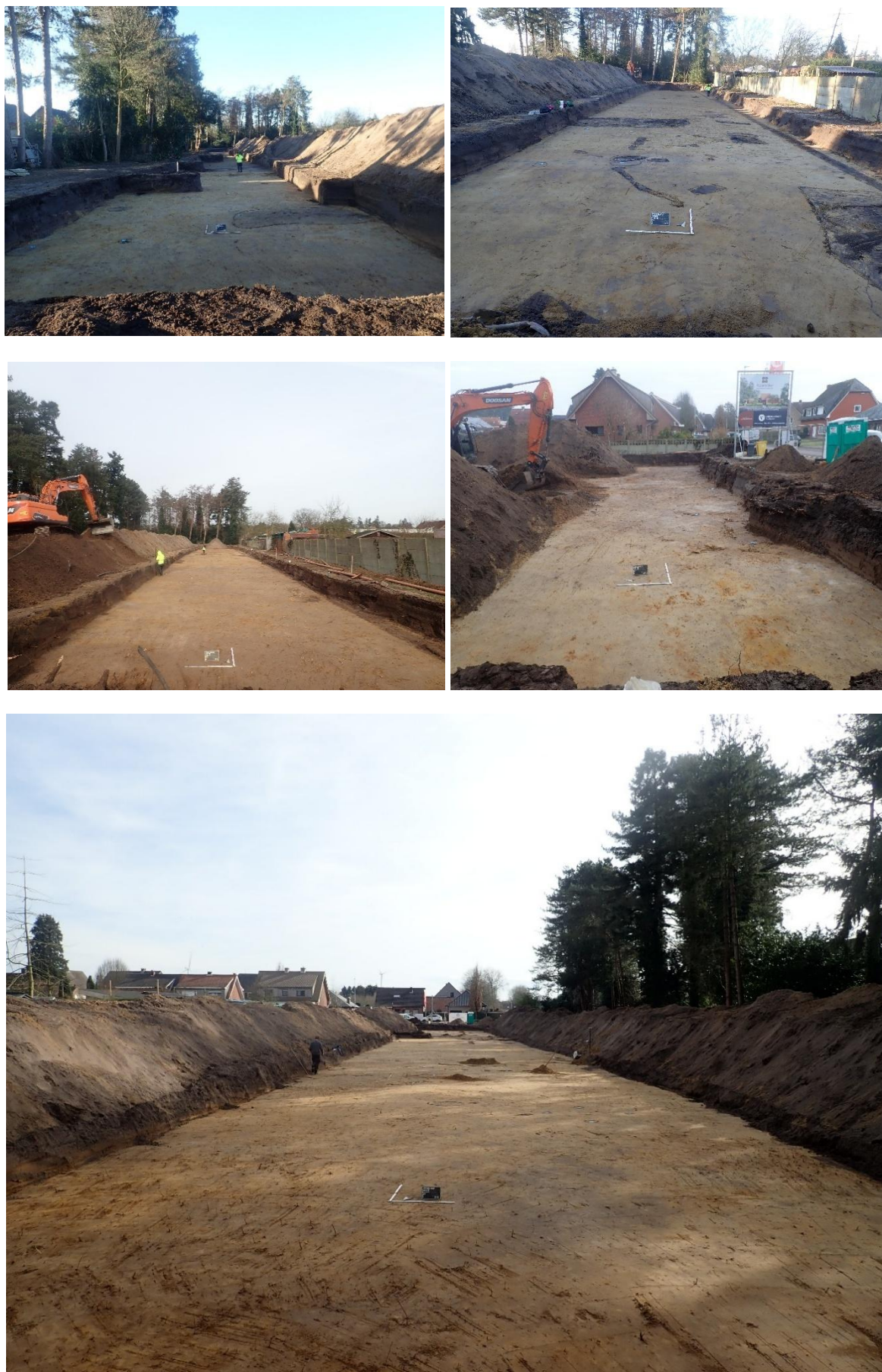
Figuur 9: Zicht op de aangelegde werkputten.
