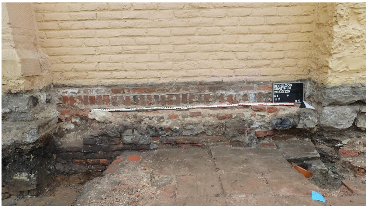
Figuur 59: Zicht op M1002 ter hoogte van de zuidgevel, westelijk deel, ten westen van M1008. De oorspronkelijke restanten bevinden zich onderaan en zijn zichtbaar achter de vloer (©INDAR bv)
