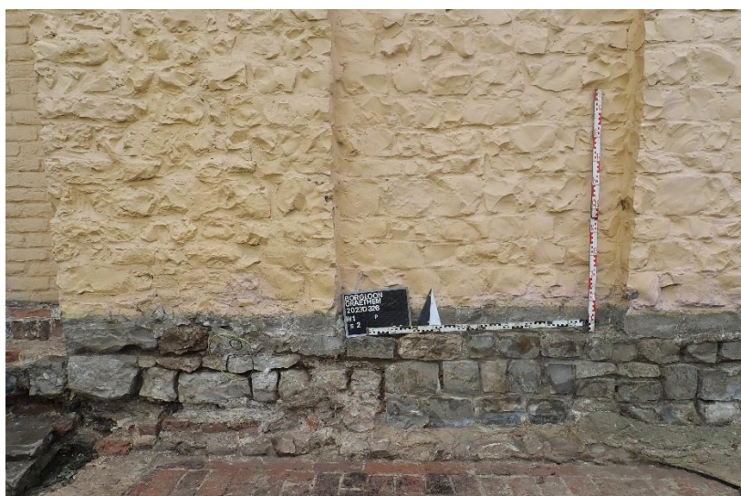
Figuur 58: Zicht op M1002 ter hoogte van de zuidgevel, oostelijk deel. De oorspronkelijke restanten bevinden zich onderaan en zijn zichtbaar achter de vloer van de 19 de -eeuwse sacristie (©INDAR bv)
