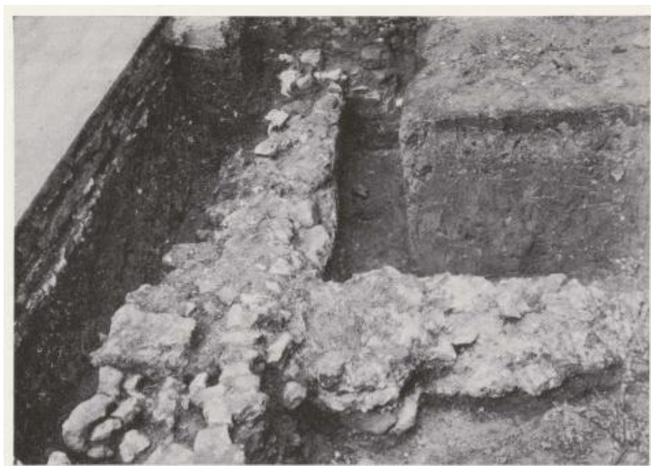
Figuur 18: Fundering van de afgebroken zuidelijke (gotische) zijbeuk zoals aangetroffen tijdens de opgravingen (©Bussels. & Lux 1970; Afb. 20, p. 202)
