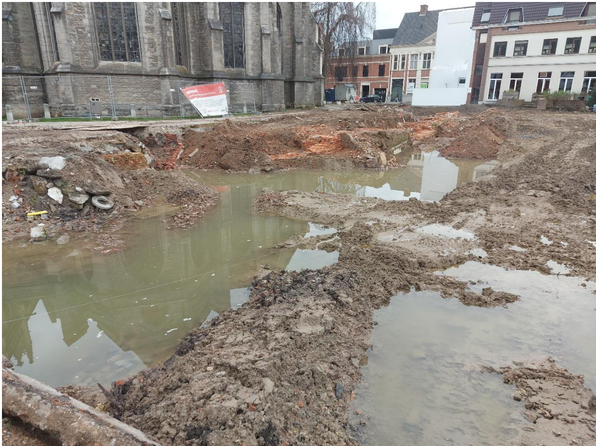
Figuur 7: Het vele regen- en grondwater maakte kwaliteitsvol archeologisch onderzoek in het voorjaar van 2024 onmogelijk. Er diende eerst bemaling te worden geplaatst zodat het terrein wat meer zou kunnen uitdrogen.
