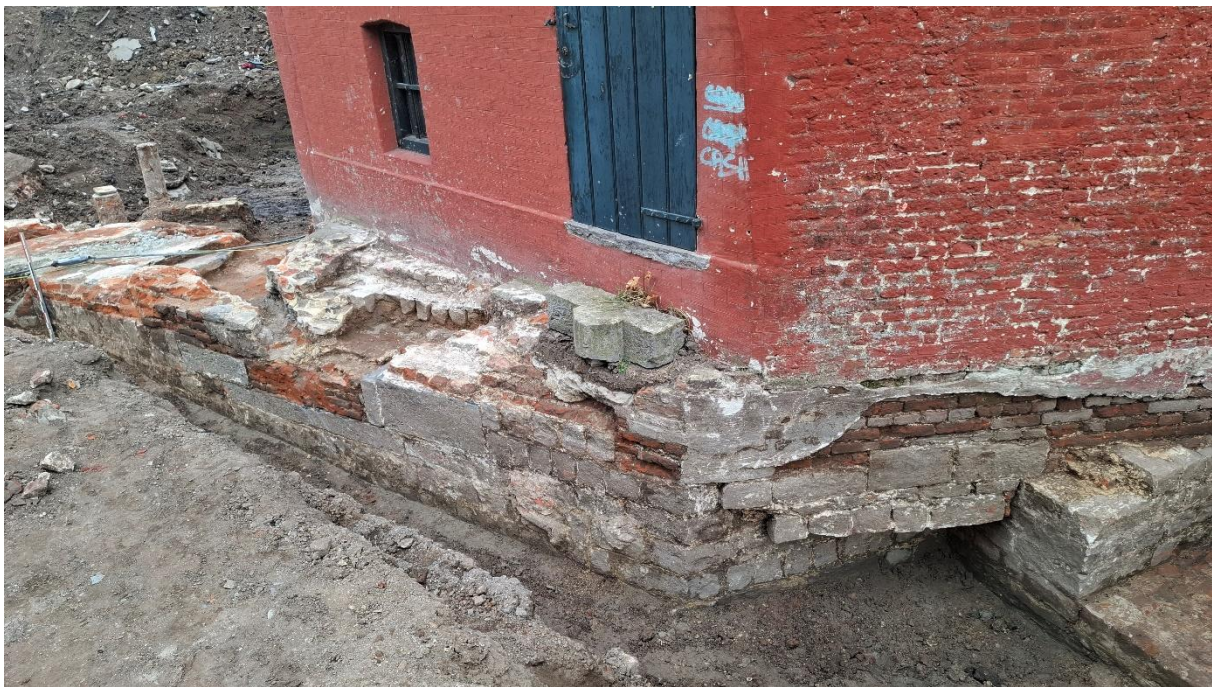
Figuur 72: Aansluiting van de originele weermuur (waarin reeds elementen vervat zitten van de Bourgondische stadsomwalling) met de zuidelijke – reeds gerestaureerde weermuur, onder de bovenbouw van de huidige Artillerietoren.
