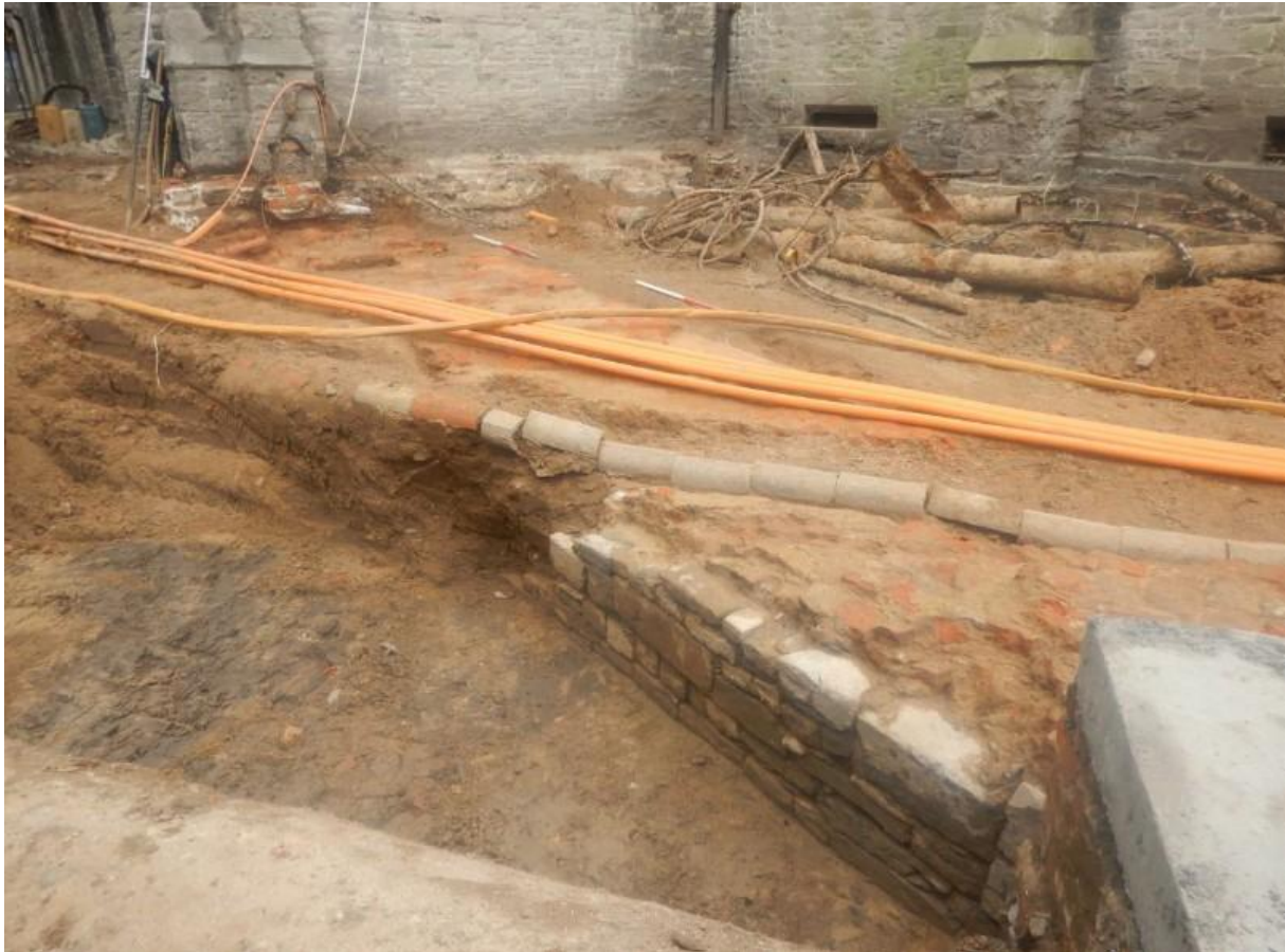
Figuur 43: Voorbeeld van het aangetroffen muurwerk uit fase 1 van de opgraving door Ruben Willaert nv (BOT B., VAN DORPEL A., VANBRABANT E., PIJPELINK A., 2024, p. 55).
