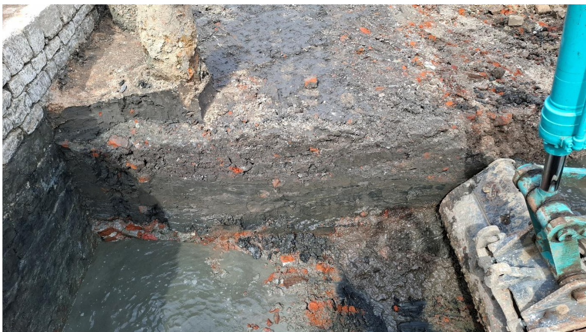
Figuur 32: Het nog overvloedig in de puinlagen vastzittende grondwater bemoeilijkt de registratie zeer. Daarbij kwam de oudere onderliggende baksteenpuinlaag, waarin bakstenen van 28x13x6cm vervat zaten, meteen onder water.
