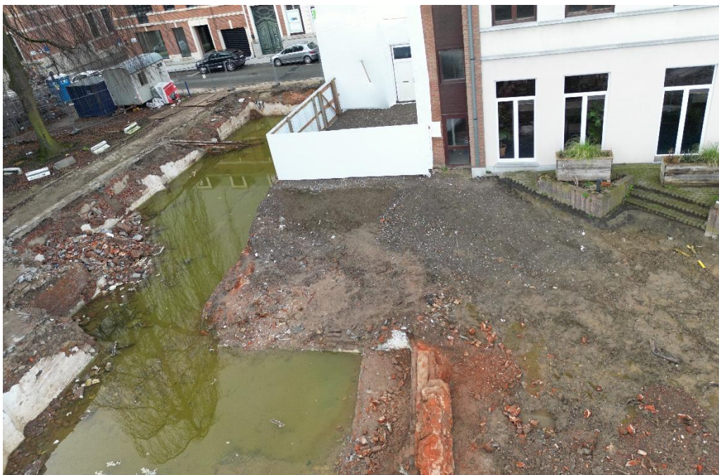
Figuur 5: Zicht vanuit het zuiden op de zone voor werfbegeleiding met de grote diepe kelder onder water.
