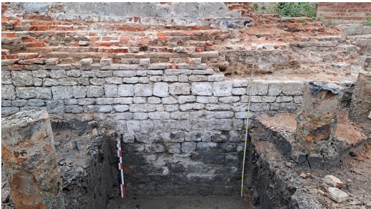
Figuur 42: Maximaal zicht op de weermuur bij het plaatsen van profiel 4 met detail van de opbouw van het natuurstenen parament aan de oostelijke buitenzijde van de weermuur. De bovenste 6 rijen zijn opgebouwd met beigewitte kalkzandstenen, gekapt in vierkante maar ook in dunne rechthoekige blokken, en de onderste 6 rijen vervaardigd uit lichtgrijze harde natuurstenen, gekapt in regelmatige vierkante blokken en samengehouden door een zeer harde mortel.
