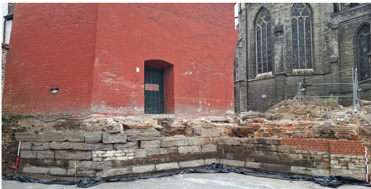
Figuur 56: Zicht op de oostzijde van de huidige Artillerietoren. Die is hier hoofdzakelijk opgebouwd met grote (hergebruikte?) rechthoekige blokken doornikse kalksteen die wellicht met de bouw van de Bourgondische stadsomwalling (1411-1454) geassocieerd kunnen worden.
