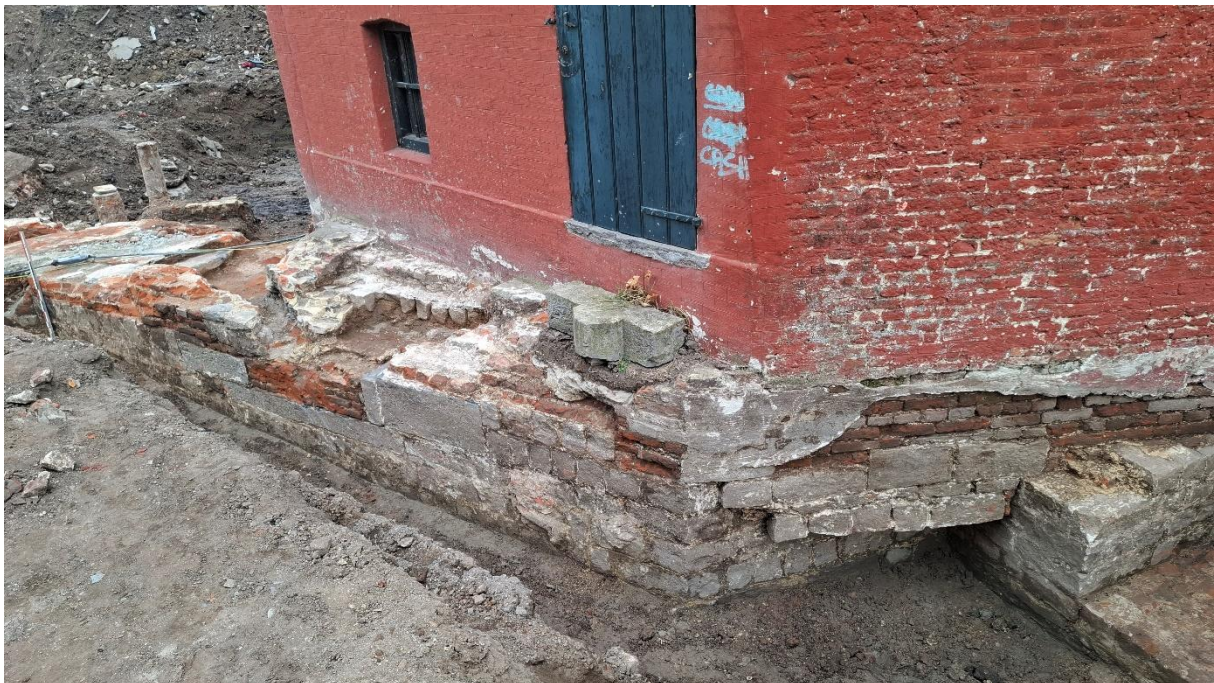
Figuur 55: Zicht op het stuk (weer)muur ten noorden van de Artillerietoren. Enkel grote blokken doornikse kalksteen liggen op de originele kleinere vierkante natuurstenen blokken (van Grès de Béthune) van de weermuur. De bovenbouw van deze muur werd tijdens de bouw van de Bourgondische stadsomwalling vermoedelijk dus hersteld.
