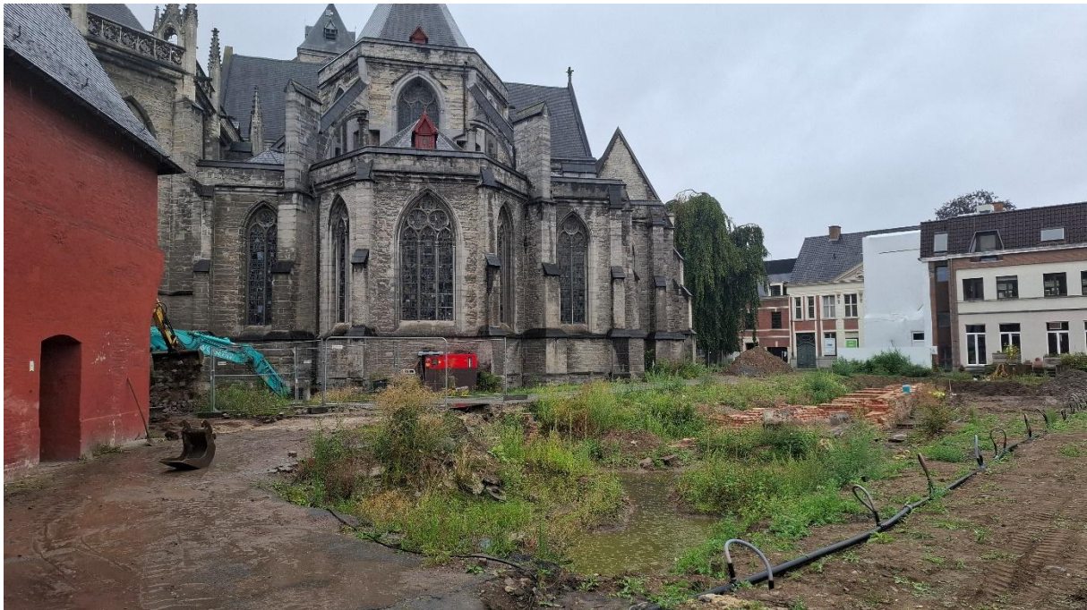
Figuur 8: Zicht op de staat van het terrein op de dag van aanvang van de tweede grote opgravingsfase in augustus. De bemaling op de voorgrond en redelijk wat regenwater in de reeds gegraven put in het zuiden.
