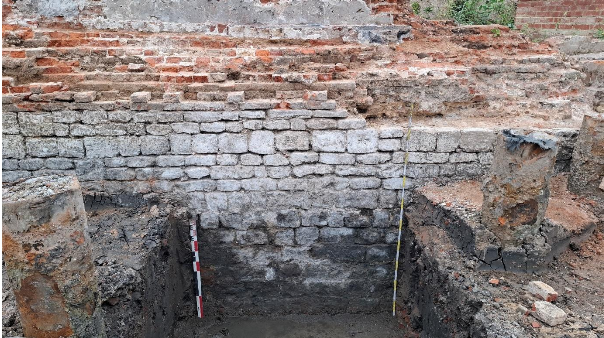
Figuur 71: Maximaal beeld op het natuurstenen parement aan de oostelijke buitenzijde van de weermuur. De bovenste 6 rijen zijn opgebouwd met beigewitte kalkzandstenen, gekapt in vierkante maar ook in dunne rechthoekige blokken, en de onderste 6 rijen vervaardigd uit lichtgrijze harde natuurstenen, gekapt in regelmatige vierkante blokken en samengehouden door een zeer harde mortel.
