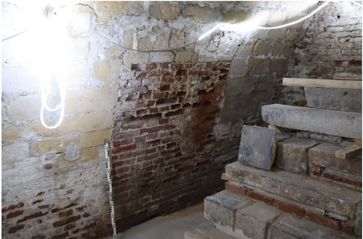
Fig. 3.42: Ietwat verborgen deuropening achter de trap in de zuidelijke muur van de oostelijke kelder.
