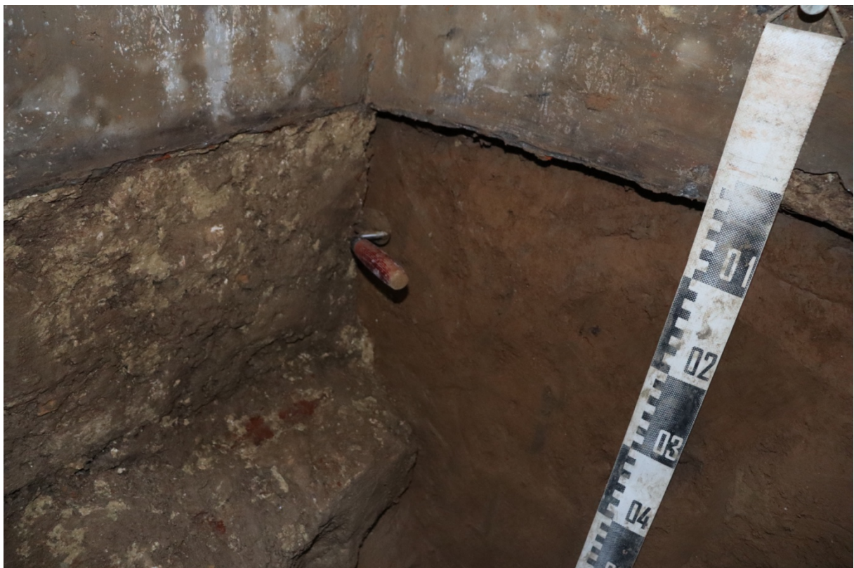
Fig. 3.30: De funderingsmuur (S4) stop aan de noordelijke keldermuur.
