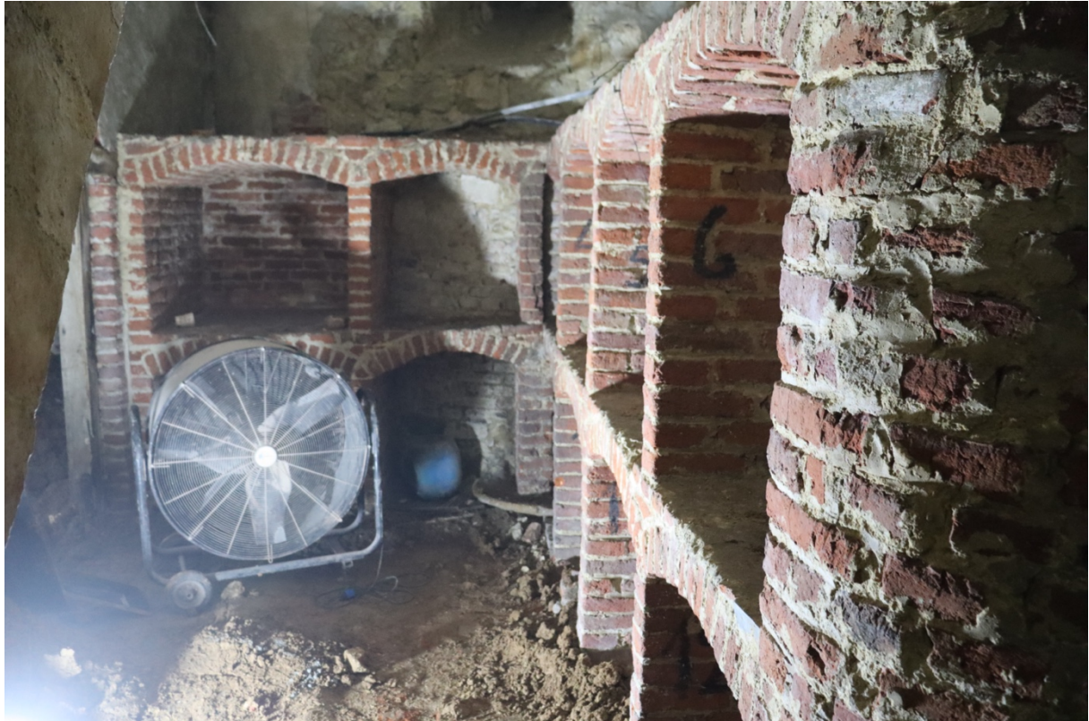
Fig. 3.26: Keldermuurtjes tegen de westelijke keldermuur voorafgaande de afbraak.
