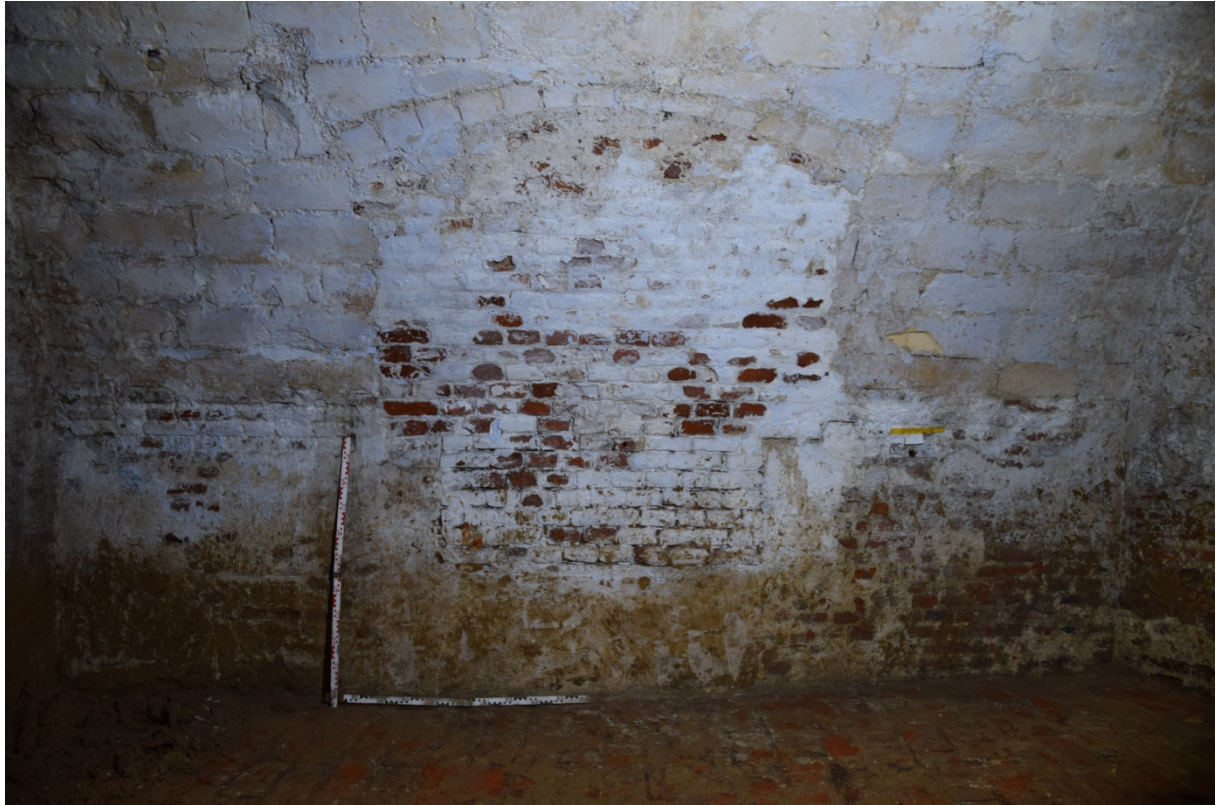
Fig. 3.40: Dichtgemaakte raamopening in de zuidelijke muur van de westelijke kelder.
