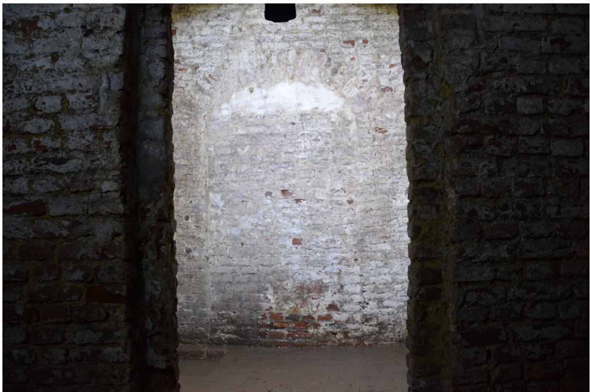
Fig. 3.41: Dichtgemaakte deuropening in de zuidelijke muur van de centrale kelder.
