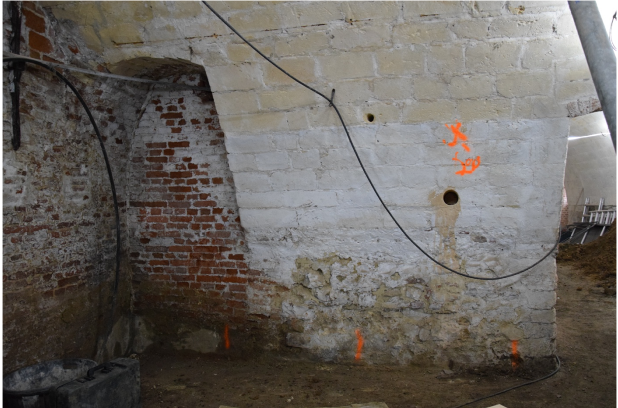
Fig. 3.38: Dichtgemaakte deuropening in de noordelijke muur van de oostelijke kelder.
