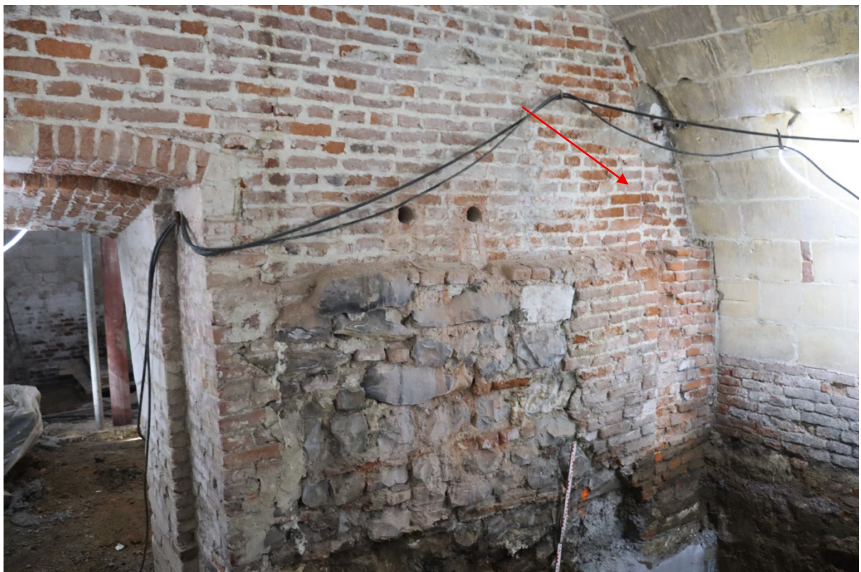
Fig. 3.39: Dichtgemaakte deuropening aan de andere kant van de muur.
