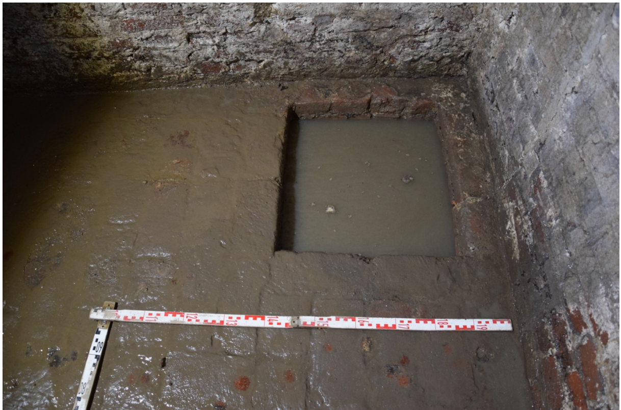
Fig. 3.23: Vierkantig gat in de centrale keldervloer.
