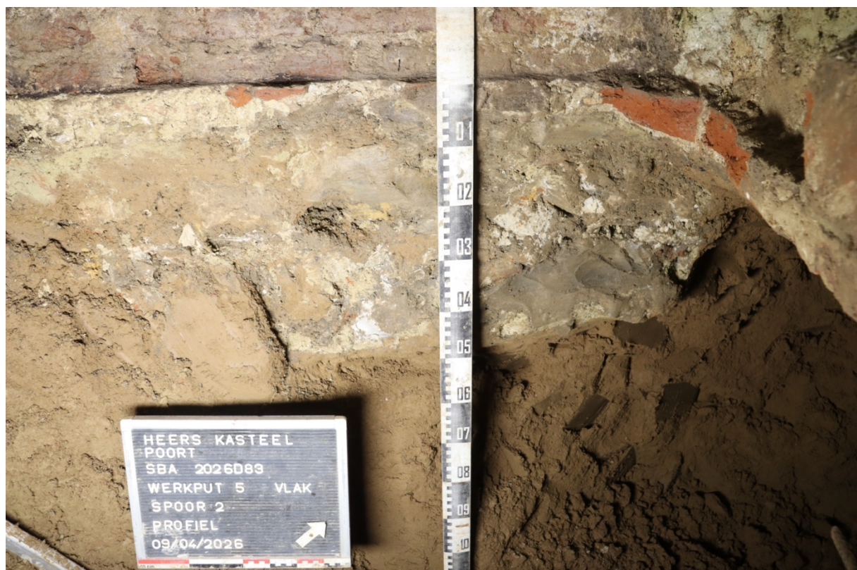
Fig. 3.28: Silexfundering onder de bakstenen keldermuur.
