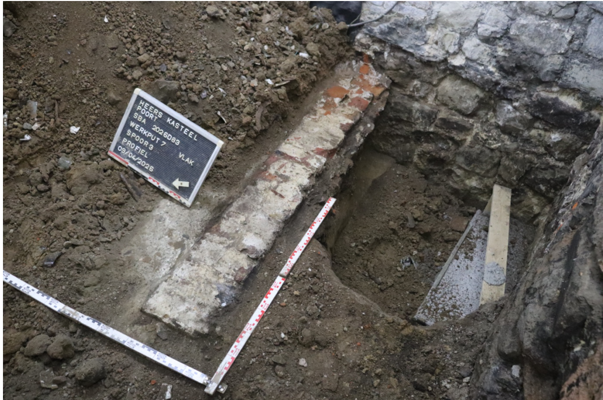
Fig. 3.32: Recentere muur, gebouwd tegen de keldermuur.
