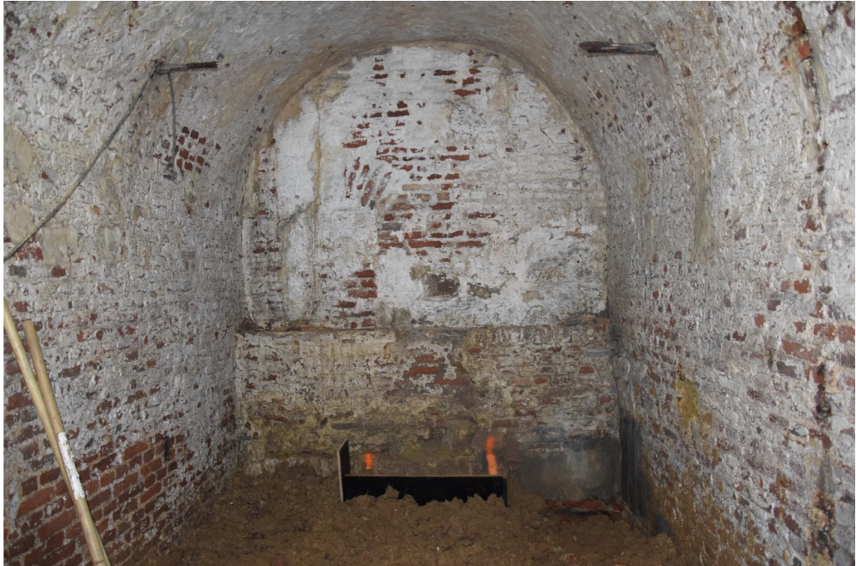
Fig. 3.36: Dichtgemaakte raamopening in de noordelijke muur van de centrale kelder.
