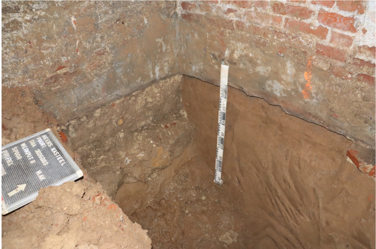
Fig. 3.29: Verstek in de bestaande keldermuur.
