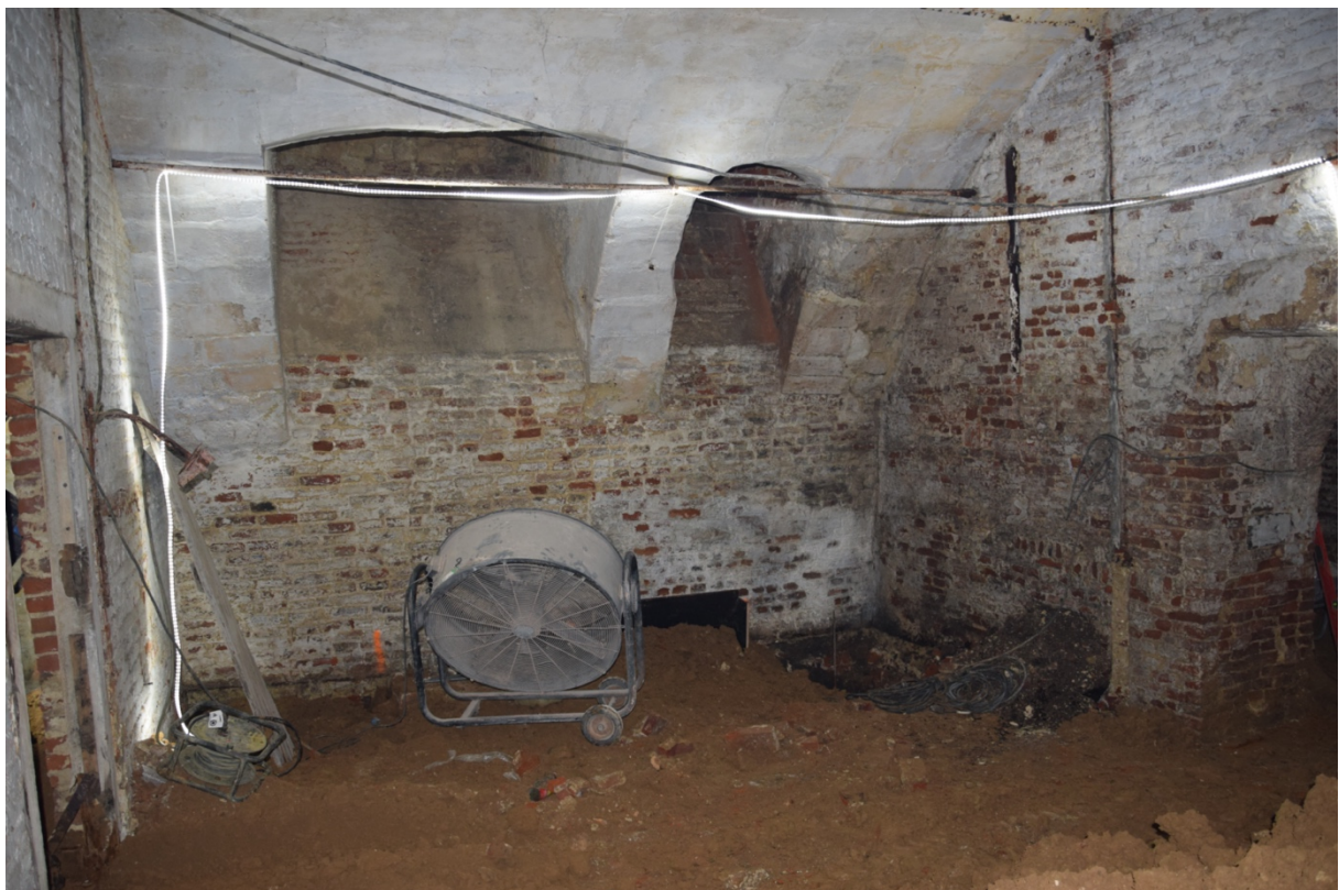
Fig. 3.37: Nog bestaande verticale raamopening in de noordelijke muur van de westelijke kelder.
