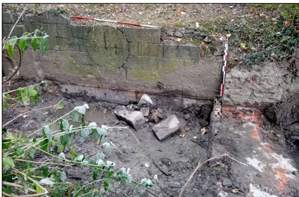
Figuur 15: Kademuur langs de waterloop (S1003) opgebouwd in natuursteen, de mogelijke aanhechting van een rad is nog zichtbaar.
