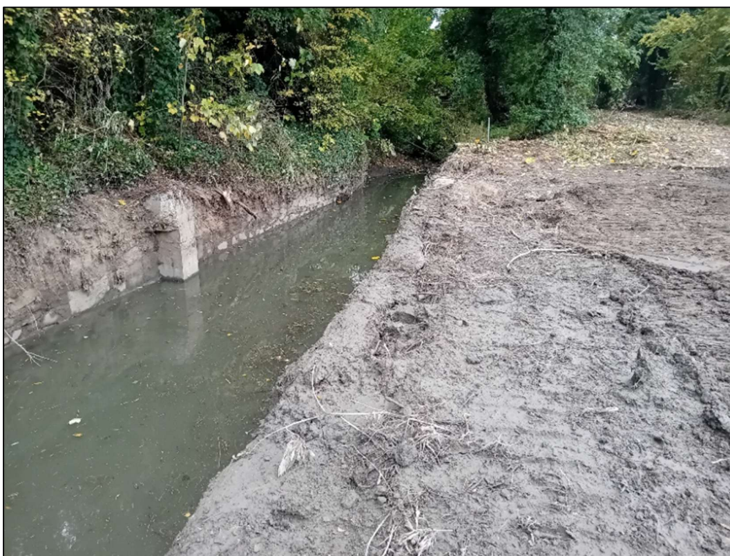
Figuur 24: Kademuren opgetrokken in gewapend beton.
