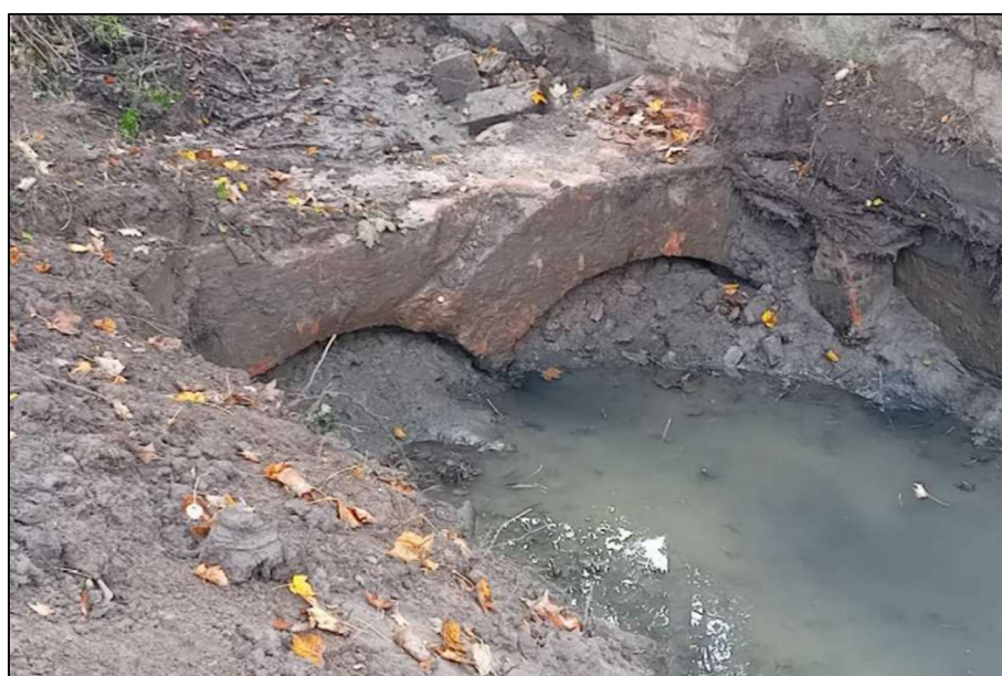
Figuur 16: Muur met gewelf (S1005) opgetrokken in rode baksteen in de waterloop.
