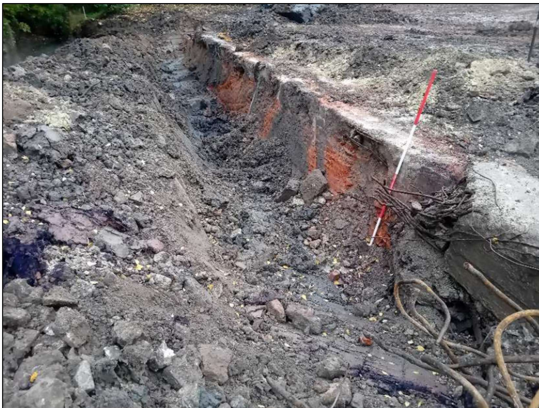
Figuur 23: Fundering S1006 bestaande uit rode baksteen met bovenaan gewapend beton.
