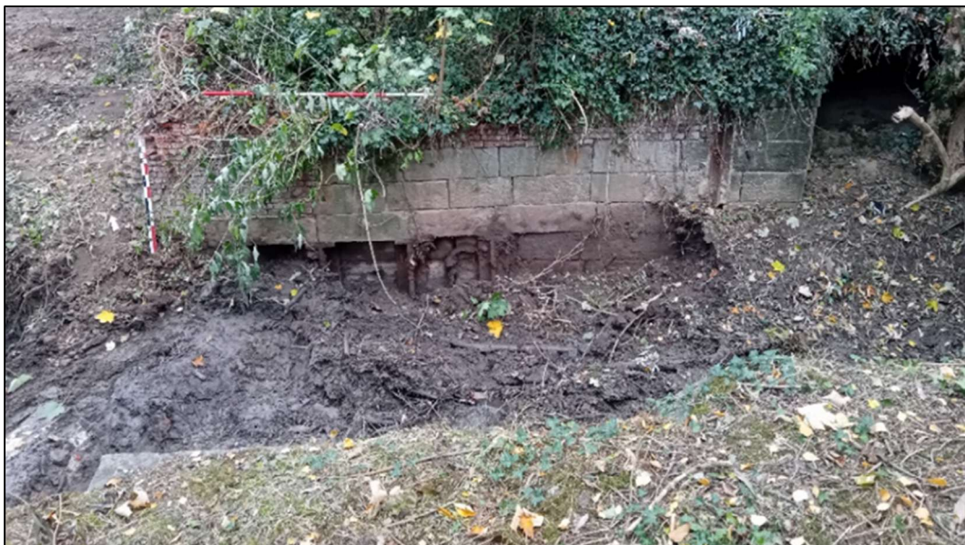
Figuur 14: Kademuur langs de waterloop (S1002) opgetrokken in natuursteen.
