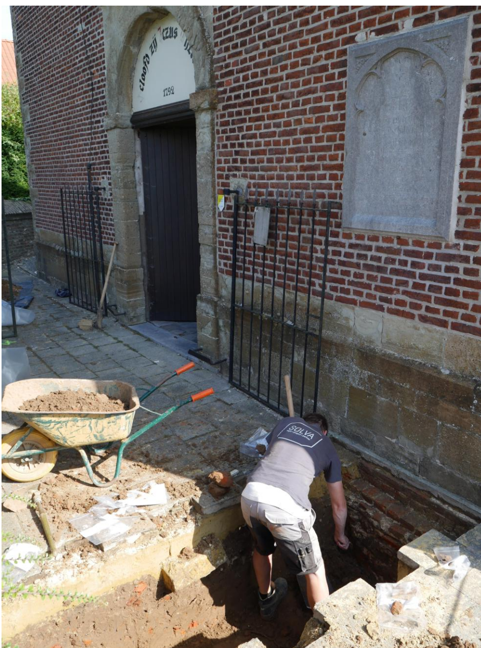
Foto 1: Zicht op zone I, de onderzoekspuit buiten aan de westelijke gevel.
