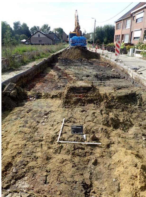
Figuur 71: Vlakfoto Werkput 1.
