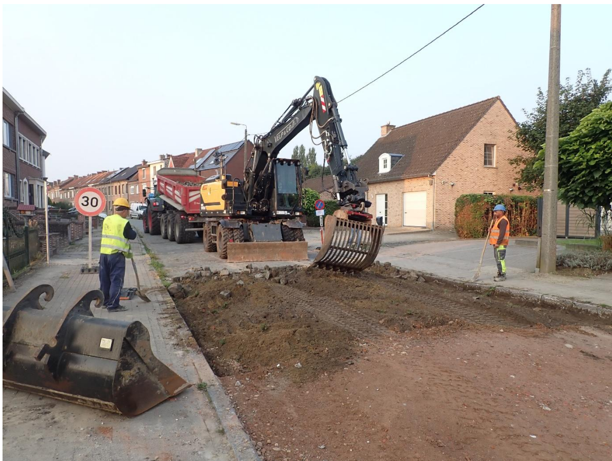
Figuur 3: Foto van de uitvoering op het terrein bij het verwijderen van verhardingen.
