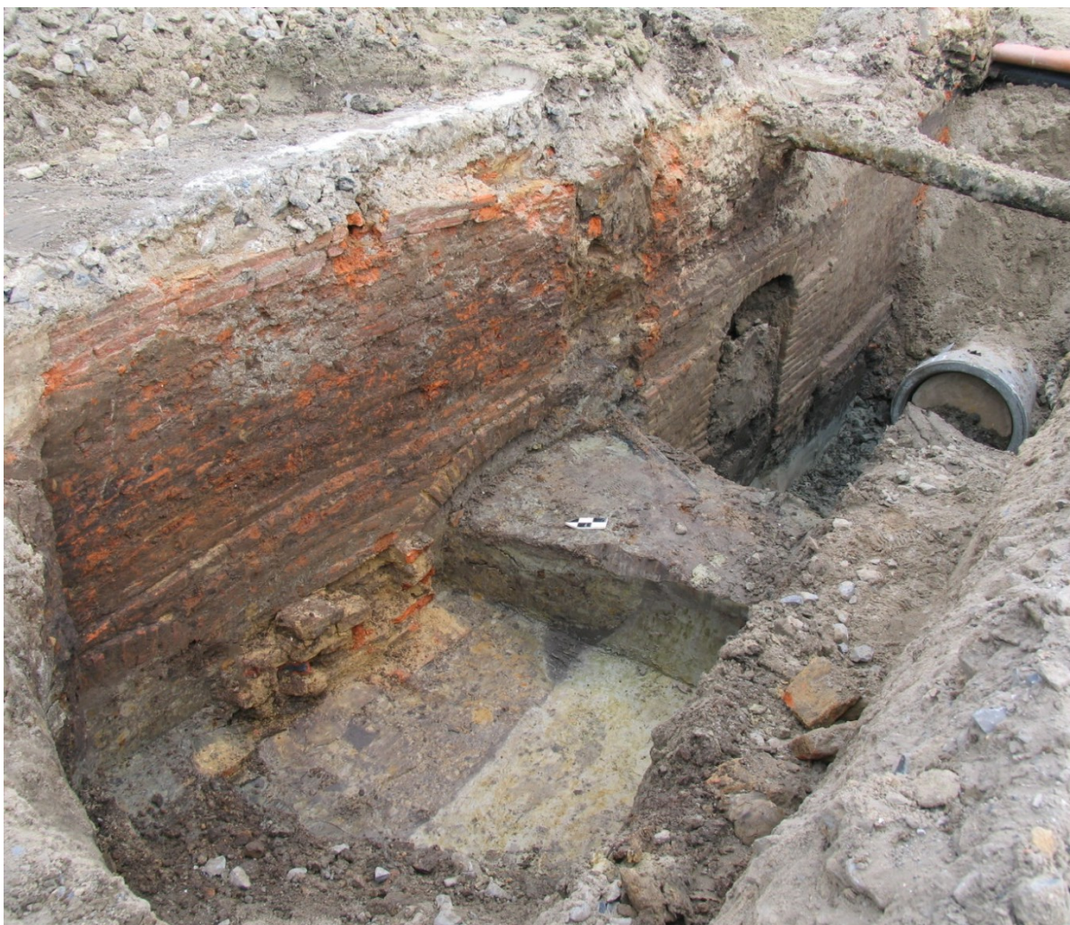
Figuur 1. Zicht op het zuidwestelijke deel van de bakstenen fundering met spaarboog van de 16 de /17 de -eeuwse ommuring.
