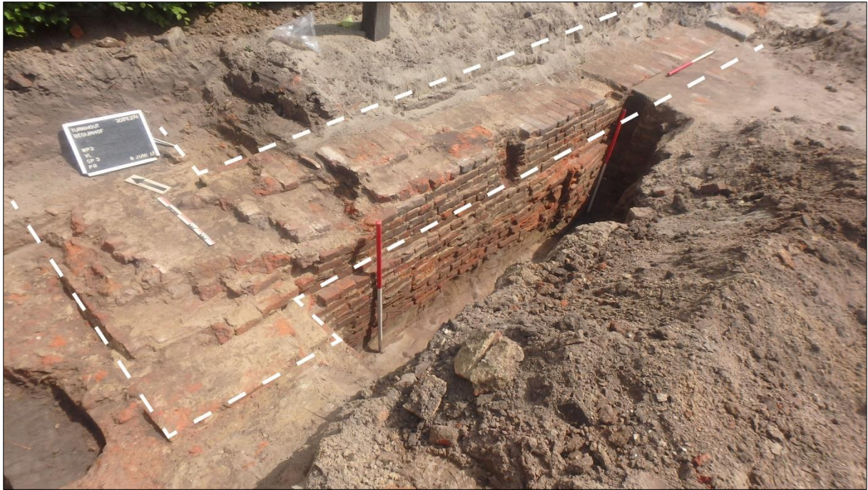
Figuur 26: detailfoto van de zuidelijke zijgevel van de oude kapel (S2003) ter hoogte van de hoek met de oorspronkelijke voorgevel. Op de foto is ook de mooi gemetste opbouw van de fundering zichtbaar.
