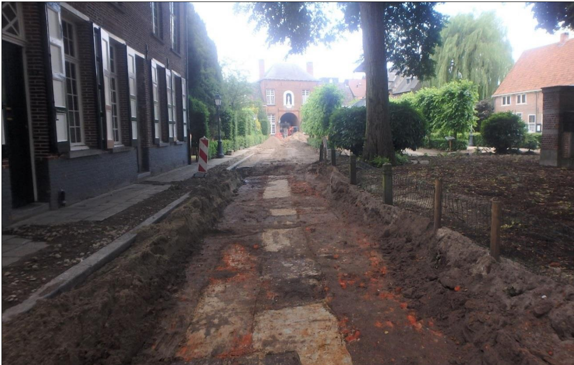
Figuur 1: Zicht het westelijke deel van werkput 1. Centraal in vlak 1 is duidelijk de verstoring van de bestaande riolering te zien (geelbruine aflijning).
