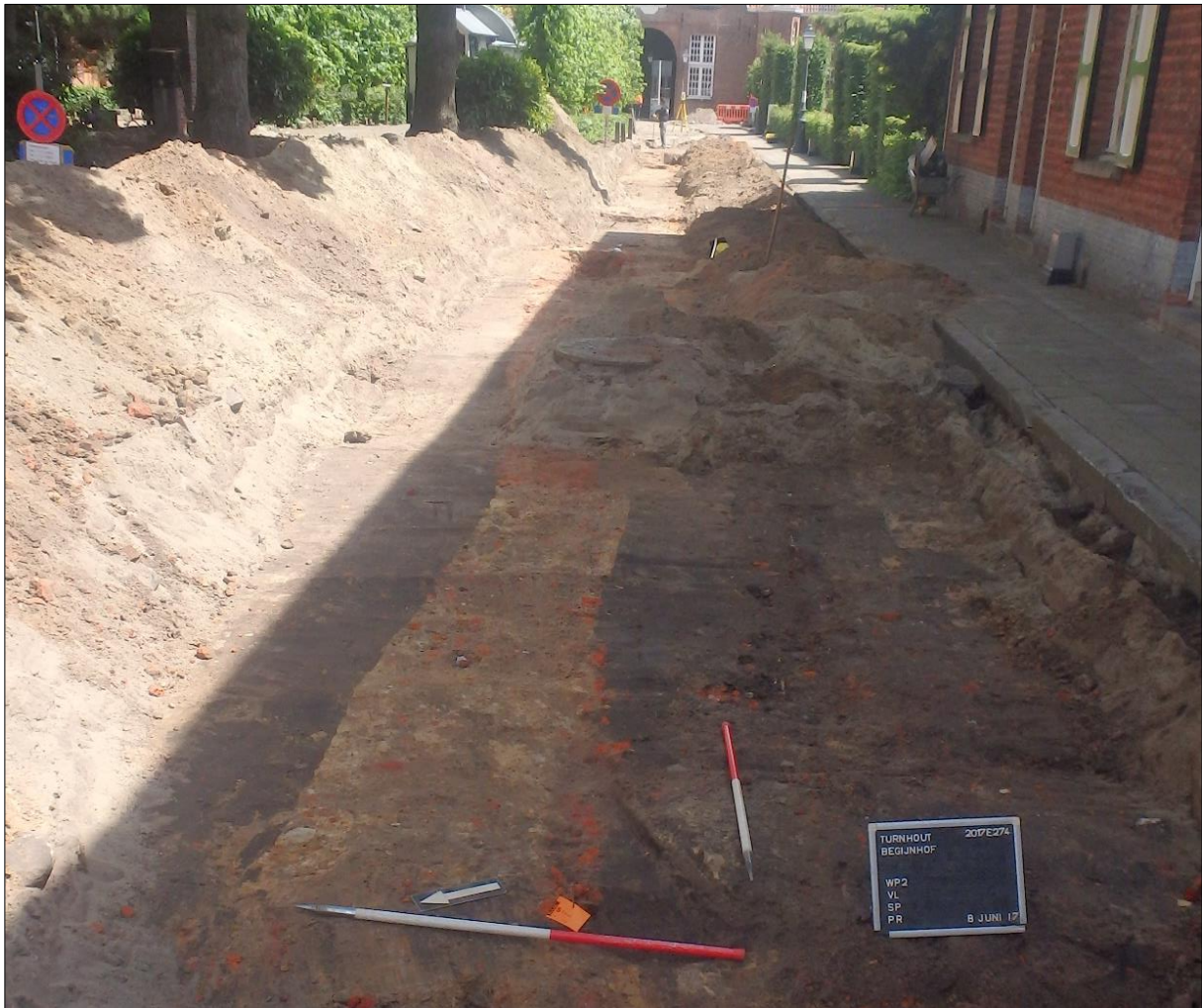
Figuur 3: Zicht op het westelijke deel van werkput 2. Rechts in het vlak is de versterking van de bestaande rioleringsleuf zichtbaar en centraal ook een rioleringsput.
