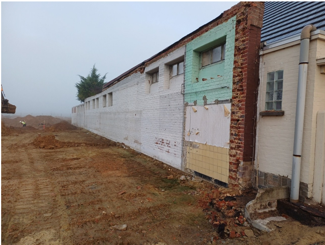
Figuur 8: De ondiep gefundeerde scheidingsmuur
