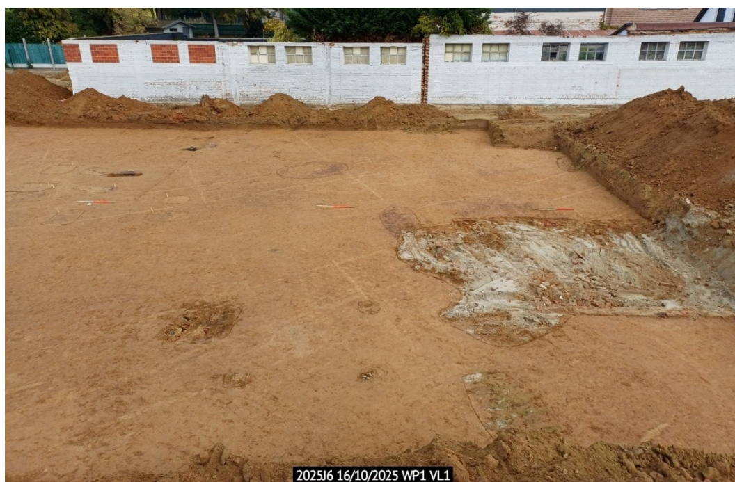
Figuur 24: Overzicht van WP1, zuidoostelijke zone
