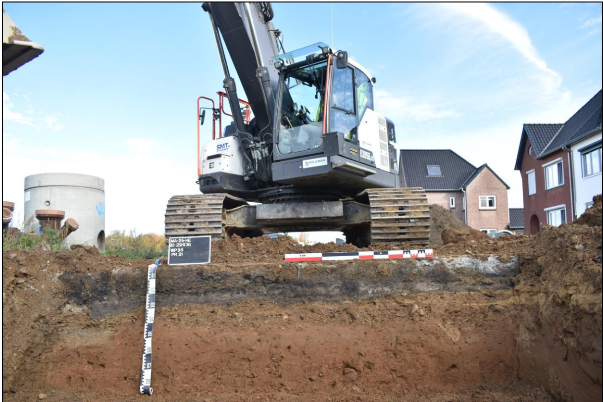
Afb. 55: Werkput 9B (PR21) met smalle greppel en spoellaagjes aan de westzijde (S43/44).
