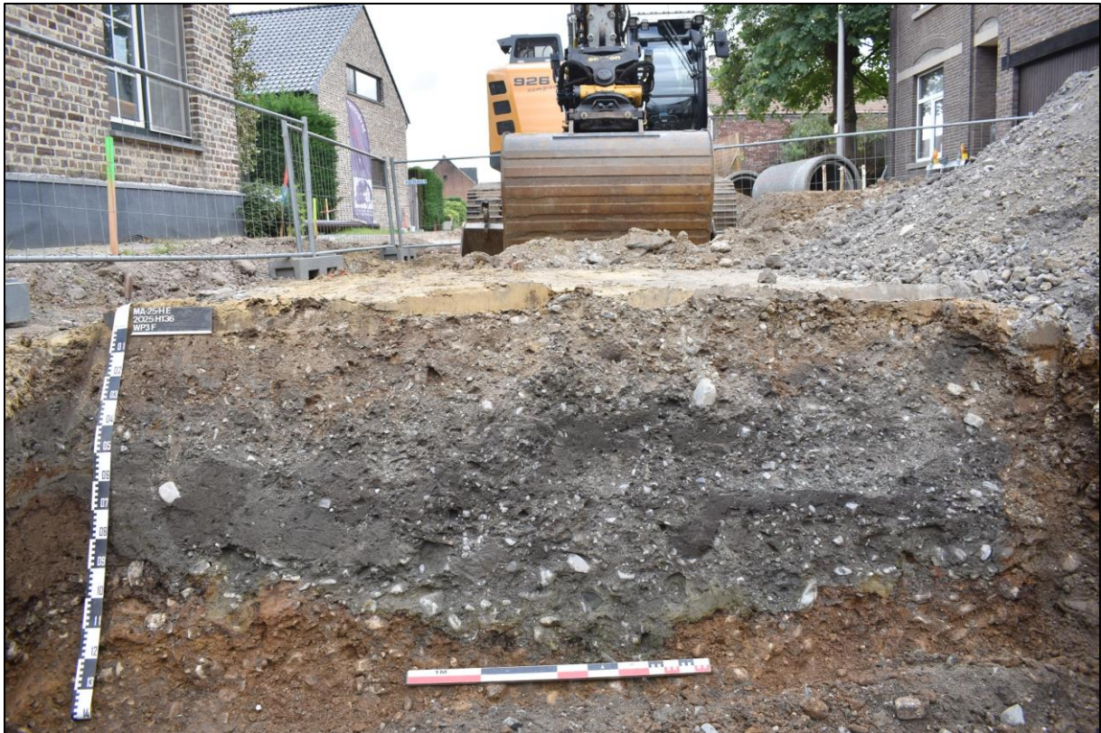
Afb. 51: Werkput 3F (PR9) met komvormige weg en opgevulde greppel aan de oostzijde (links).
