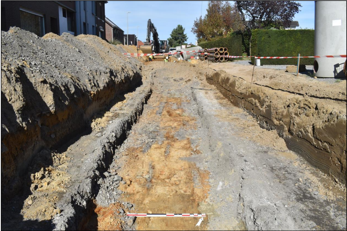
Afb. 50: Werkput 3C met tussentijdse afgraving en duidelijk zicht op de karresporen gevuld met grind.
