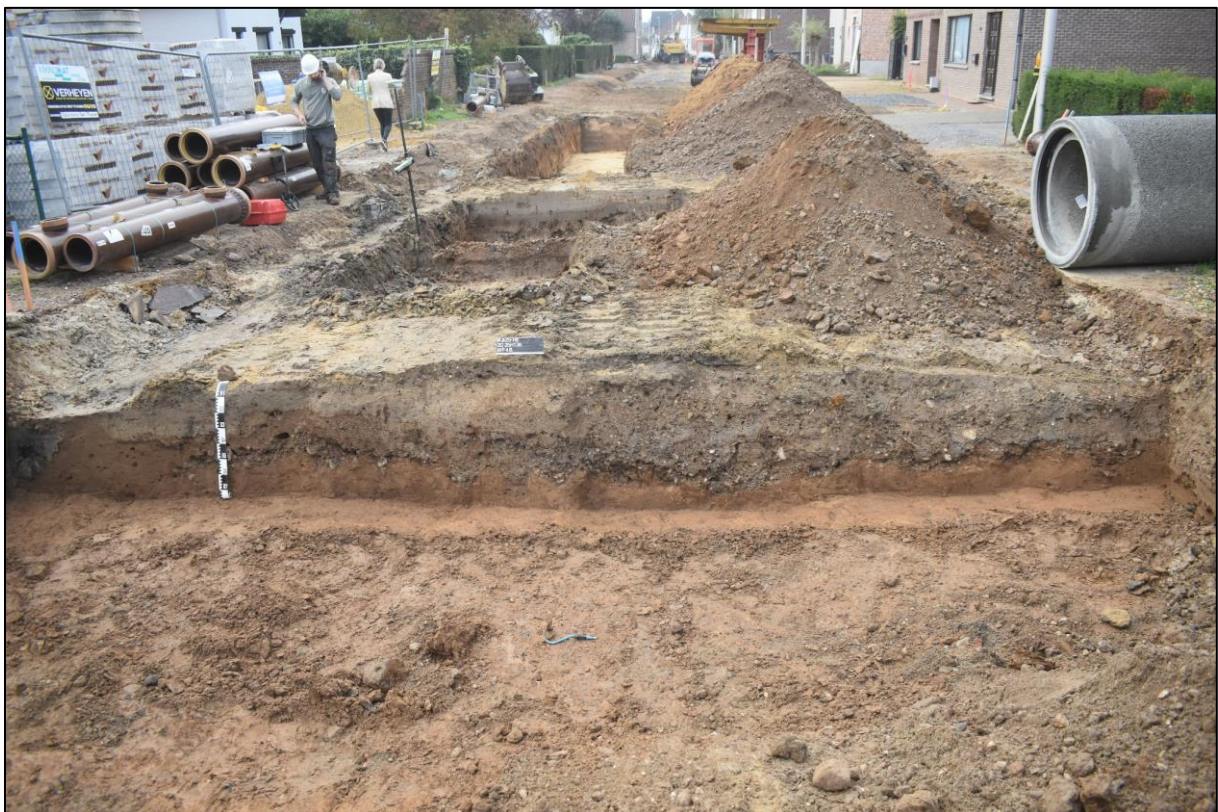
Afb. 52: Werkput 4B (PR11) met 6 m breed licht komvormig wegdek en vlakke bodem.
