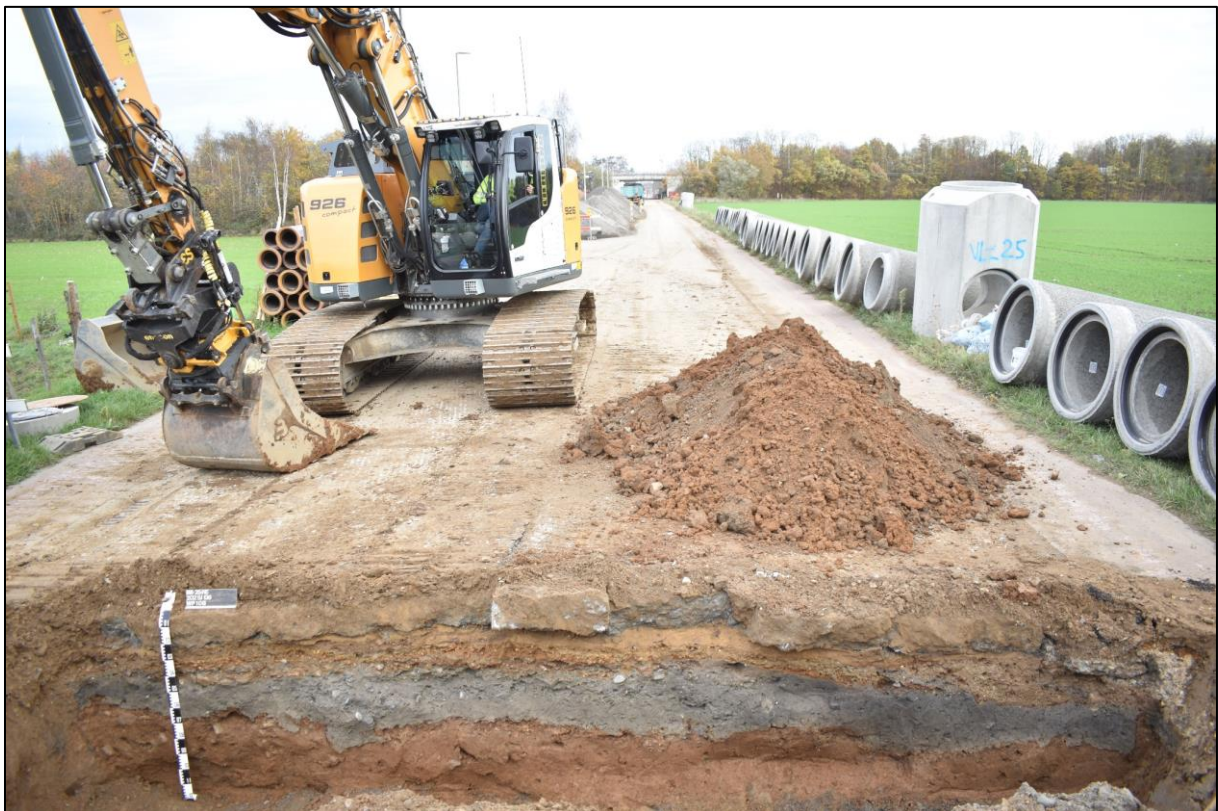
Afb. 34: Werkput 10: dwarsprofiel met aanwezige historische weg.
