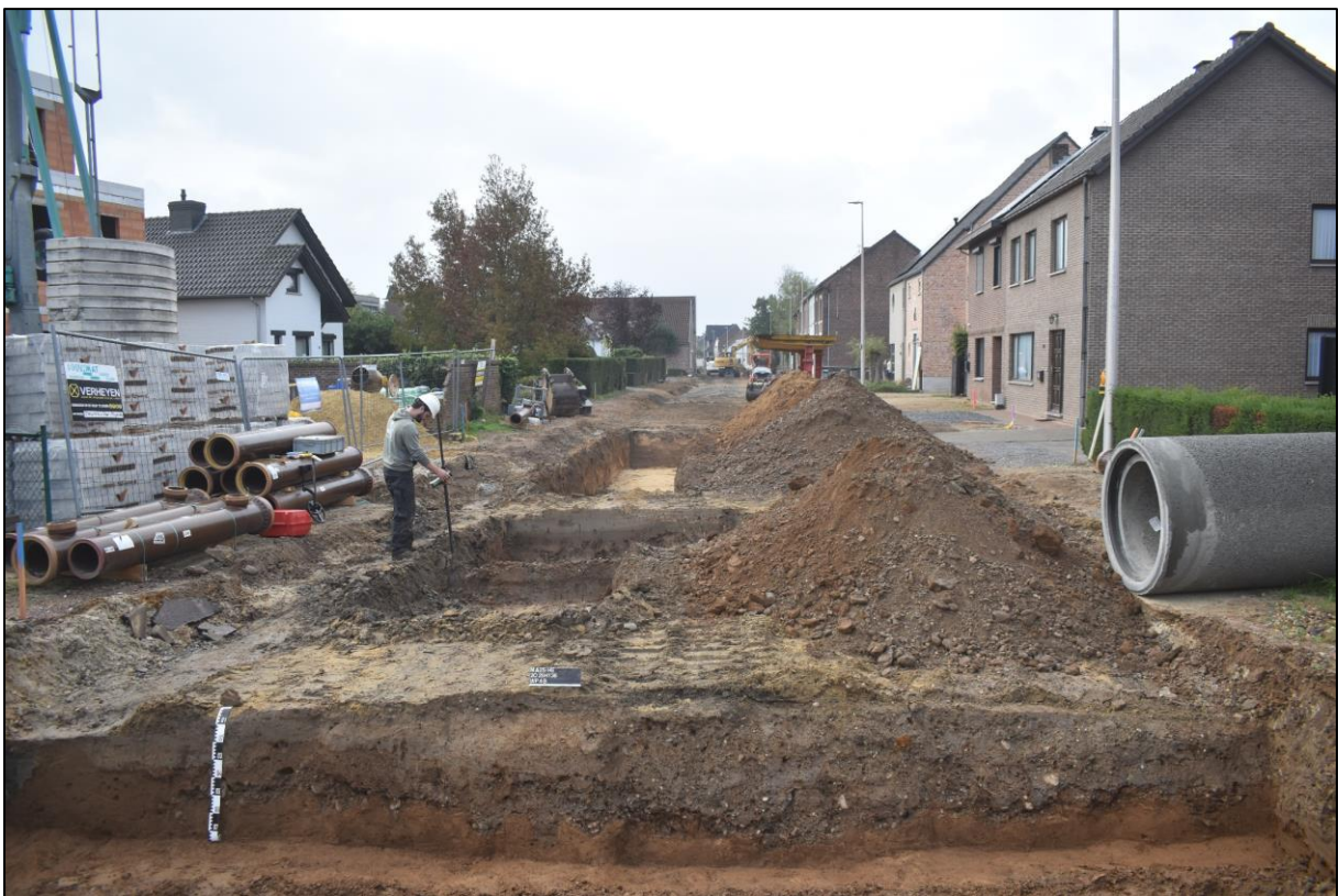
Afb. 10: Aangelegde werkputten en een volledig dwarsprofiel met Romeinse weg.
