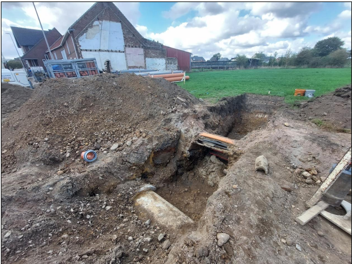
Afb. 8: Aanwezige nutsleidingen langs de straatzijde die diepe verstoringen veroorzaakten.
