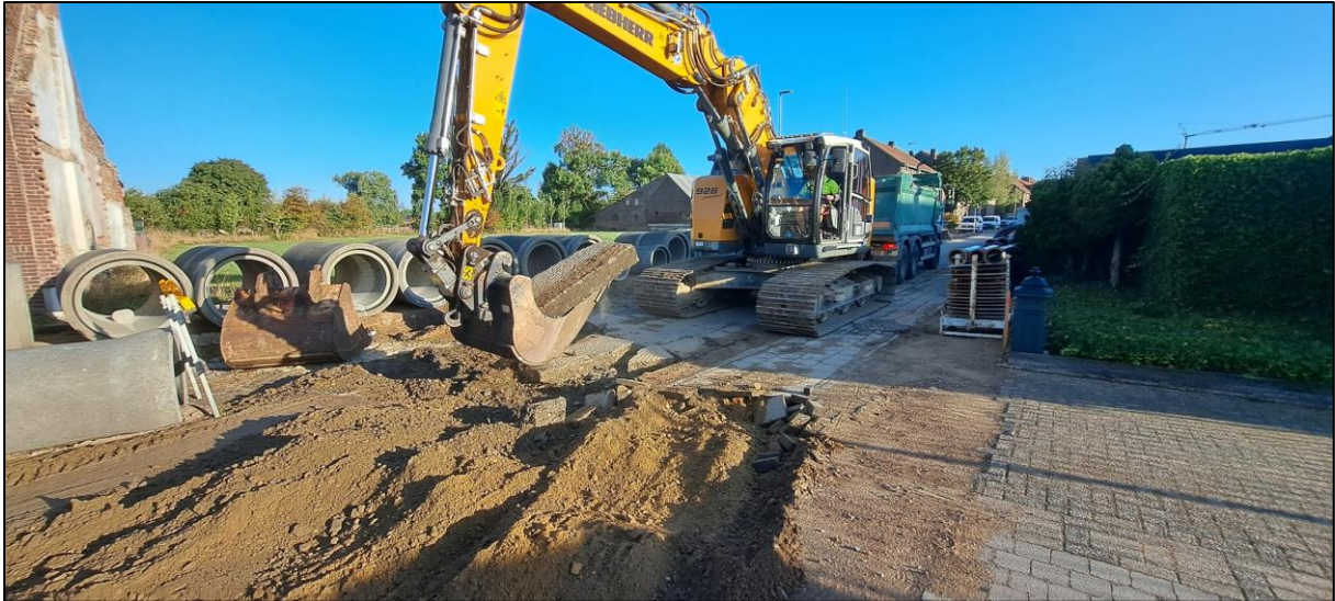
Afb. 7: Voorbereidende werken waarbij het oude wegdek werd opgebroken.
