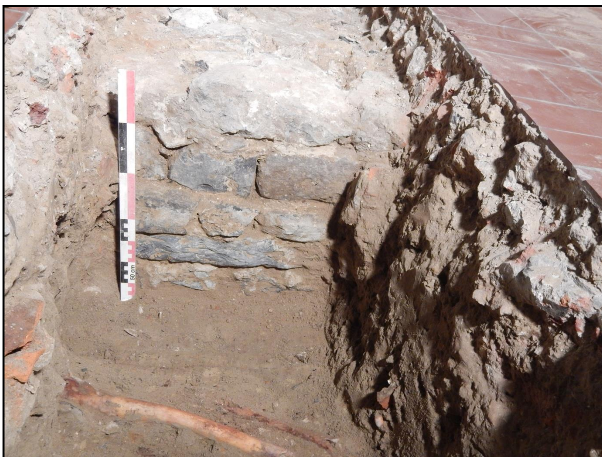
Figuur 23: Detailzicht op de zuidelijke zijde van de natuurstenen fundering S25 in WP12.
