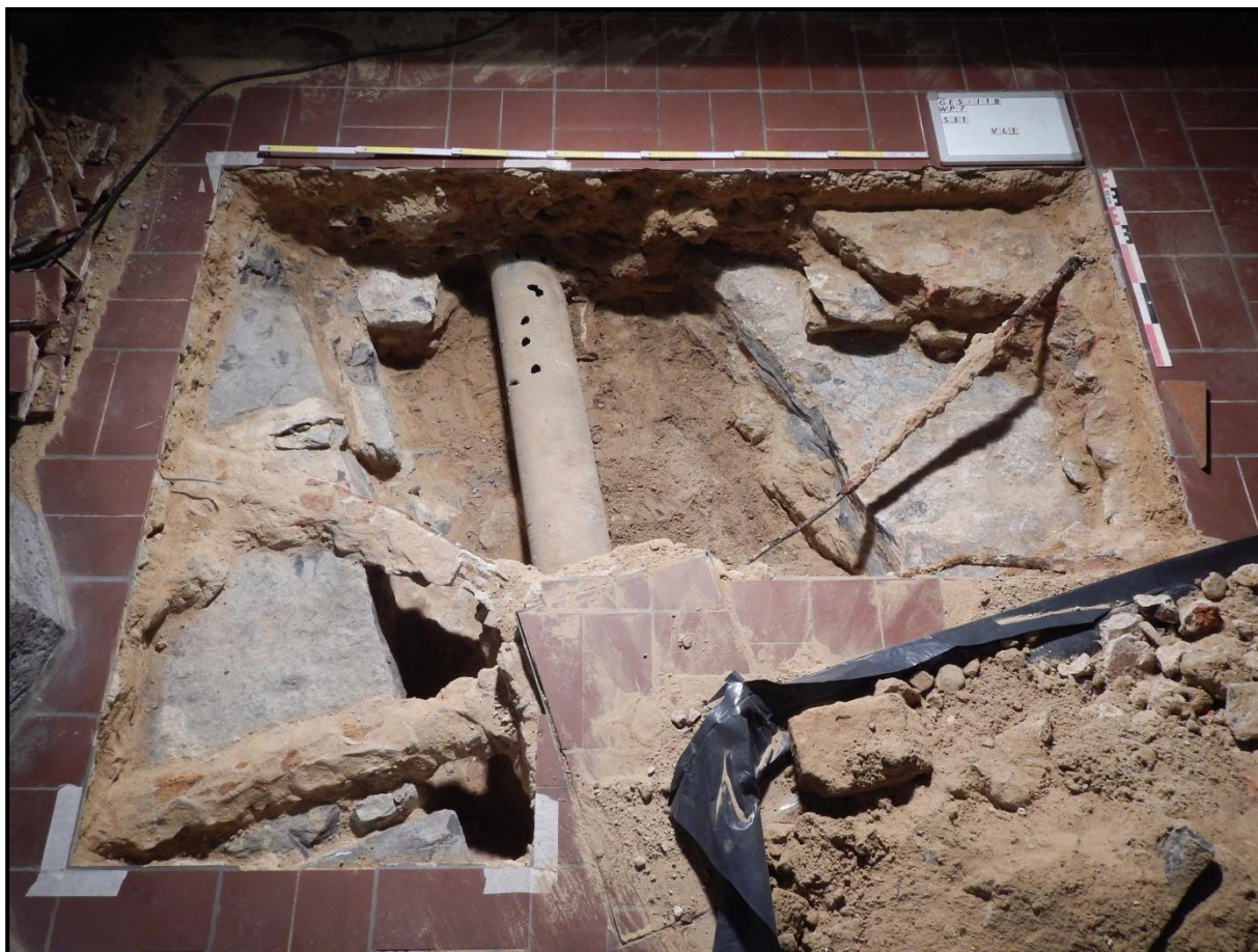
Figuur 4: WP7 met links de massieve getrapte fundering en links de fundering waarvan sprake door F. De Smidt.
