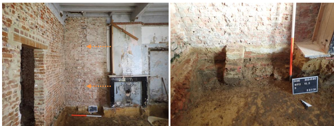
Figuur 44: Haardmuur M15 in vlak 1, t.o.v. de bestaande muren met aanduiding bouwnaad (oranje pijlen) (L) en detailfoto in vlak 2 (R) (© ARCHEBO bv)
