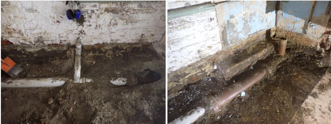
Figuur 39: Afvoerbuis in plastic en aardewerk (© ARCHEBO bv)
