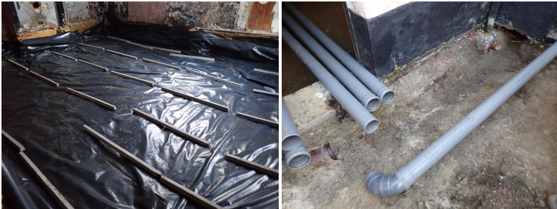
Figuur 62: Afdekking van het vlak met plastic (L) en uitgraving extra sleuf op de binnenkoer (R) (© ARCHEBO bv)
