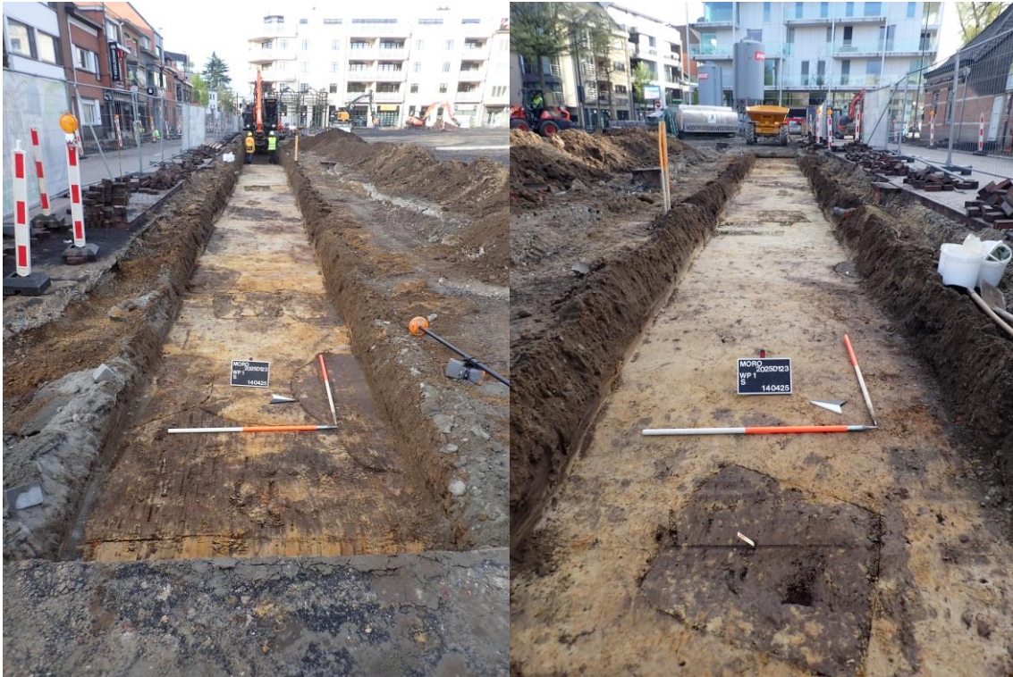
Figuur 16: Vlakfoto werkput 1 in zuidwestelijke (L) en noordoostelijke (R) richting (© ARCHEBO bv).
