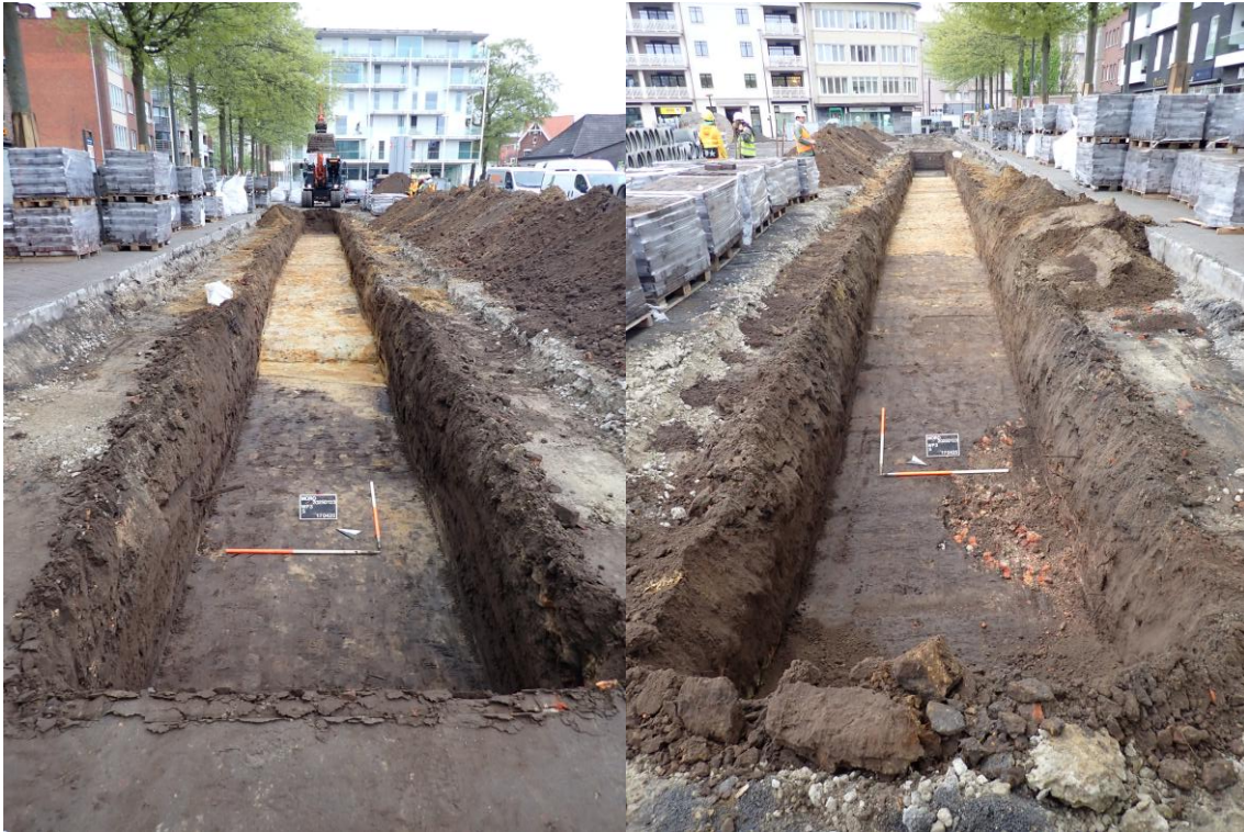
Figuur 20: Vlakfoto werkput 3 in noordoostelijke (L) en zuidwestelijke (R) richting (© ARCHEBO bv).
