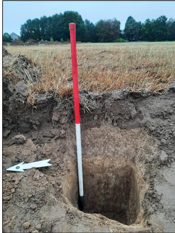
Figuur 20: Werkmethodiek: manuele aanleg profielen.
