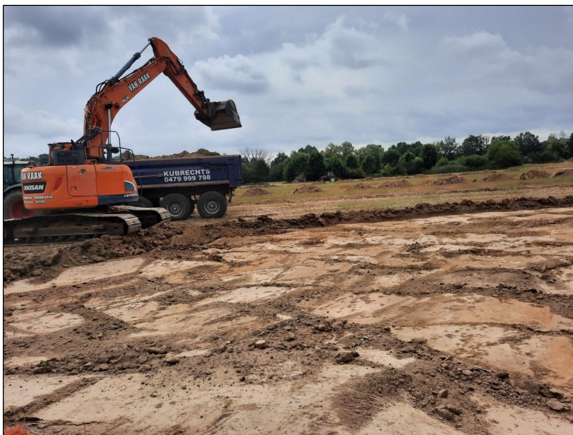
Figuur 19: Werkmethodiek: machinale afgraving bodem.
