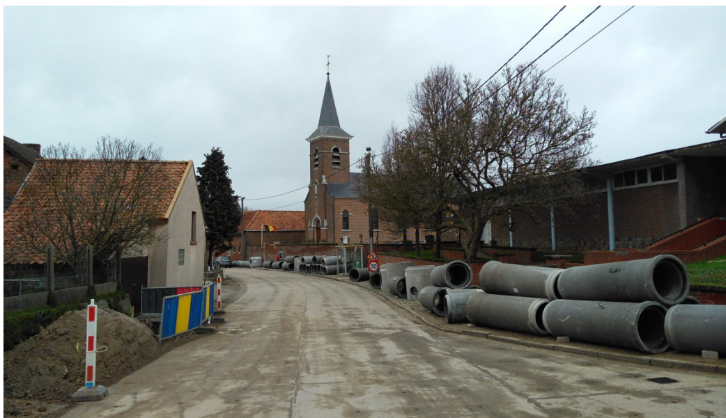
Afb. 3. De archeologisch te begeleiden zone, voor aanvang van de werken.
