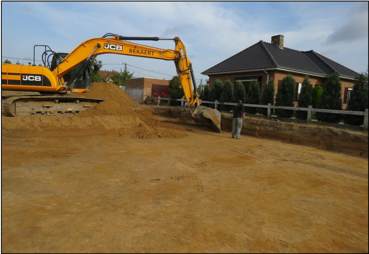
Figuur 9 Aanleg en opschaven van het vlak.
