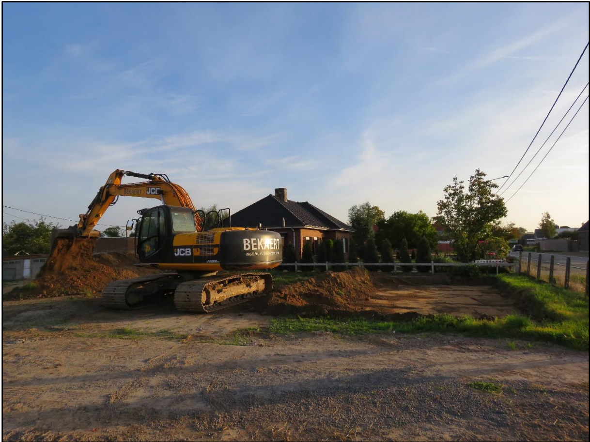
Figuur 14 Zicht op de opgravingszone bij het verwijderen van de teelaarde.
