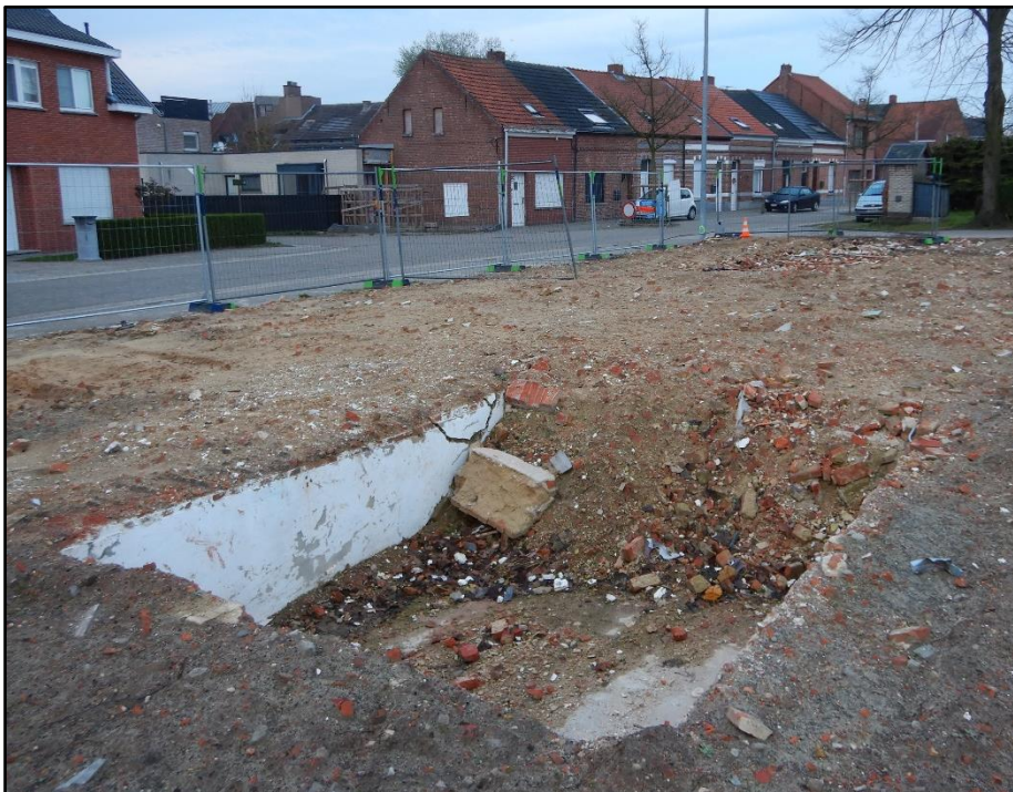
Figuur 68 Overzichtsfoto van de kelder ten westen van sleuf 2.
