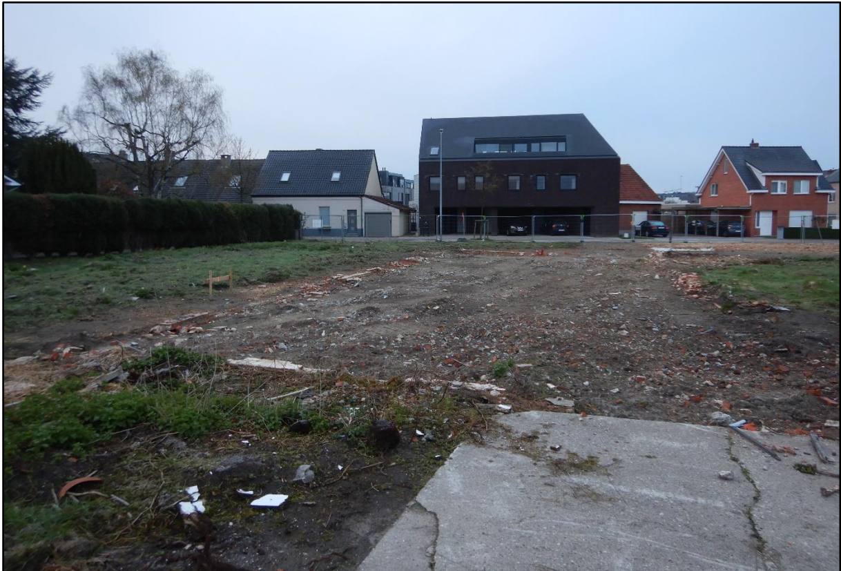
Figuur 6 Zicht op de funderingsmuren van de voormalige schuur.
