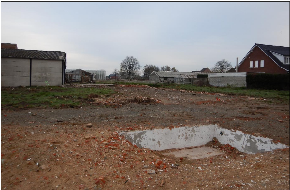
Figuur 7 Zicht op een wit bepleisterde kelder in de voormalige hoeve aan de straatzijde.
