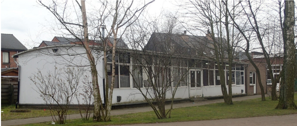
Fig. 7. Zicht op het zuidelijke gebouw aan de westzijde (foto Erfpunt).
