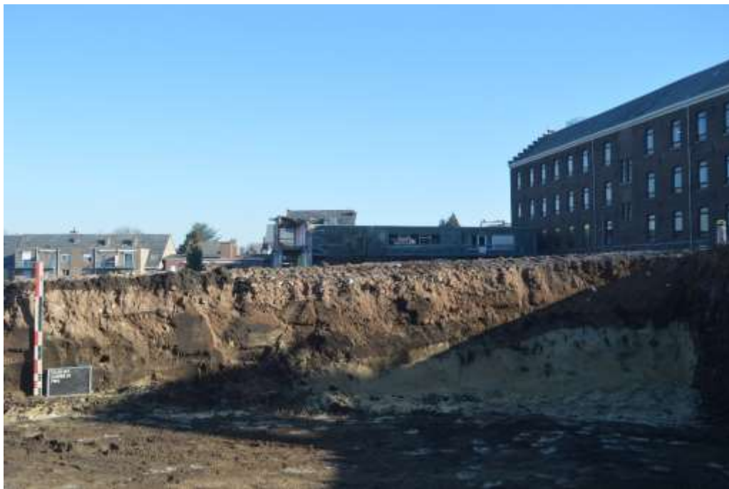
Afb. 15: zicht op het noordprofiel (PR4), bestaande uit een donkerbuine opvullaag van de voormalige zandgroeve, waarin rechts in beeld een grote zandlens voor komt.
