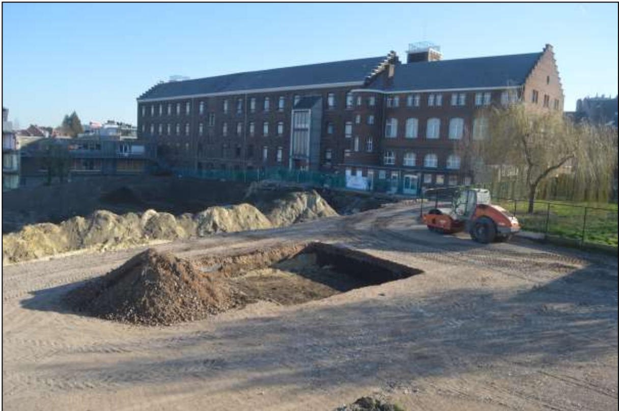
Afb. 5: Globaal zicht op de werf voor het uitgraven van de put voor de kraanvoet.
