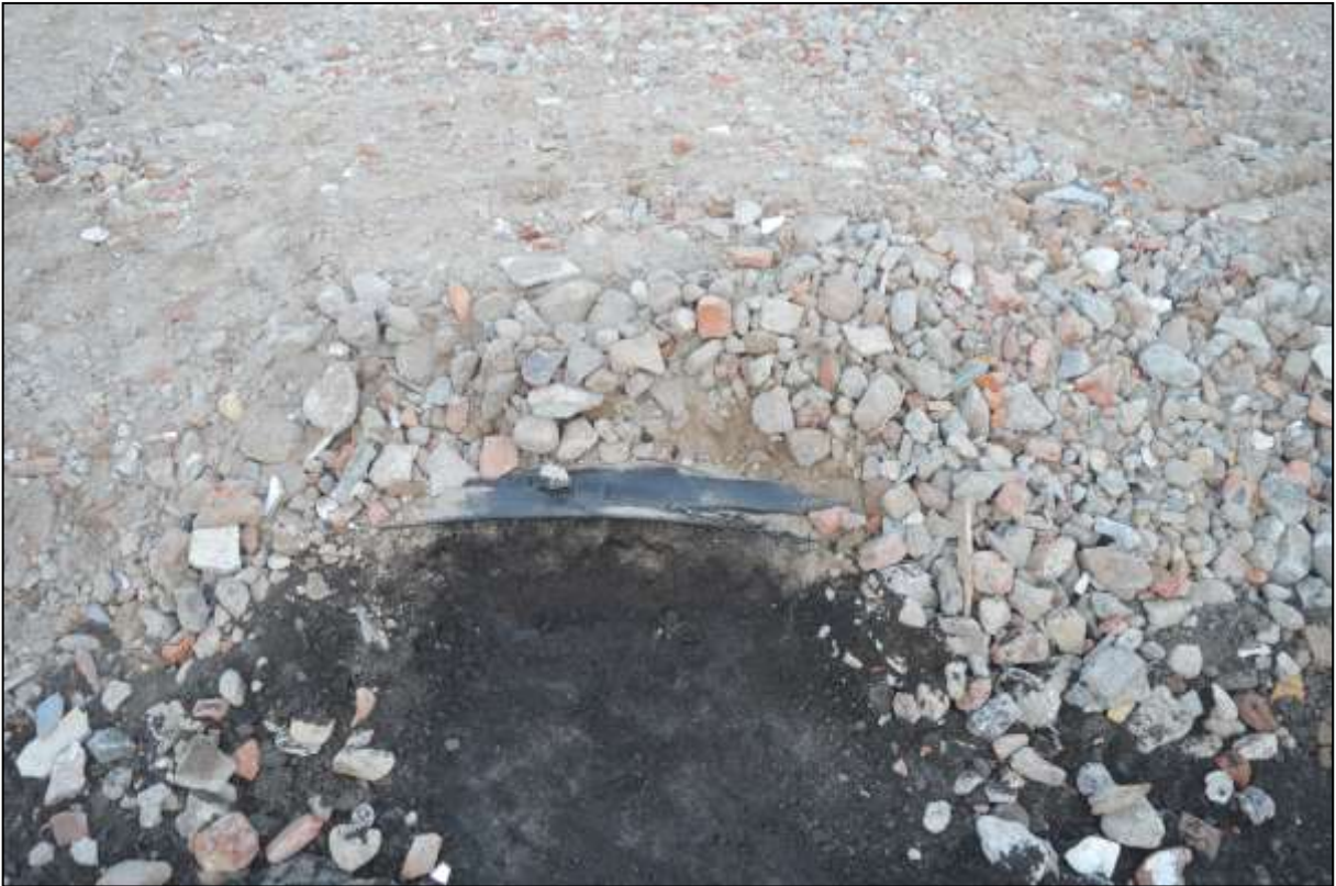
Afb. 7: De zone die verhard werd met steenslag, werd voorafgaand van de graszoden ontdaan, en volledig afgedekt met geotextiel. Foto genomen vanop de locatie waar de kraanvoet moest uitgegraven worden.
