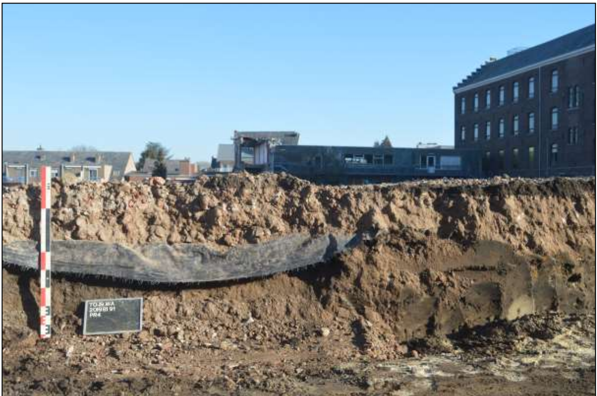
Afb. 8: De zone die verhard werd met steenslag, werd voorafgaand van de graszoden ontdaan, en volledig afgedekt met geotextiel. Foto genomen vanuit de uitgegraven kuil voor de kraanvoet.
