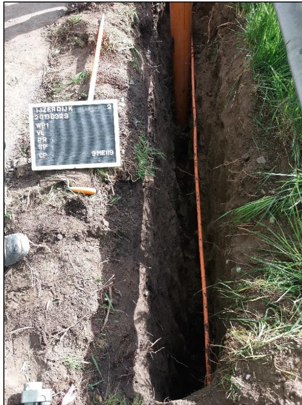
Figuur 17: Aanleg werkput 1 overzichtsfoto (ABO nv)
