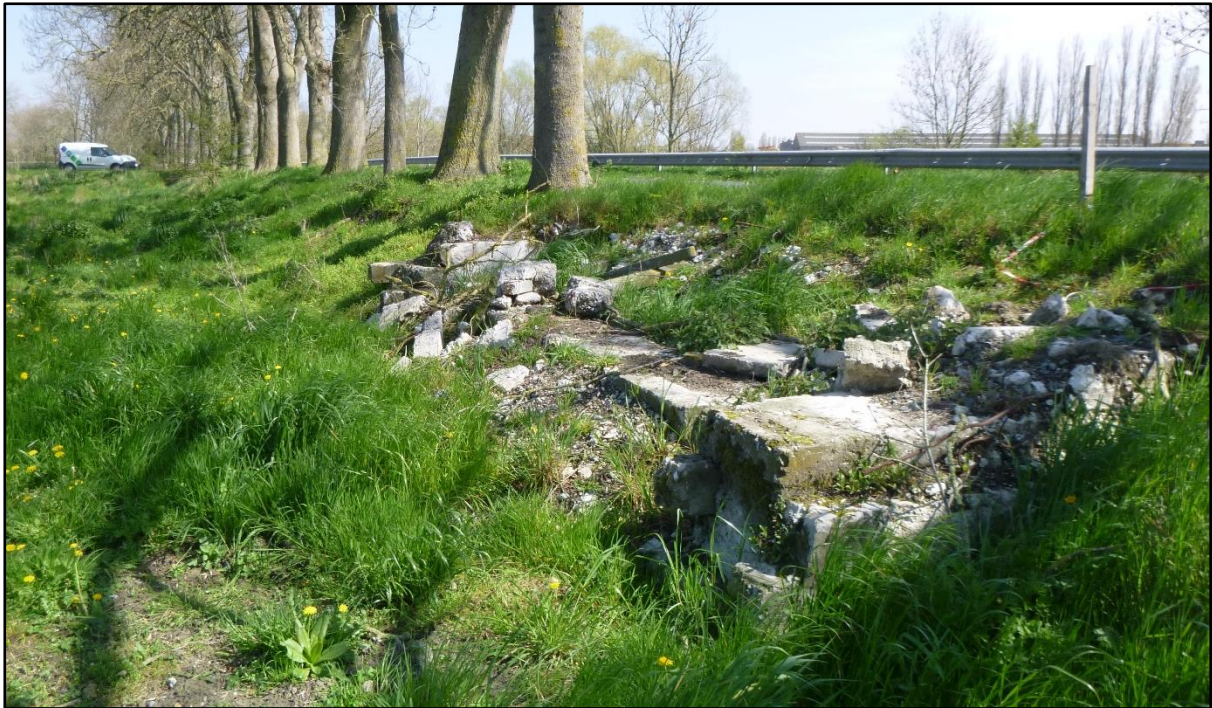
Figuur 2: Zicht op de actuele toestand van bunkerrestant spoor 122 (ABO nv 2019)
