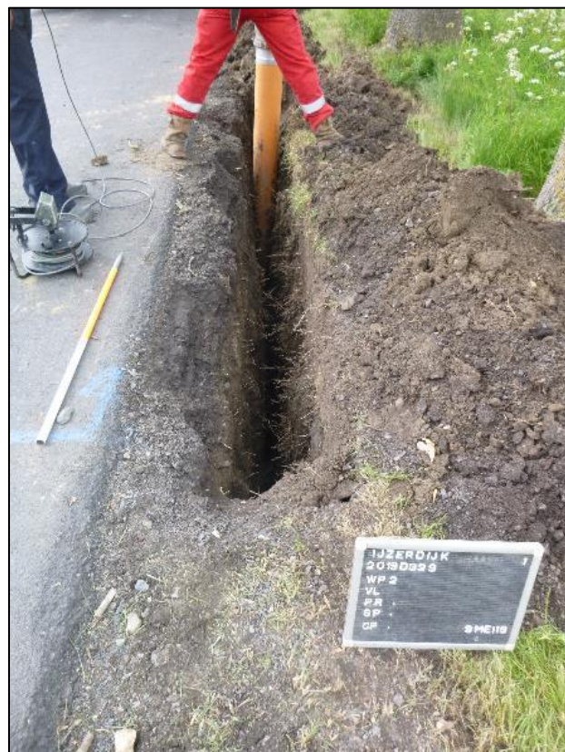
Figuur 18: aanleg werkput 2 overzichtsfoto (ABO nv)
