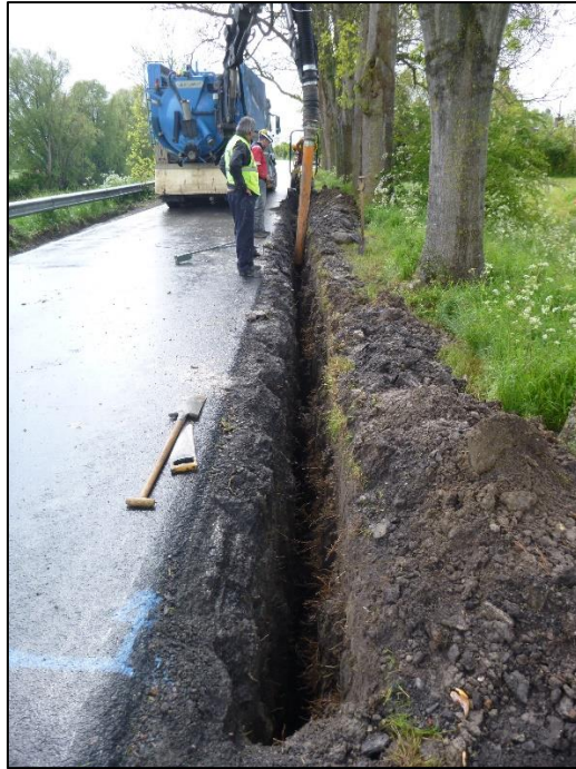
Figuur 19: aanleg werkput 2 overzichtsfoto (ABO nv)
