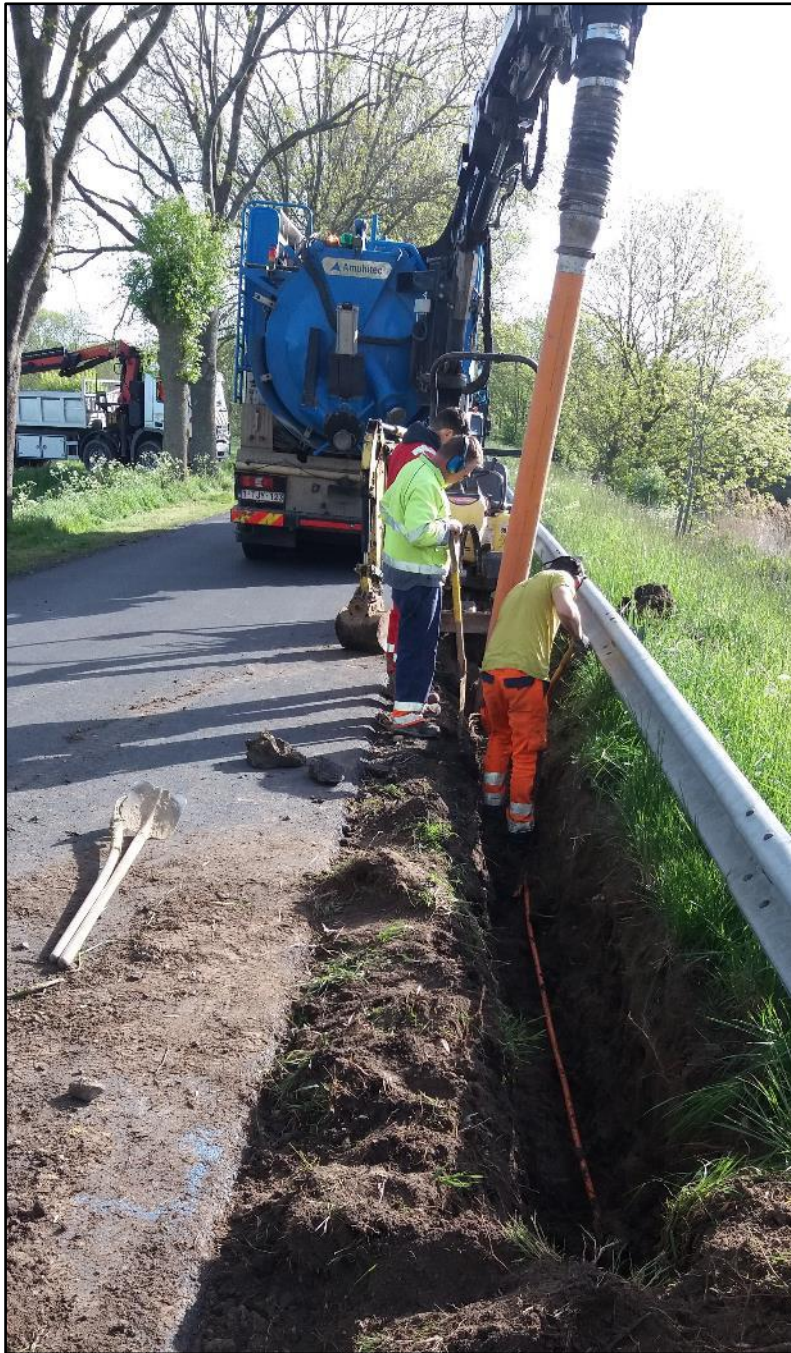
Figuur 15: Aanleggen van Werkput 1 (ABO nv 2019)
