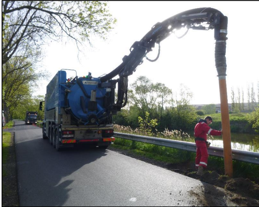
Figuur 14: De zuigwagen in actie langs de IJzerdijk (ABO nv 2019)
