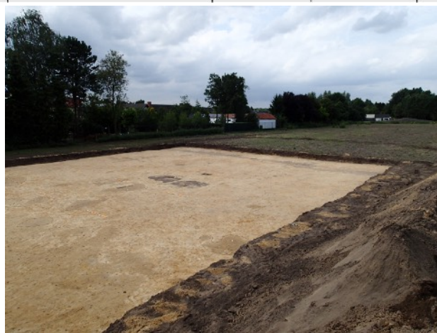
Fig. 7 Het zuidelijk deel van werkput WP8 gezien vanuit het zuidoosten.
