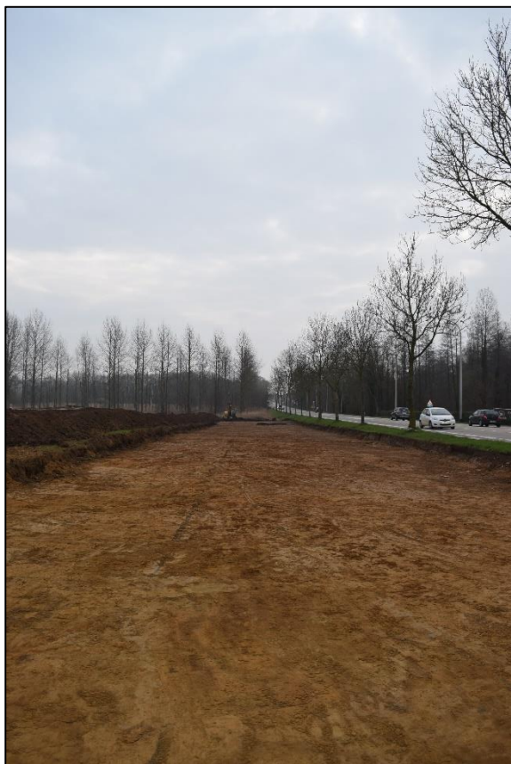
Afb. 5: Aangelegde werkzone met afgegraven Ap-horizont (Bron: ARON bvba, dd 15/3/2017, 2017C186)
