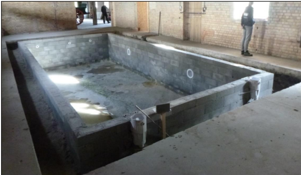
Figuur 13: Sfeerbeelden terrein, aangelegd zwembad en nutsleiding.
