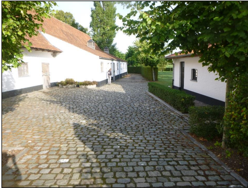
Figuur 12: Zicht op het te onderzoeken terrein. De nutsleidingen zijn aangelegd vanaf de schuur met het zwembad (links), en lopen onder de aanwezige oprit.
