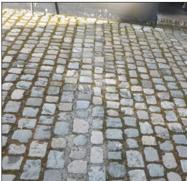
Figuur 15: Heraangelegde tegels na aanleg nutsleidingen.
