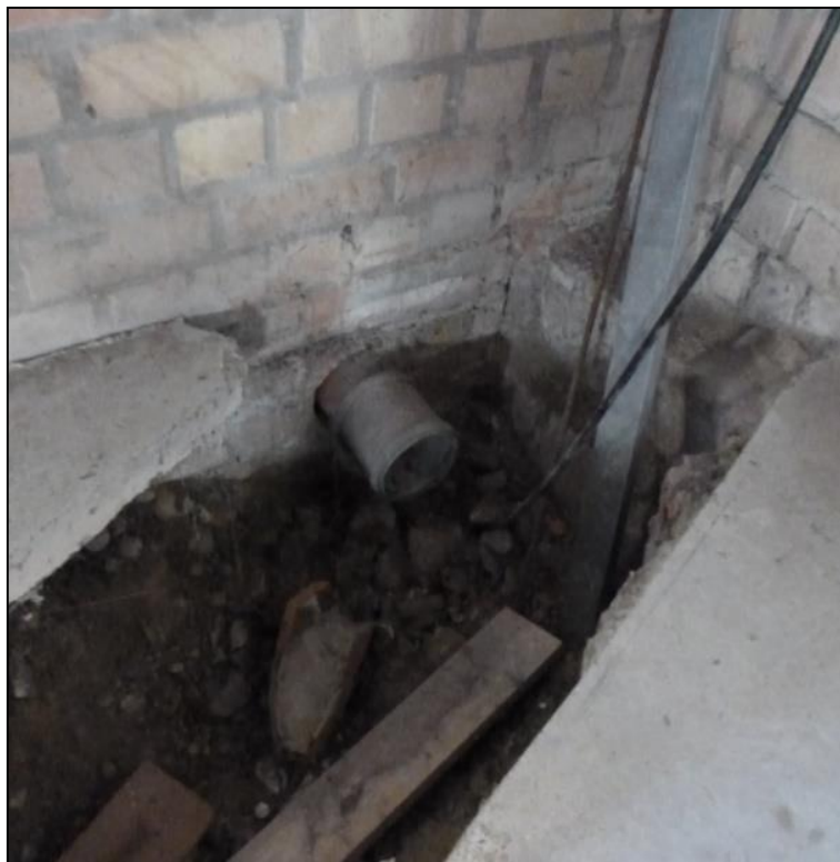
Figuur 14: Aangelegde nutsleiding in oostelijke hoek schuur.
