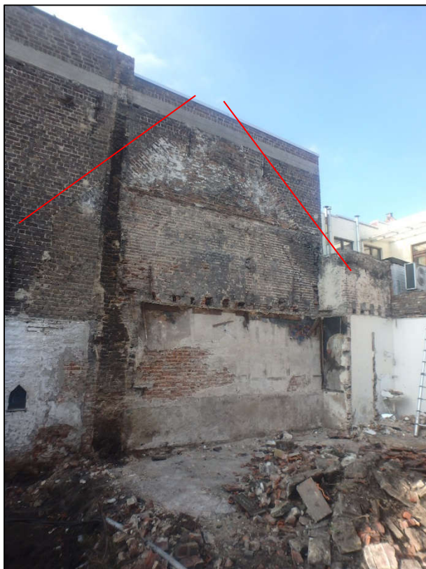
Figuur 24: Westelijke perceelsmuur met afdruk van oudere woning
