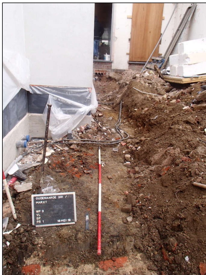
Figuur 13: Overzichtsfoto rioleringsleuf fase 5
