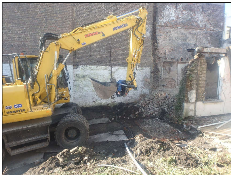
Figuur 1: Fase 1 - Graafmachine voor de aangetroffen regenwaterput
