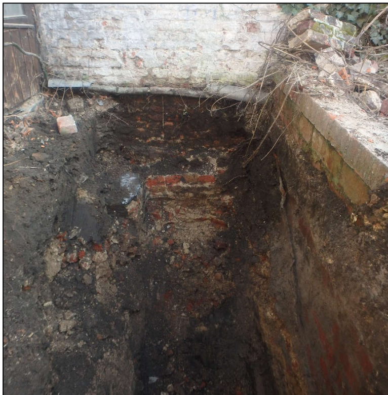
Figuur 2: Fase 2 - Controleput langs perceelsmuur
