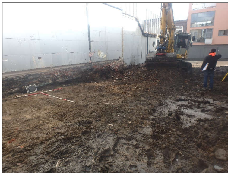
Figuur 3: Fase 3 - Aanleg van een geleidelijke helling vanaf de huidige apotheek tot aan de Burgschelde
