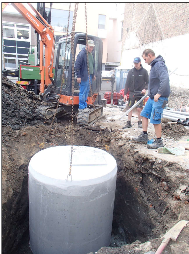
Figuur 5: Fase 5: Plaatsing van waterciternes
