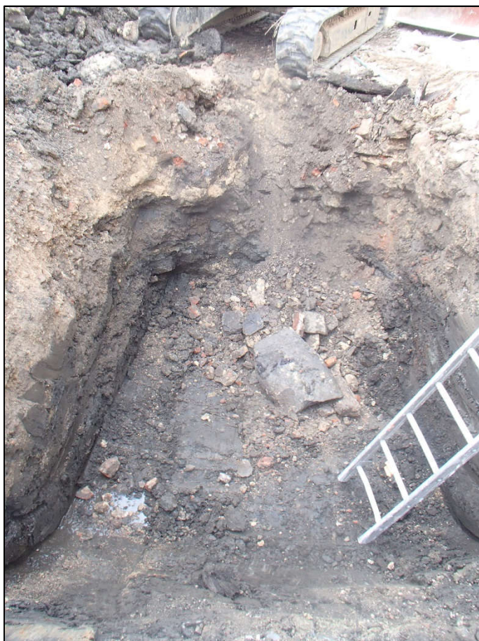
Figuur 12: Overzichtsfoto plaatsing citerne fase 5
