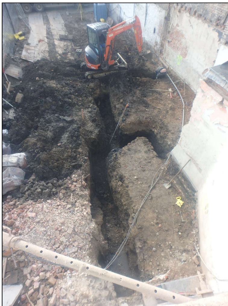
Figuur 4: Fase 4 - Aanleg van funderingssleuven
