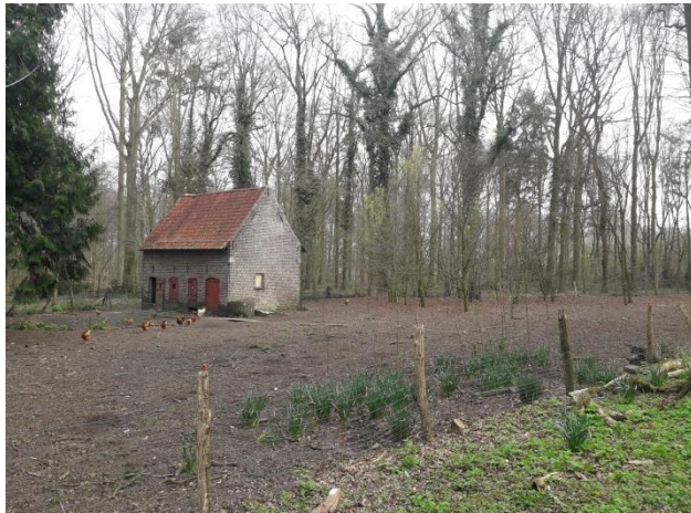
Figuur 3: Zone aan te leggen parking bij terreinbezoek op 30/03/2019. Bij aanvang van de werken op 27/05/19 was het bijgebouw afgebroken (© RAAP België).
