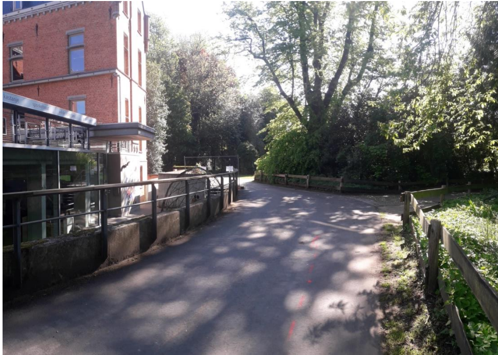
Figuur 5: Toestand voor aanvang werken, zicht richting oosten. Links van de rode markering wordt het terrein afgegraven tot het niveau van het vloerpeil van de bijbouw van het kasteel, rechts van de rode lijn wordt schuin in talud afgegraven (© RAAP België).
