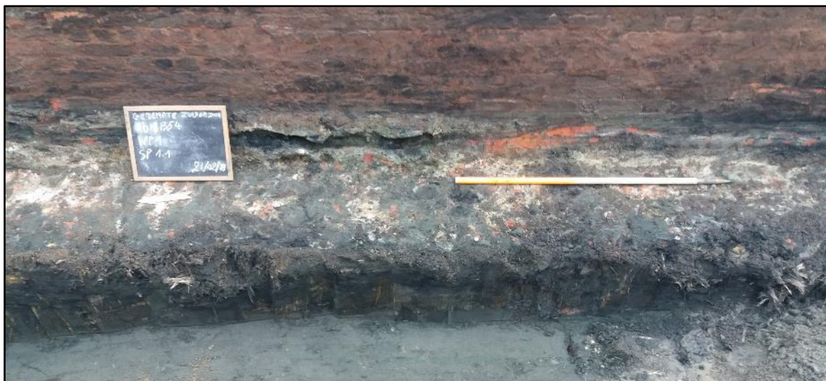
Figuur 27: Algemeen zicht op de funderingszool aan de binnenzijde van het dok (ABO nv 2018)
