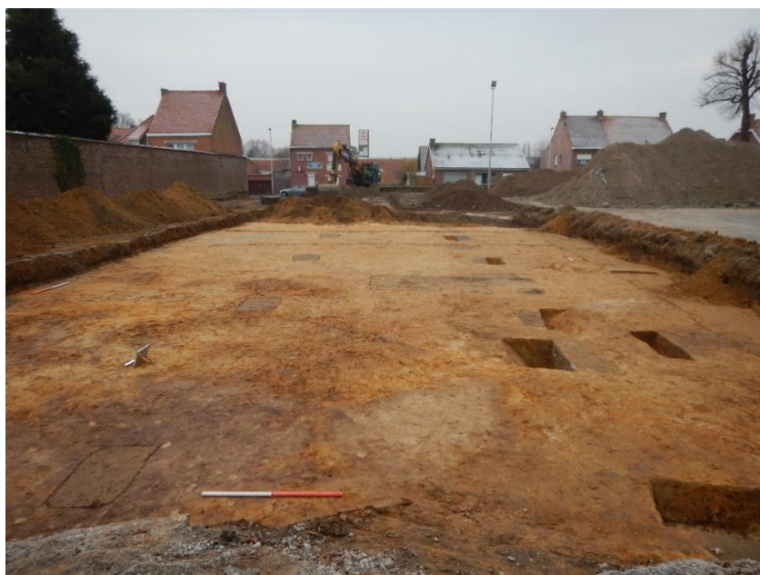
Figuur 5: Vlakfoto noordelijk deel werkput 2 met aanzicht vanuit het noorden.
