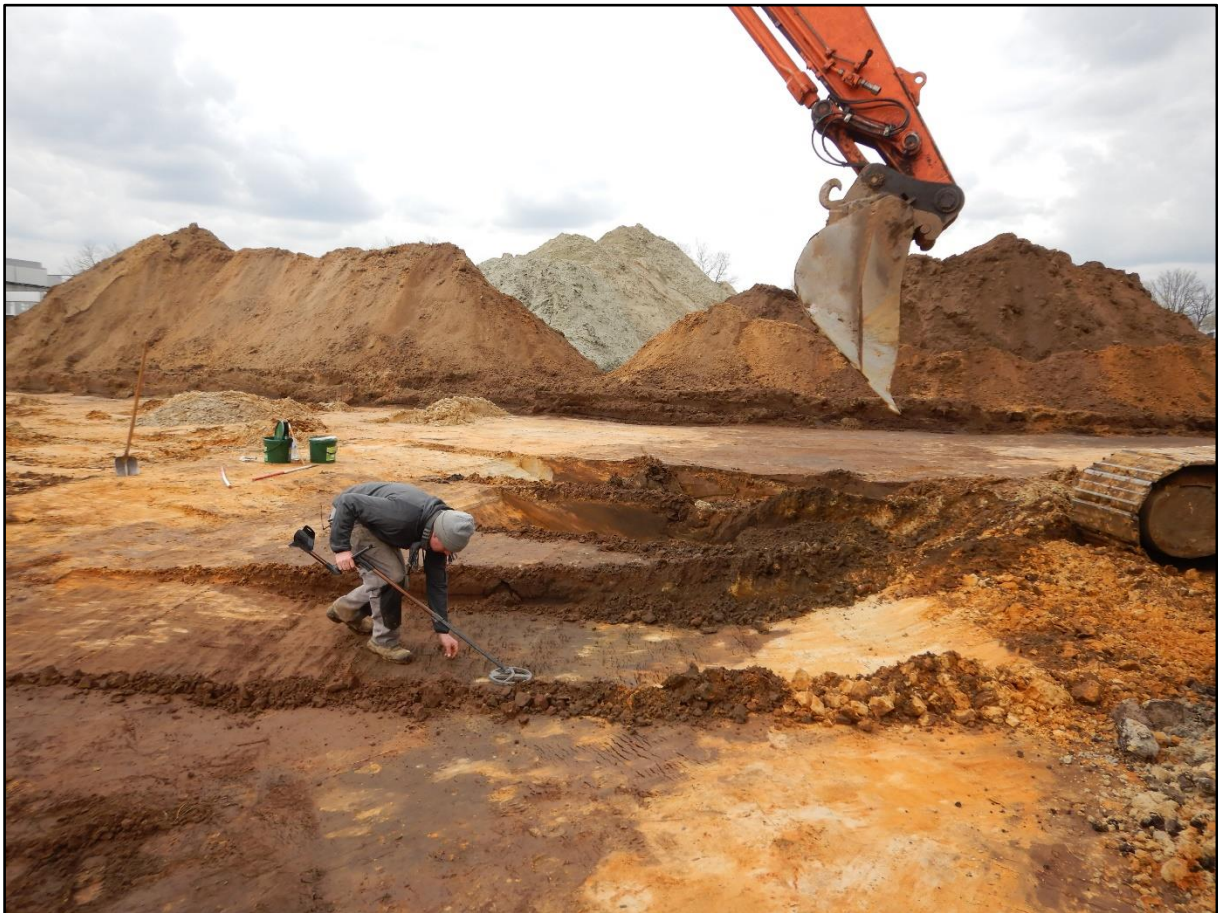
Figuur 15 Machinaal uithalen en metaaldetectie van de grachtvulling.
