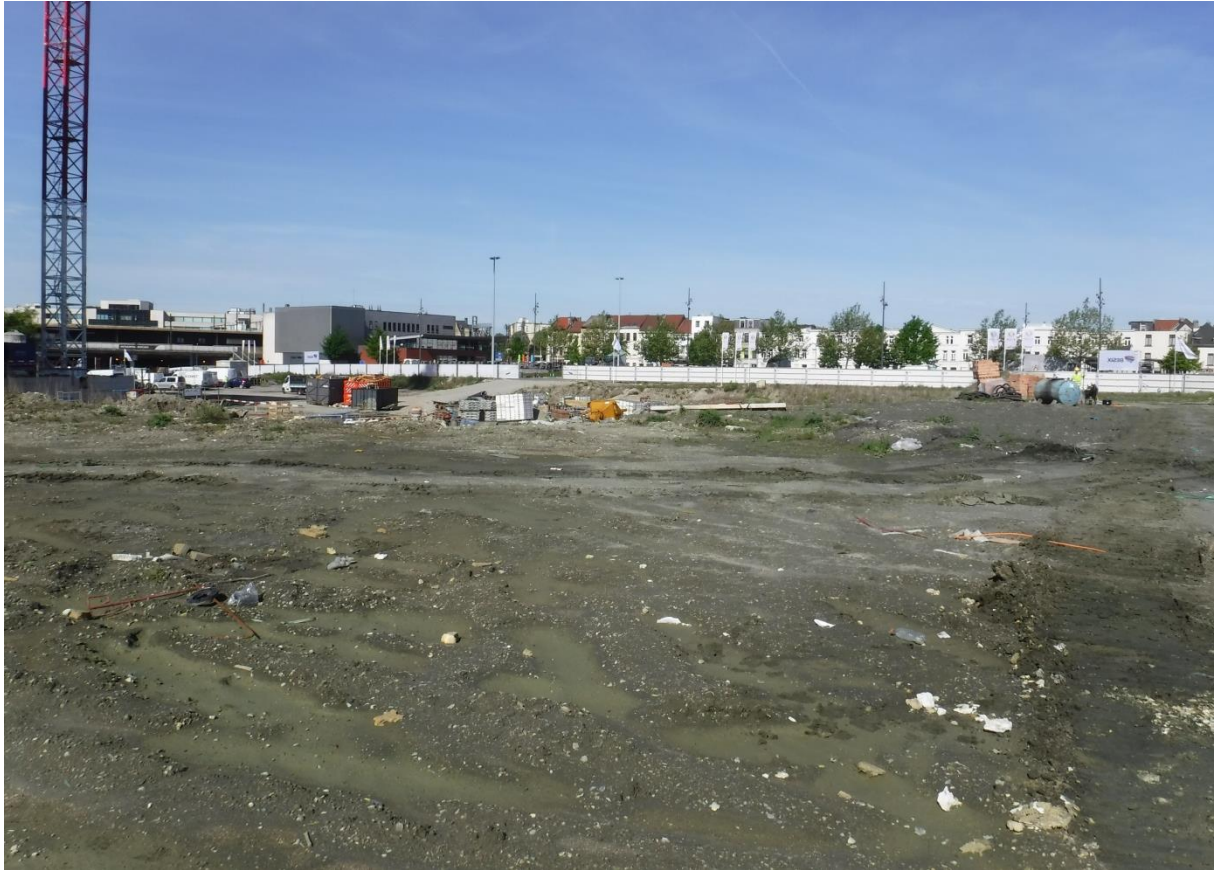
figuur 11 Situatie van het terrein voor de start van het archeologisch onderzoek. Zicht naar het westen.
