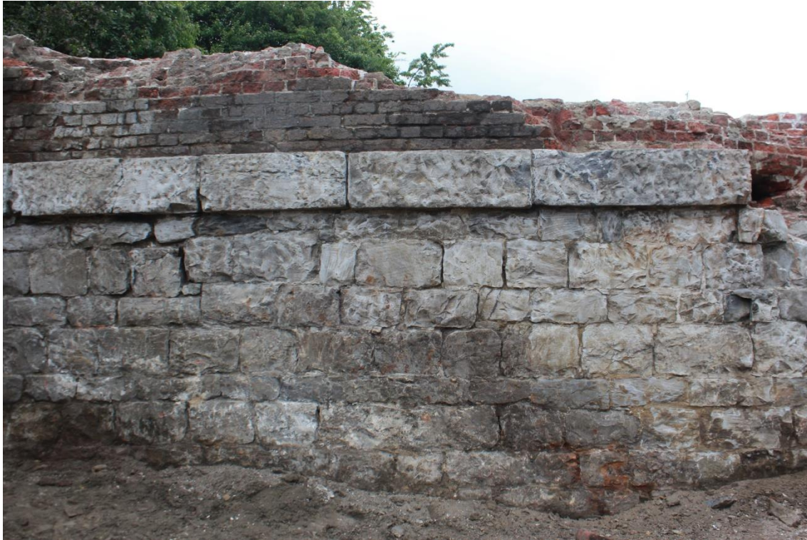
figuur 35 Muurresten (S1) zoals ze zijn wargenomen tijdens het archeologisch onderzoek van 2014. Op de uitkragende boordsteen is metselwerk in baksteen aanwezig. (BAEYENS & RYSSAERT, 2018).
