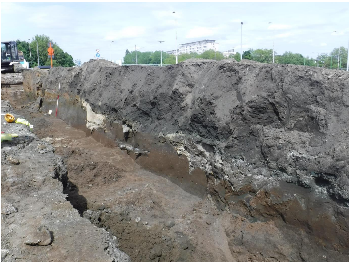
figuur 20 Overzicht van profiel 3 (WP1). Grote losse zandpakketten met daarin grote losse natuursteenblokken dekken een bruine, wat meer vaste laag af.
