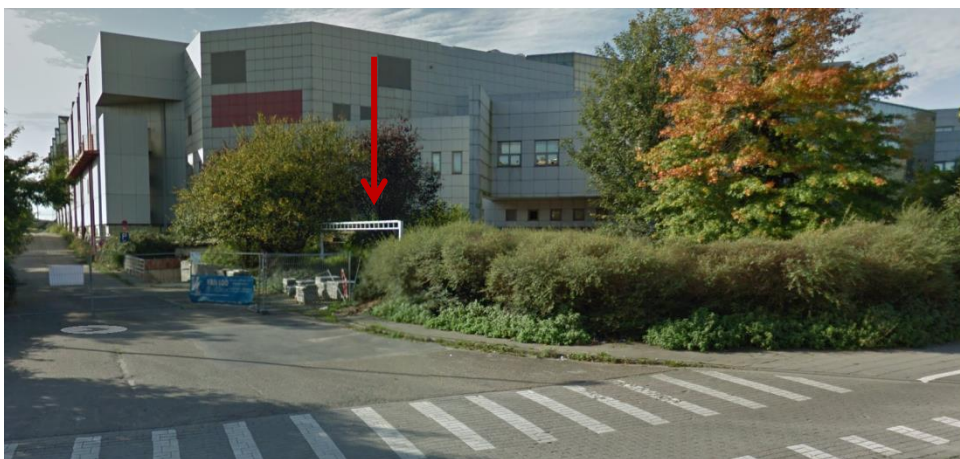
figuur 38 foto van de noordelijke zijde van het voormalige postgebouw met centraal de inrit van de parkeergarage (rode pijl).
