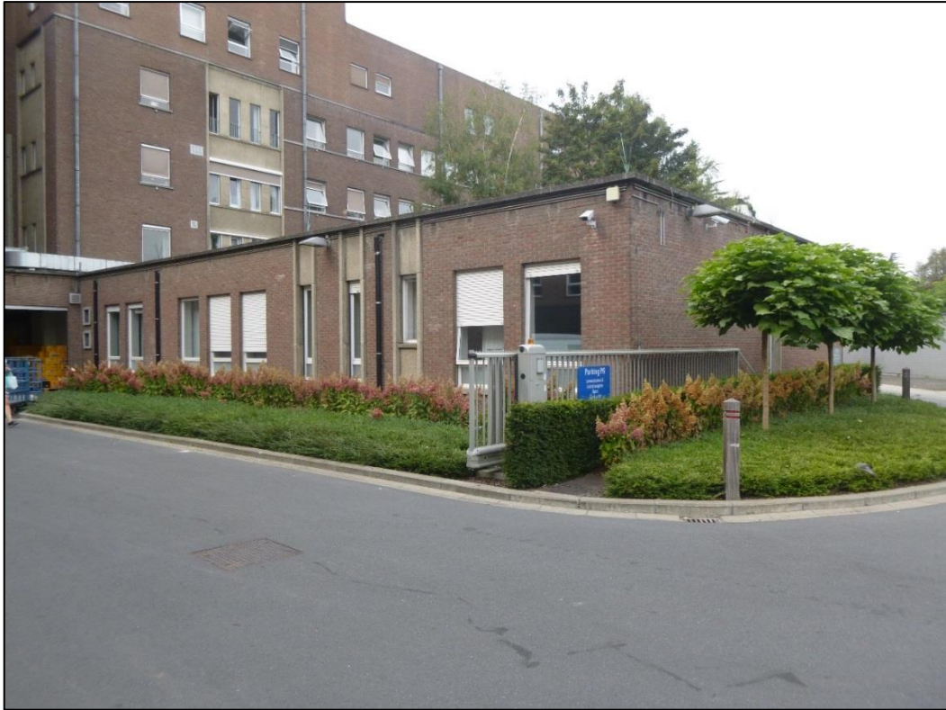
Figuur 3: Blok C: Buitenaanzicht BLOK C; (foto's genomen op 15/09/2016 door Pedro Pype)
