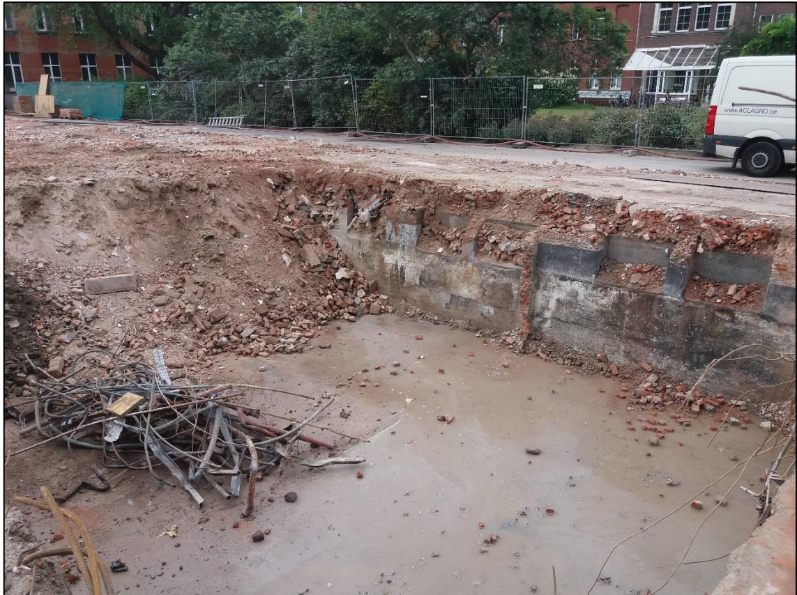
Figuur 59: De hoge verstoringsgraad in werkput 5 met kelders, kabels en diepe funderingen
