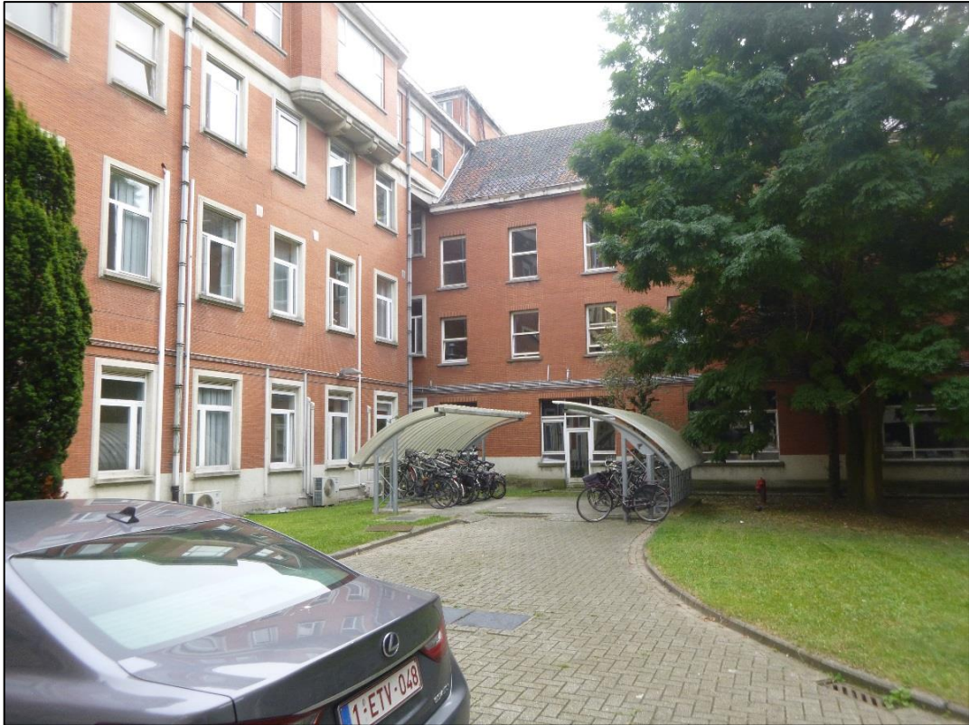
Figuur 4: Buitenaanzicht BLOK W (vanop binnenkoer Ziekenhuis); (foto's genomen op 15/09/2016 door Pedro Pype)
