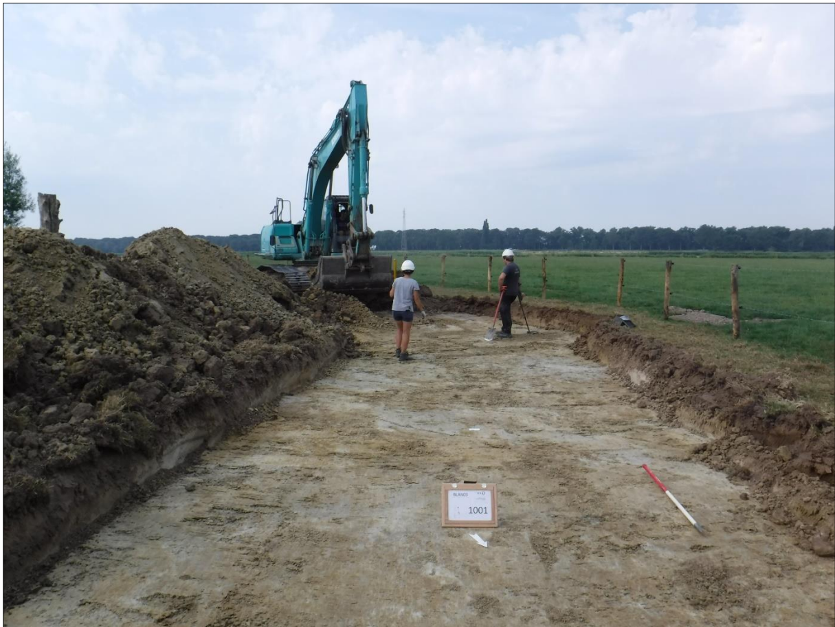
Figuur 7: Aanleg van de opgravingsput ter hoogte van pompgemaal 5.
