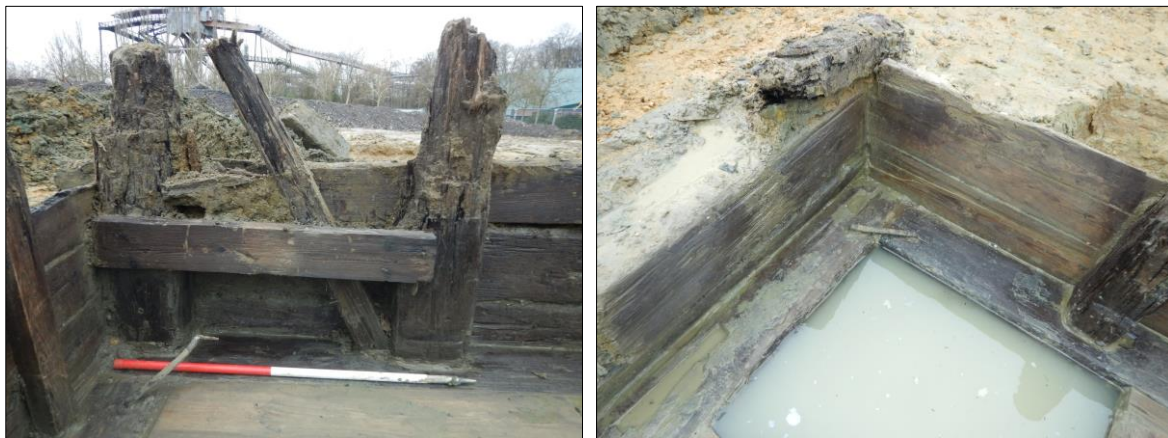
Figuur 43: Detailweergaven van de hoekconstructie en het gebruik van ijzeren bouwankers bij schuilplaats S24 te Bellewaerde – Meenseweg (bron: RAAP België bvba).
