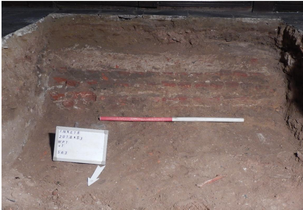
Figuur 35: Getrapte baksteenfundering van de toren.
