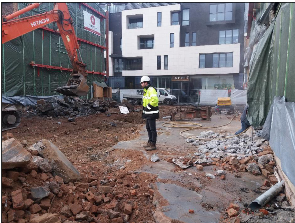
Figuur 9: Algemeen zicht op het onderzoeksgebied tijdens het verwijderen van de vloerplaat (ABO nv 2019)
