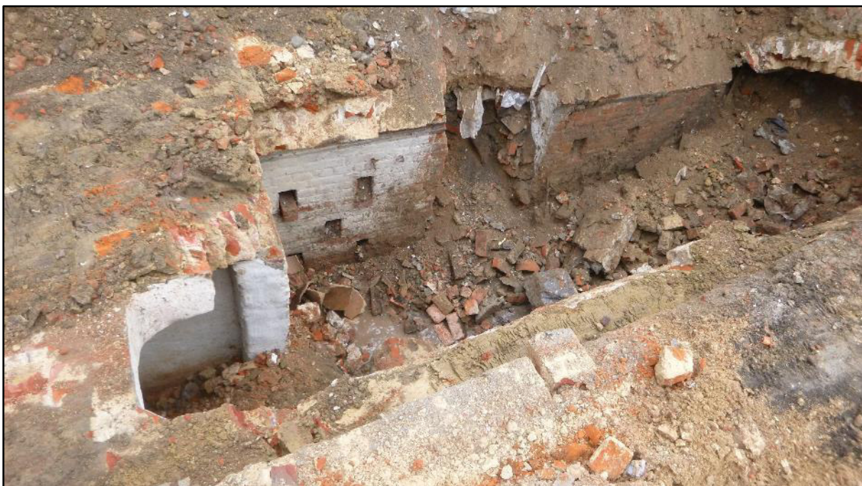
Figuur 22: De westelijke zijde van de kelder na het verwijderen van het gewelf (ABO nv 2019)
