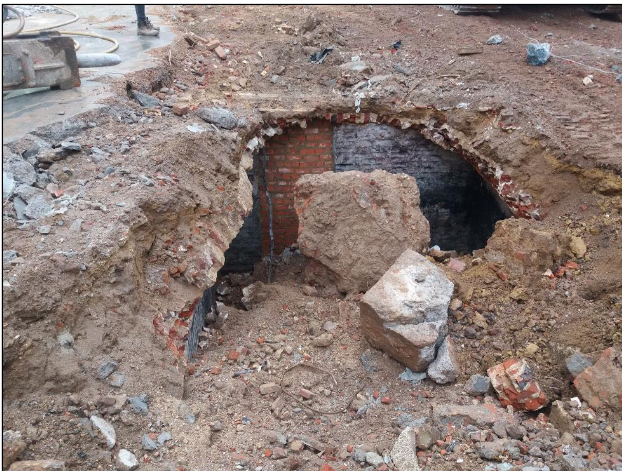
Figuur 10: Algemeen zicht op het onderzoeksgebied tijdens het verwijderen van de vloerplaat en de recente kelder (ABO nv 2019)
