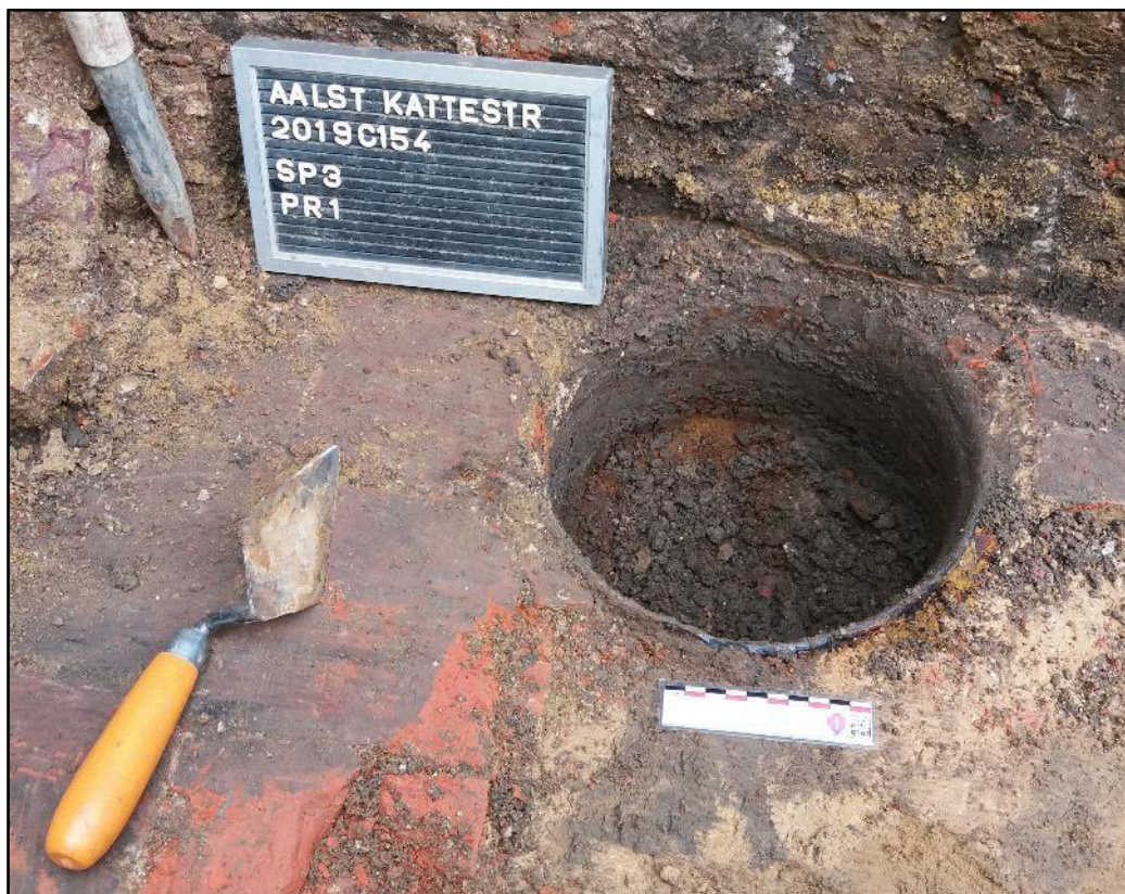
Figuur 19: Detail recipient voor evacueren grondwater (ABO nv 2019)
