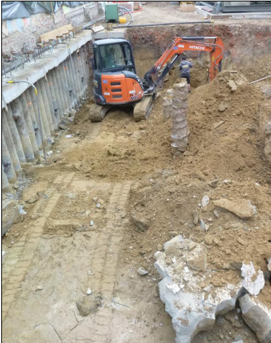
Figuur 59: Algemeen zicht op de bouwput voor de toekomstige kelder na afwerking (ABO nv 2019)
