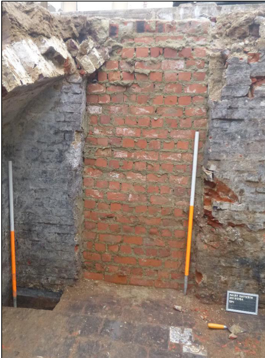
Figuur 13: Dichtgemetselde deuropening in de oostelijke kopse muur (ABO nv 2019)
