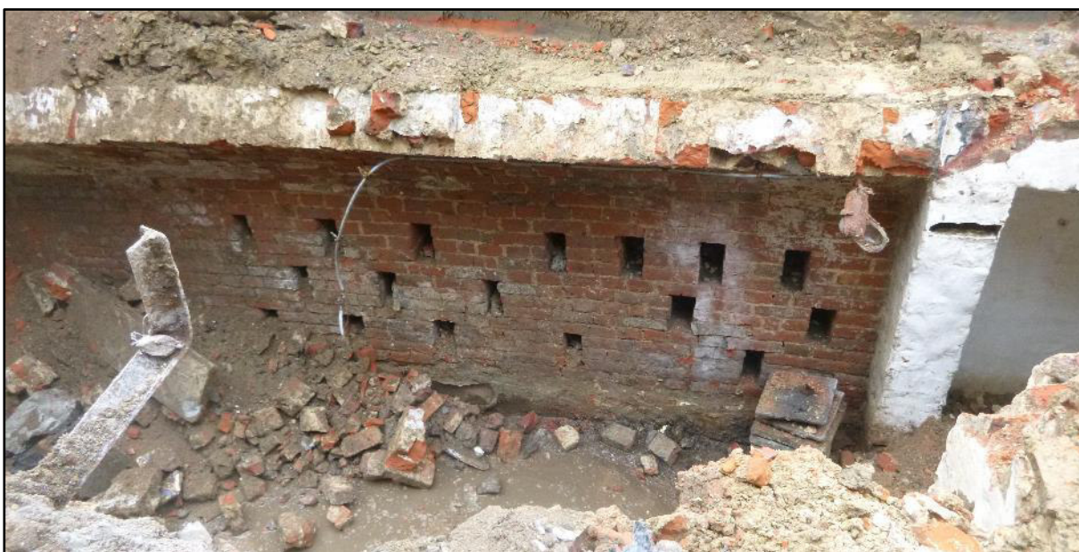
Figuur 23: De oostelijke zijde van de kelder (ABO nv 2019)
