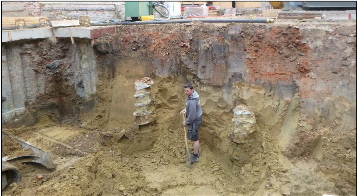
Figuur 6o: Algemeen zicht op de bouwput voor de toekomstige kelder na afwerking (ABO nv 2019)
