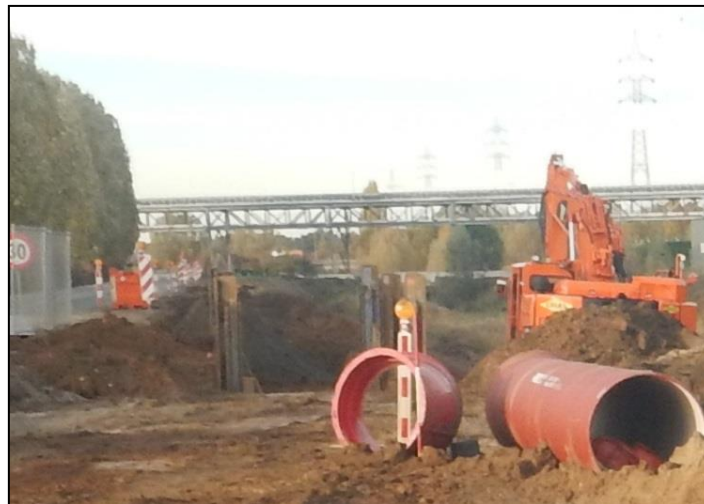
Figuur 7: Uitgraven van de sleuven met verstevigende wanden
