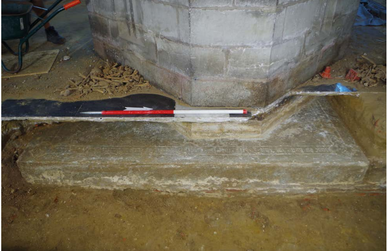
Figuur 124. Detail van de zuil die bovenop een herbruikte grafsteen is geplaatst.
