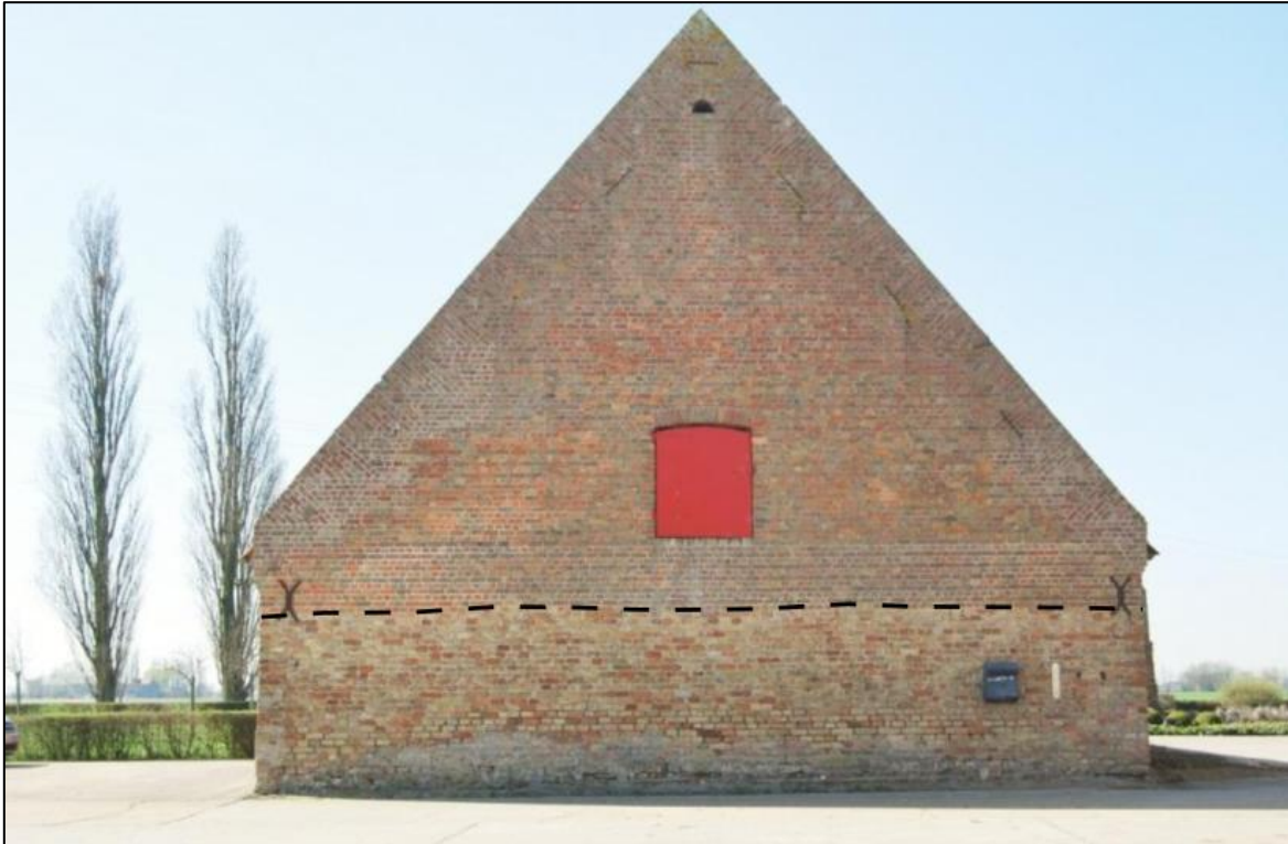
Figuur 17: Foto van oostelijke gevel voor afbraak (de stippellijn duidt de bovengrens van het muurwerk van hergebruikte moeffen aan). 56
