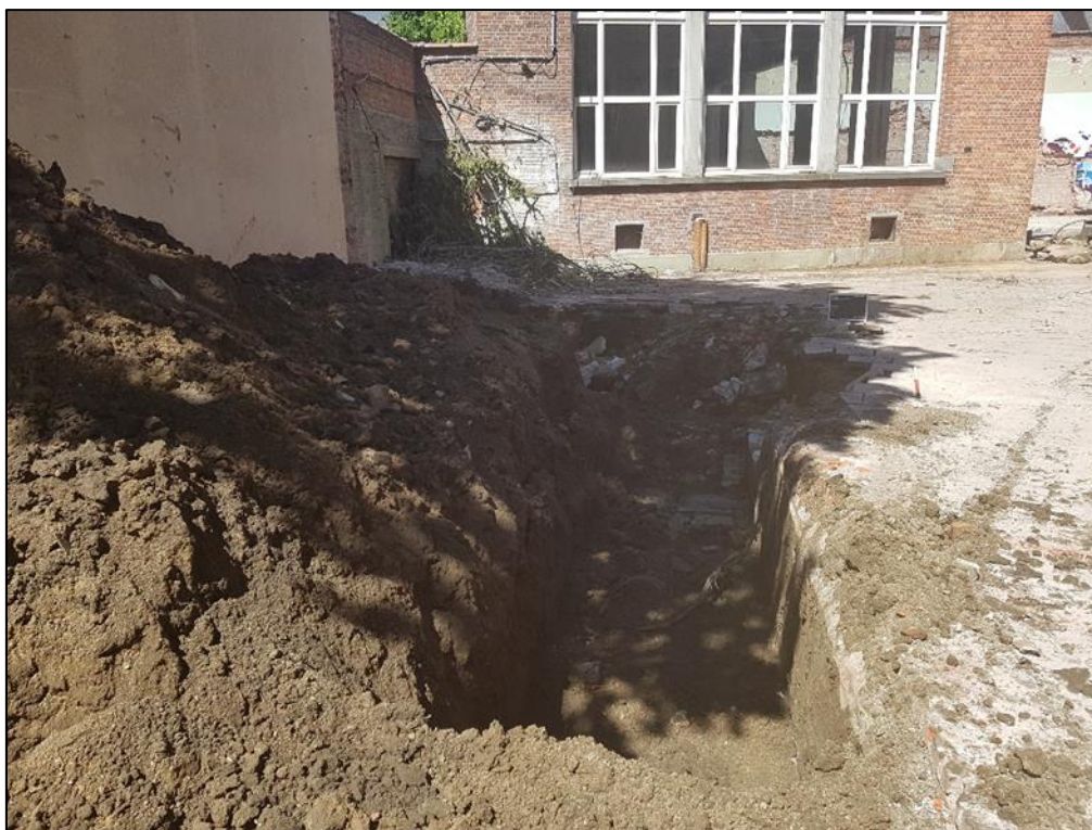
Figuur 7: Overzicht over WP6 met zicht op behouden gebouw in WP7
